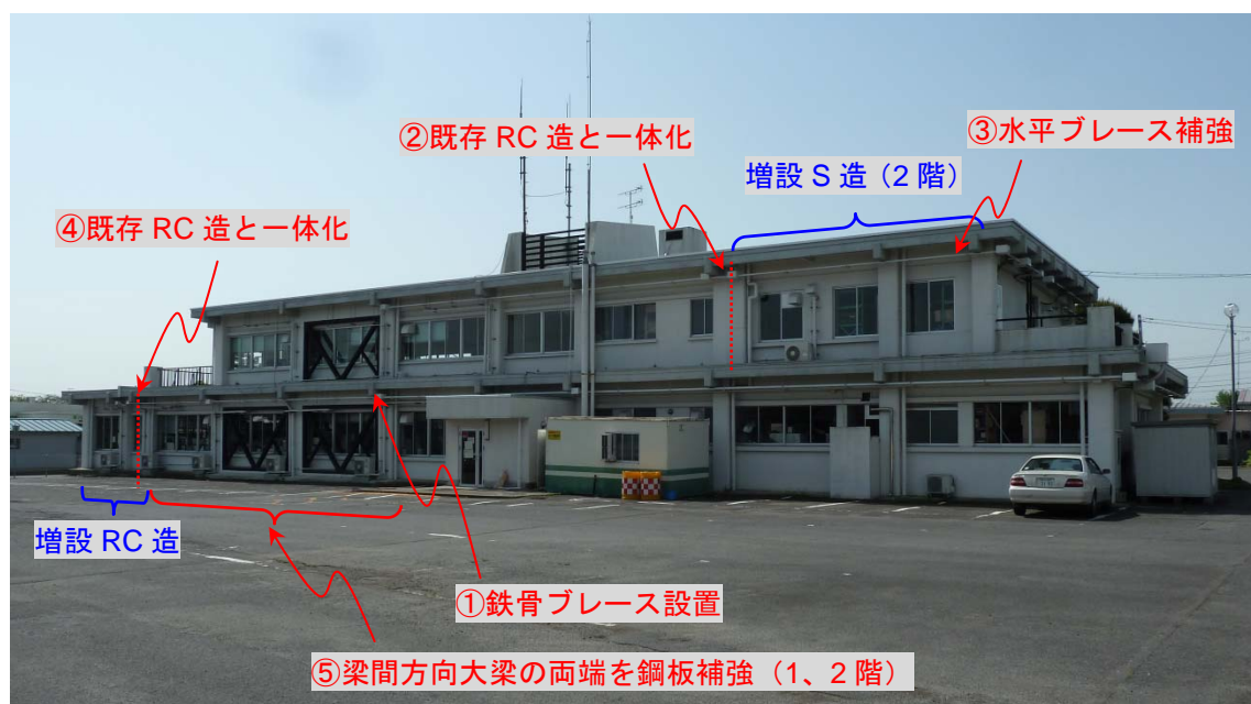
写真 5.2.3.3-1 本建築物外観及び耐震補強概要
