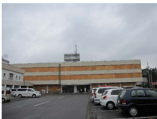
(a) ガラスの落下 (建築物 B)
