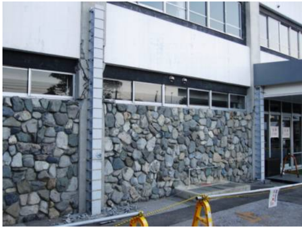
(a) 北側構面の極脆性柱（鉄骨柱応急補強）
