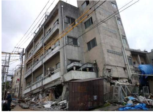
写真 5. 2. 1-1 1階の層崩壊
