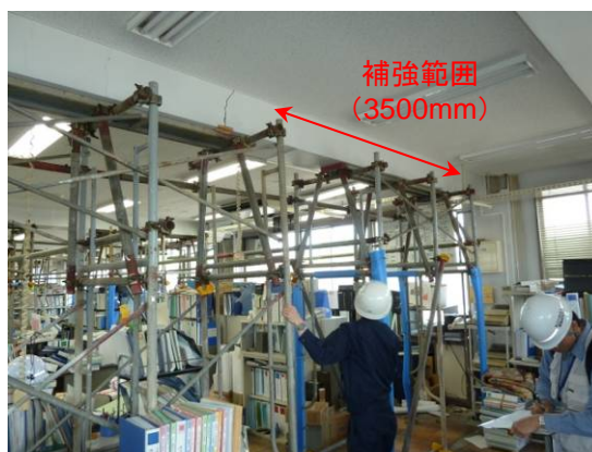
写真 5. 2. 3. 3-2 梁端の鋼板補強
