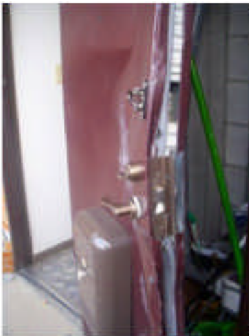
写真 5.4-98 玄関ドアの変形
