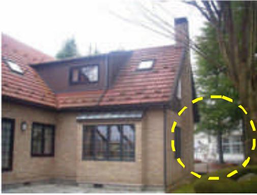
写真 5.4-80 本館（丸印）に隣接する校舎
