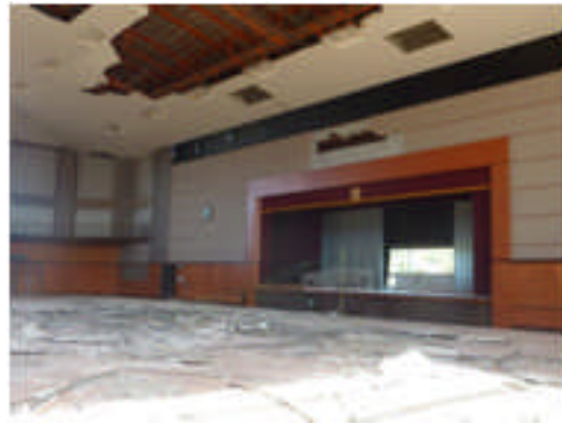
写真 5.4-207 天井の脱落2
