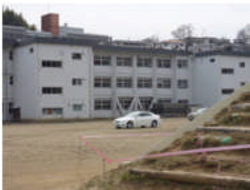
写真 5.4-84 C 小学校校舎外観
