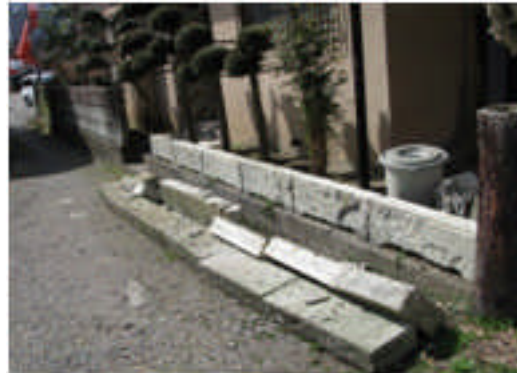
写真 5.4-160 石塀の倒壊
