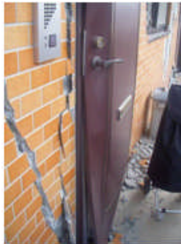
写真 5.4-98 玄関ドアの変形
