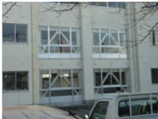
写真 5.4-194 C 中学校の外観
