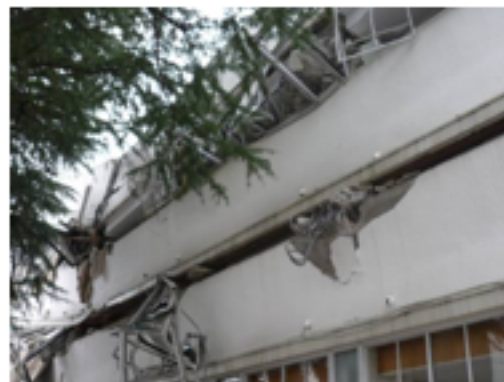
写真 5.4-78 2階崩壊部
