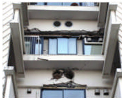
写真 5.4-33 開口付き境界梁の付着割裂破壊 (上階) とせん断破壊 (下階)
