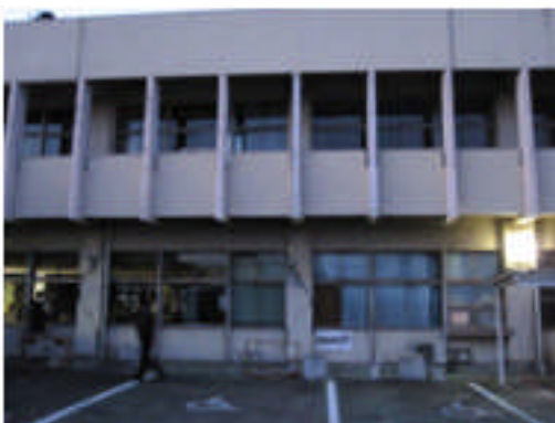
写真 5. 4-199 建築物の被害の外観
