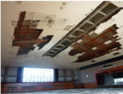
写真 5.4-206 天井の脱落1
