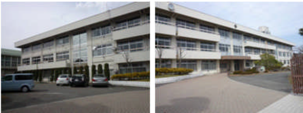
写真 5.4-83 B 高等学校南校舎の外観
