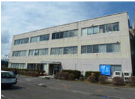
写真 5.4-57 建築物外観 (写真右端で隣棟と接続)
