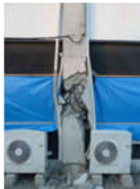
(b) 短柱せん断破壊
