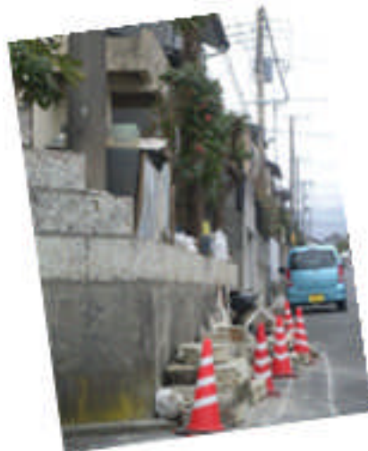
写真 5.4-187 倒壊した塀 2
