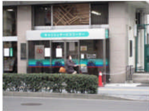
写真 5.4-10 ガラスの割れ
