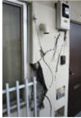
写真 5.4-55 玄関回りの非構造壁の損傷 写真 5.4-56 ベランダ側方立て壁の損傷
