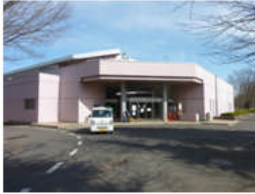
写真 5.4-205 B 体育館の外観
