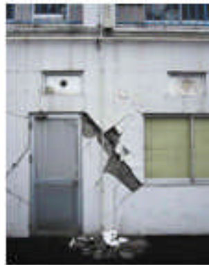
写真 5.4-48 せん断破壊
