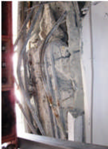
写真 5.4-141 柱段落とし部詳細
