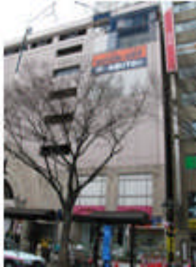
写真 5.4-5 外装材の脱落
