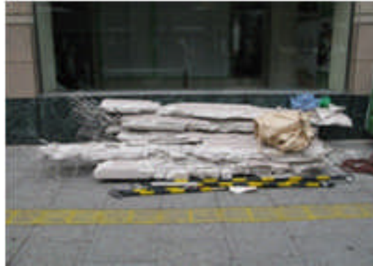
写真 5.4-6 落下したALCパネル
