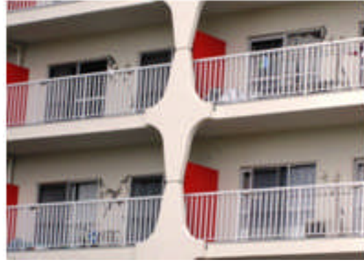
写真 5.4-55 玄関回りの非構造壁の損傷 写真 5.4-56 ベランダ側方立て壁の損傷
