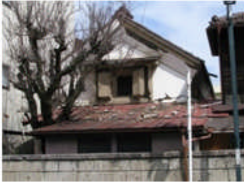
写真 5.4-157 土蔵の被害
