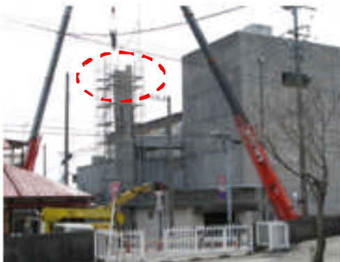
写真 5.4-155 亀裂の入った煙突の上部を解体中
