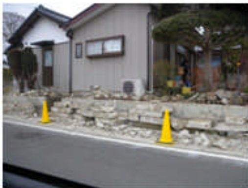
写真 5.4-186 倒壊した塀 1
