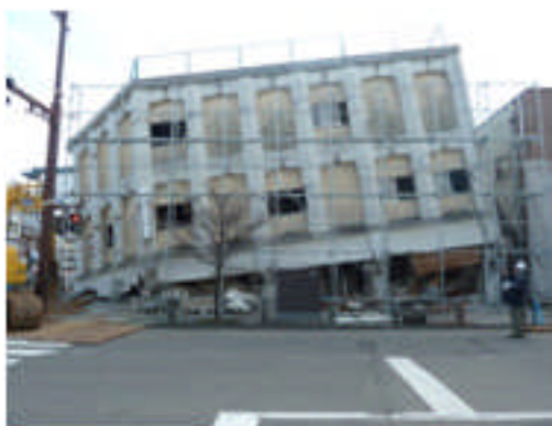
写真 5.4-131 1階の層崩壊
