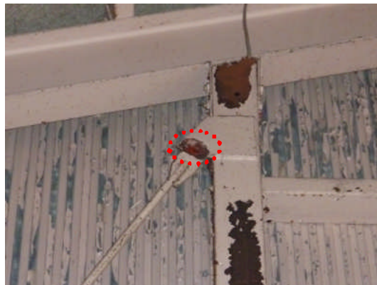
写真 5.3-17 ボルトの破断 (JS0-3)
