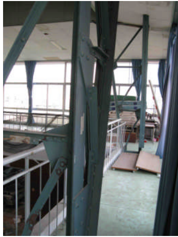
(a) ラチス柱全景
