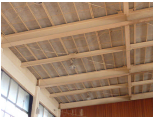
写真 5.3-27 ターンバックルのたわみ(MIT-25)
