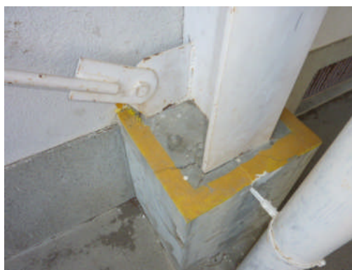
写真 5.3-34 亀裂 (MIT-22)
