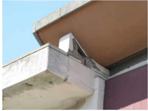
写真 5.3-24 外部の屋根支承部(MIT-26)
