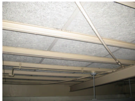
写真 5.3-26 ターンバックルのたわみ (MIT-27)
