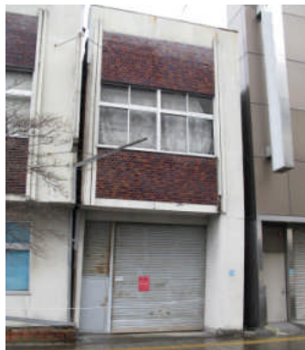
写真 5.3-4 1階の残留変形（仙台市若林区）
