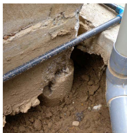
写真12 建物角部の支持構造物
