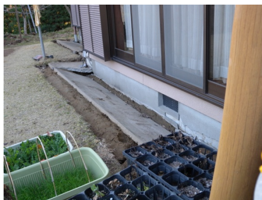
写真 3 8 基礎部分外観
