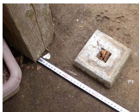
写真10 物置柱脚の移動
