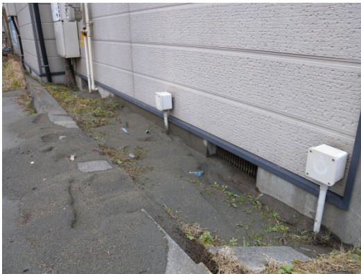
写真31 基礎部分の外観（1）
