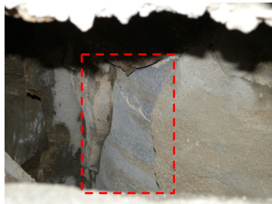
写真23 杭周固定液の内部
