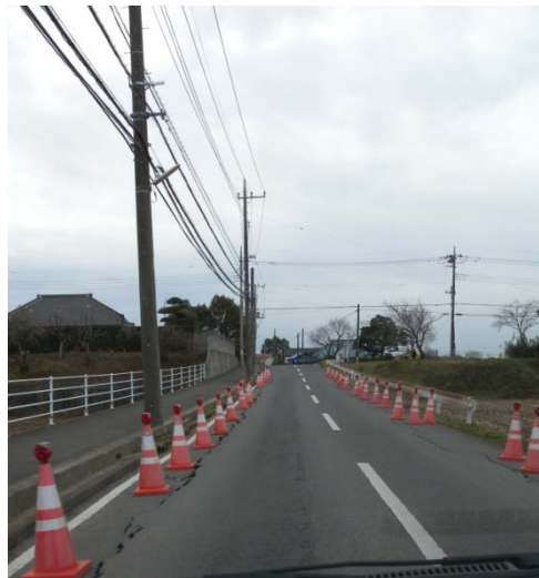
写真2 路盤の亀裂
