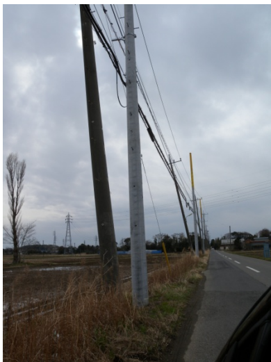
写真1 電柱の傾斜 (復旧中)
