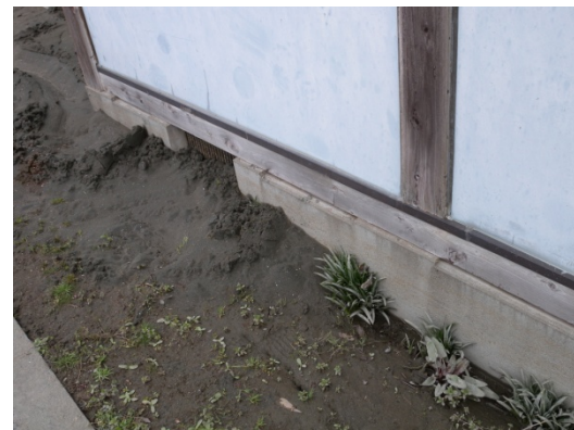
写真32 基礎部分の外観（2）
