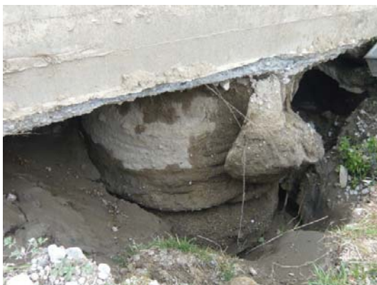
写真22 杭頭部の露出状況
