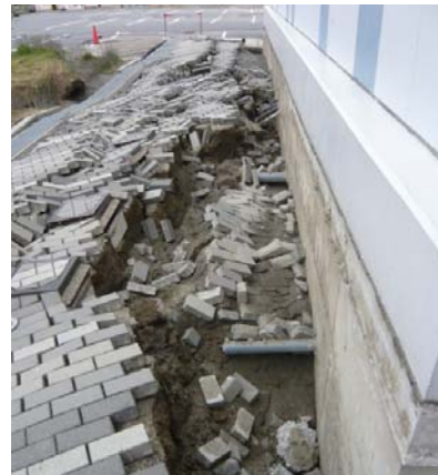
写真21 建築物周囲地盤の状況
