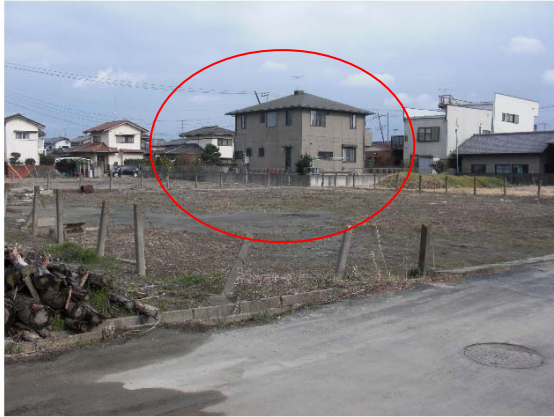
写真3-3 液状化の発生していない住宅
