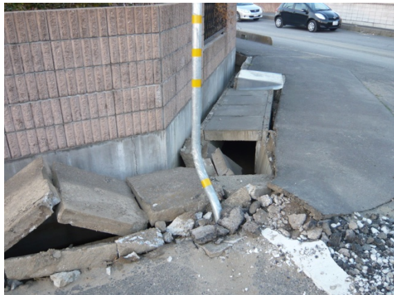
写真 4 0 側溝の被害
