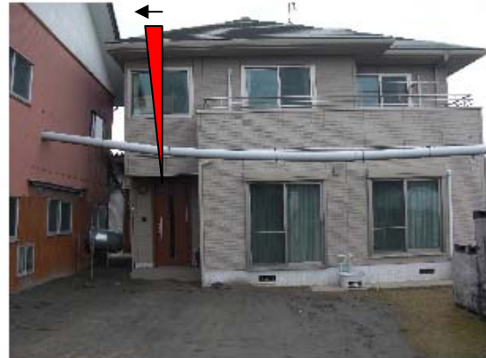
写真 2 5 傾斜した住宅
