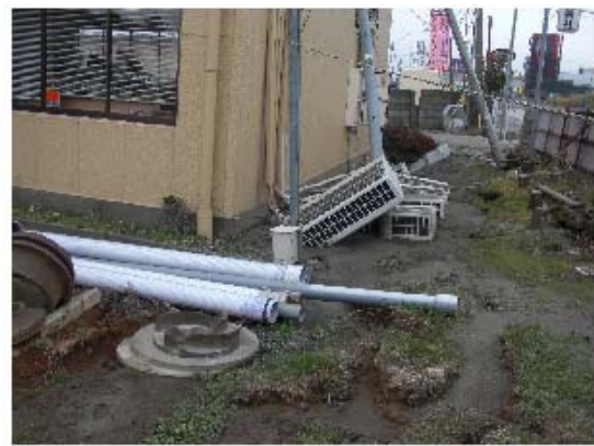
写真16 写真15の周囲の変状 (右側が県道11号)
