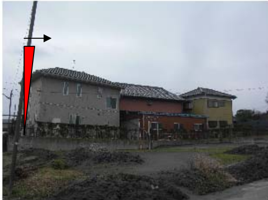
写真 2 4 建物外観（左端が大きく傾斜した住宅）
