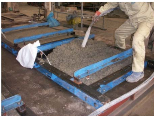
コンクリート打設状況 1
