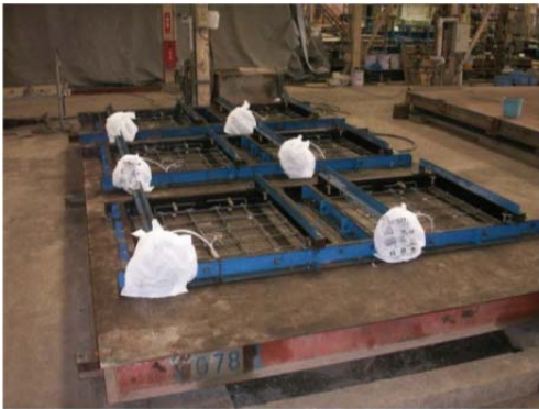
コンクリート打設前型枠状況
