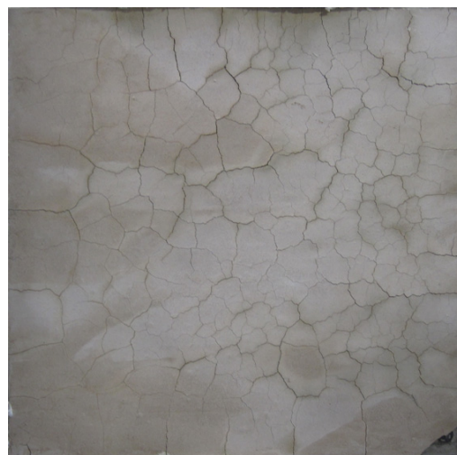
写真-3.2.12 耐火試験後の状況(No. 10) [E3-B] (耐火試験後の損傷状態…I : ひび割れ)
