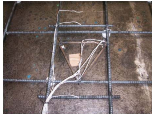
熱電対設置状況 1
