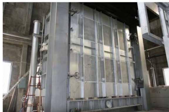
(b) 設置状況
