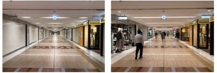
■図5 地下街の営業時間外(左)と営業時間内(右)の誘導灯(写真中央のやや上)の見え方
