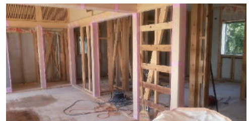
■写真3 令和2年7月豪雨での洪水により倒壊した家屋 (熊本県球磨村内)
