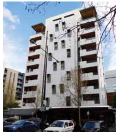
写真10 CLTによる10階建て共同住宅（1階RC造、オーストラリア・メルボルン）
