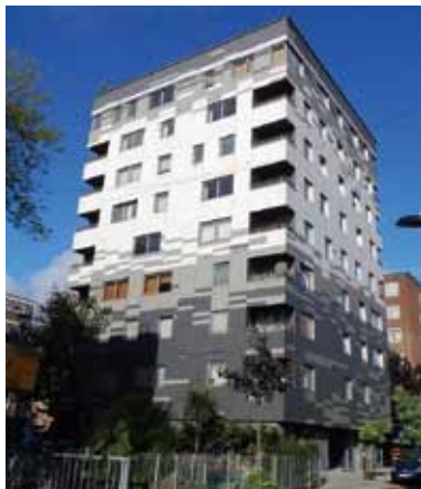
写真9 CLTによる9階建て共同住宅（1階RC造、イギリス・ロンドン）
