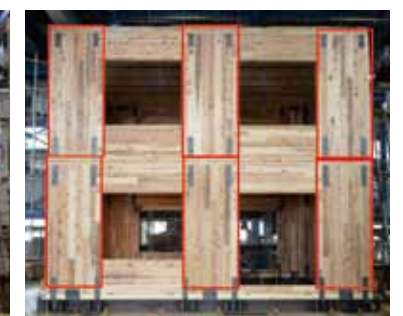
図4 小幅パネル工法
