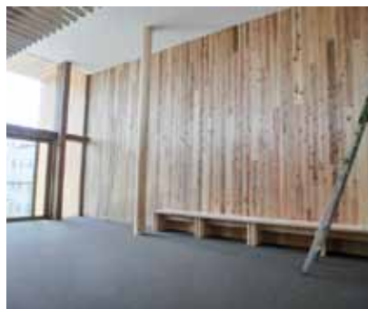
写真16 6mの通し壁による開放的な空間
