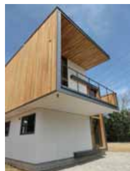
写真17 3mの片持ち（カンチレバー）のバルコニー
