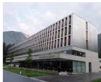
写真13 1,2階RC造とした5階建て宿泊施設（オーストラリア・ロイテ）
