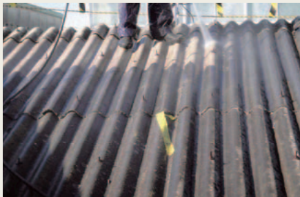
アスベスト含有成形板の洗浄状況
