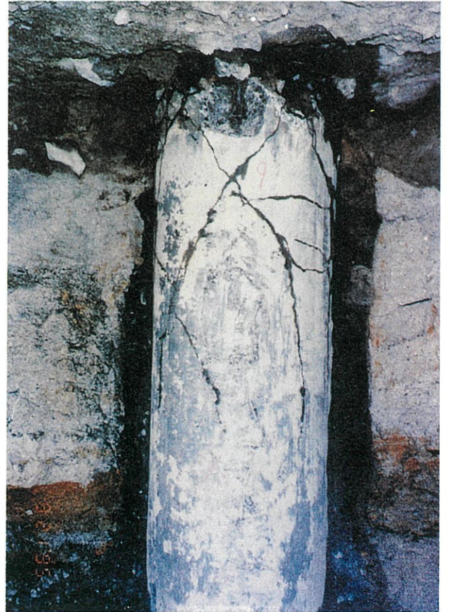
損傷度 V
