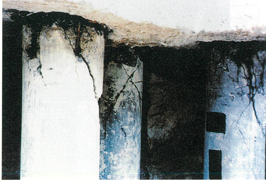
損傷度 V
