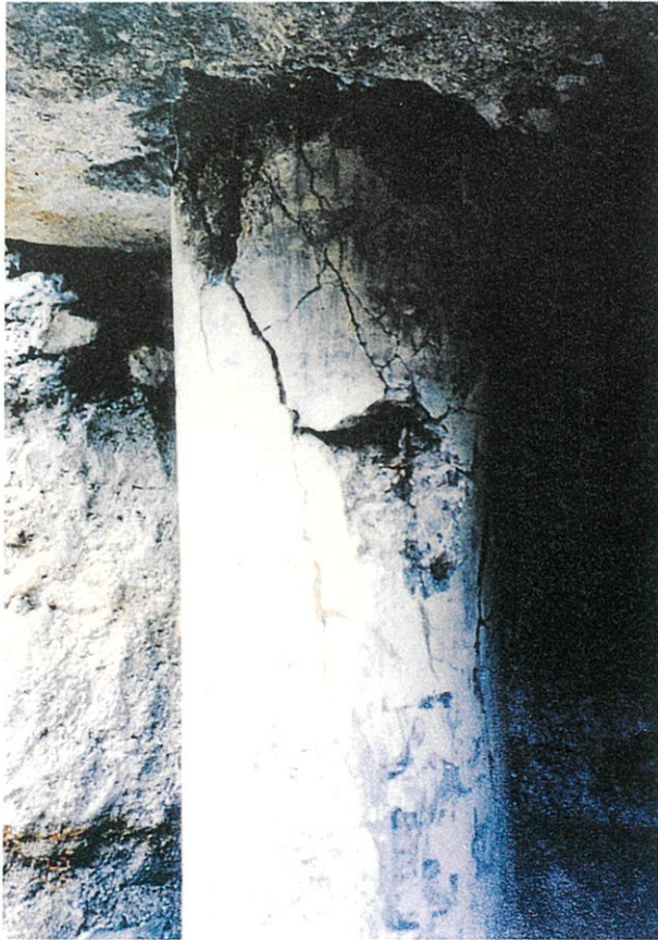
損傷度 V
