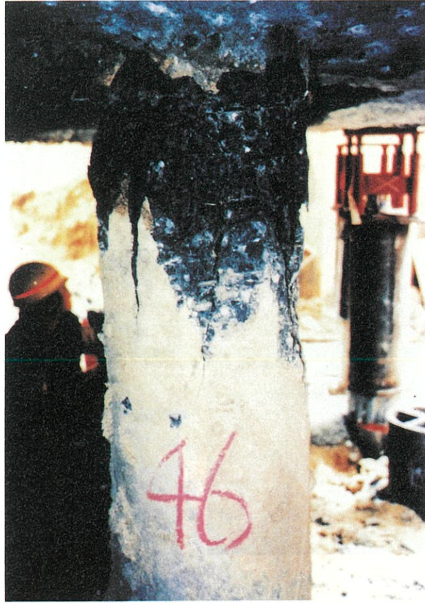
損傷度V
