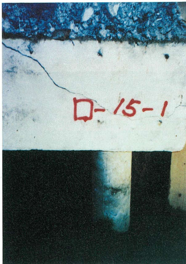
基礎スラブの被災例
