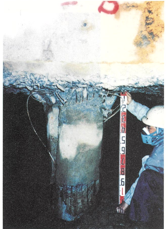
杭の被災例(損傷度V)
