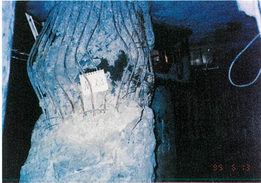
損傷度 V
