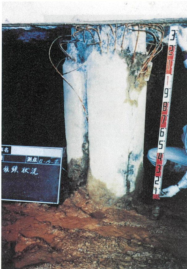
杭の被災例(損傷度V)
