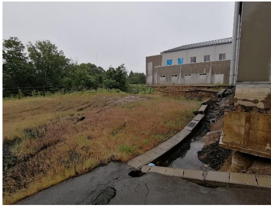
写真 5.4.2-44 E 中学校体育施設周囲地盤の変状に伴う被害
