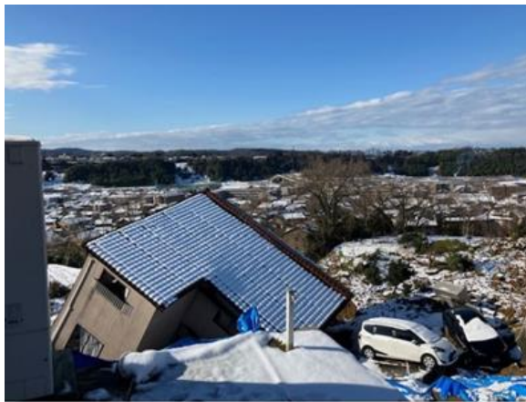
写真 5.4.2-1 崩壊した斜面の状況①
