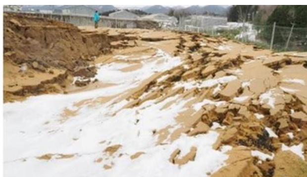
写真 5. 4. 2-43 校庭の地割れ
