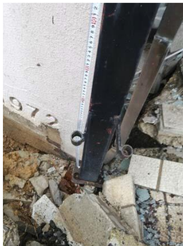
写真 5. 4. 2-47 Hホテルの地盤被害の状況
