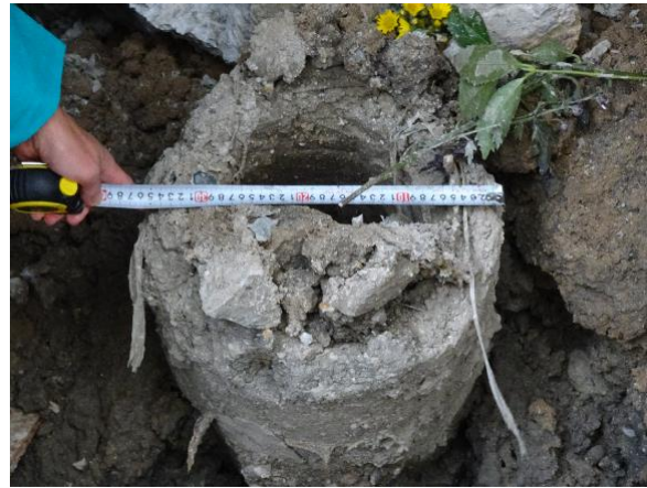
b) 杭の寸法形状の確認状況
