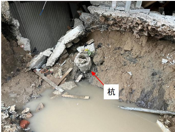
a) 地表面の状況
