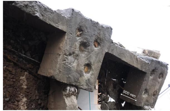
写真 5. 4. 2-14 パイルキャップ
