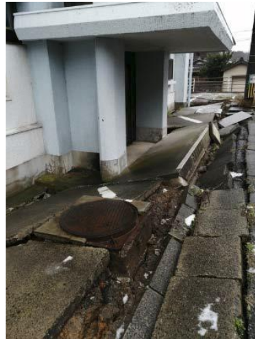
写真 5. 4. 2-46 G住宅の地盤被害の状況
