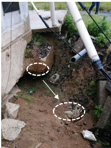
写真 5. 4. 2-48 I住宅の地盤被害の状況
