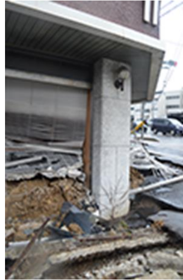
b) 南東隅柱
