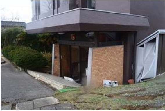
写真 5. 4. 2-9 正面入口付近の状況（沈下）
