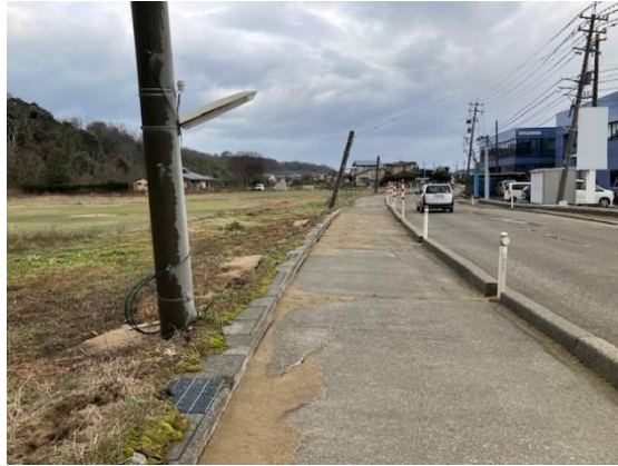
写真 5.4.2-6 県道 8 号の状況 (写真左側が砂丘であり、県道 8 号沿いは砂丘に隣接する低地)
