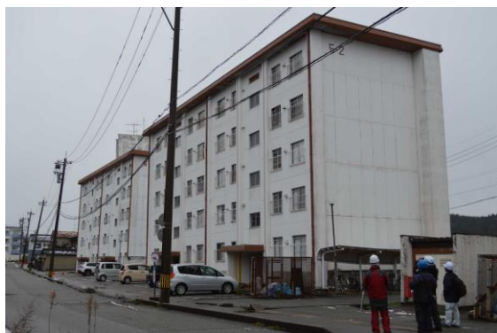
写真 5. 4. 2-39 川側（紙面の奥向き）への傾斜 （左側の建物）
