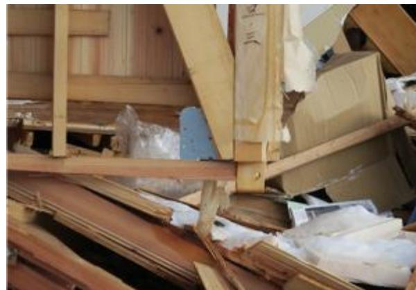
写真5.2.2-45 写真5.2.2-44の筋かい端部の金物
