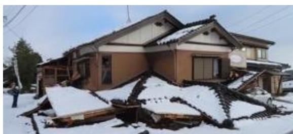
写真5.2.2-48 1層が崩壊した木造住宅
