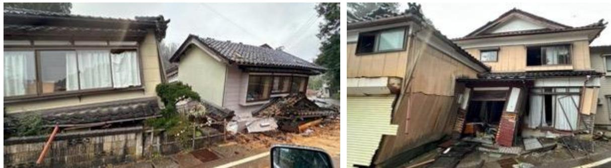
写真5.2.2-29 珠洲市役所前以外で倒壊を含む大きな被害を受けた家屋（珠洲市上戸町）
