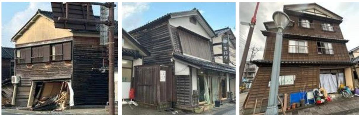
写真5.2.2-2 一部は安全限界変形を超えるような大きな残留変形のある家屋
