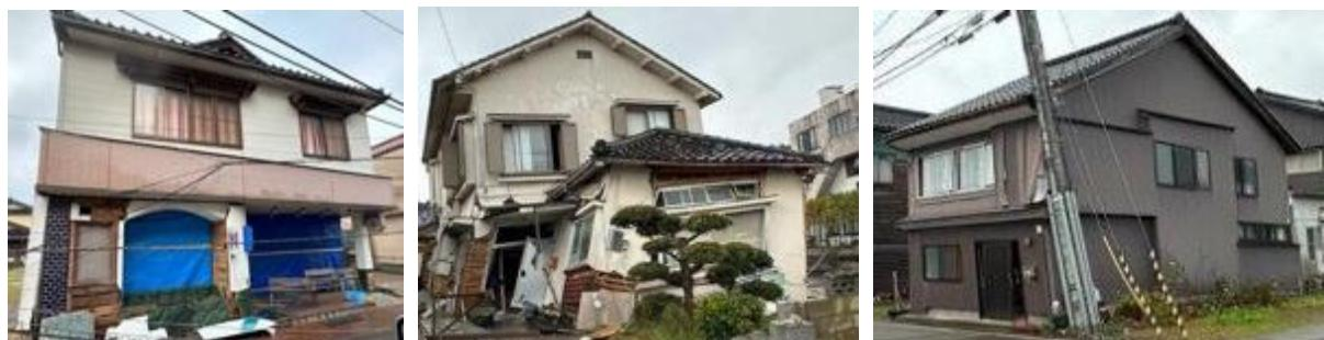
写真5.2.2-30 一部は安全限界変形を超えるような大きな残留変形のある木造家屋（珠洲市飯田町）
