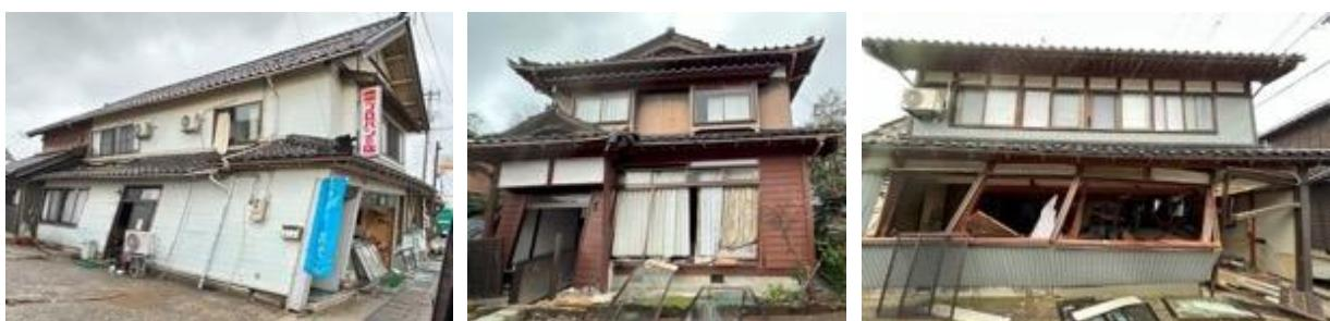
写真5.2.2-34 珠洲市正院町正院で一部は安全限界変形を超える大きな残留変形が残る家屋
