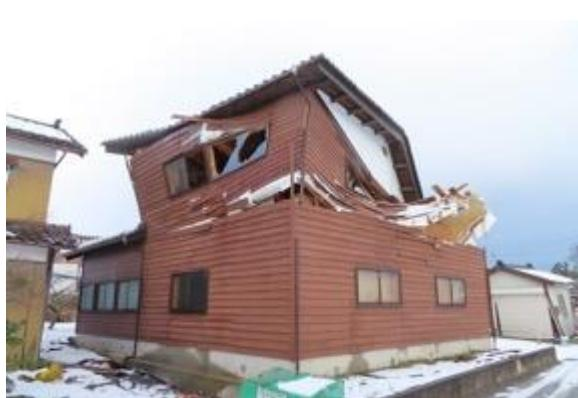
写真5.2.2-50 2層が崩壊した木造住宅
