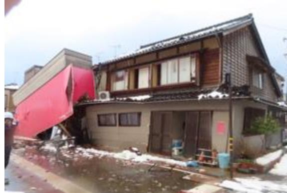
写真5.2.2-65 倒壊した木造店舗併用住宅
