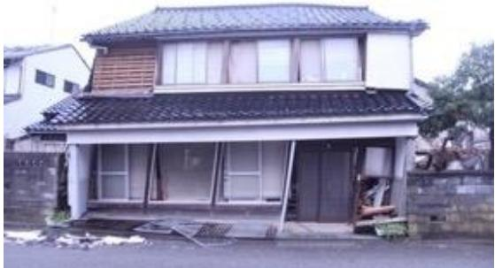
写真5.2.2-82 大きく傾斜した木造住宅
