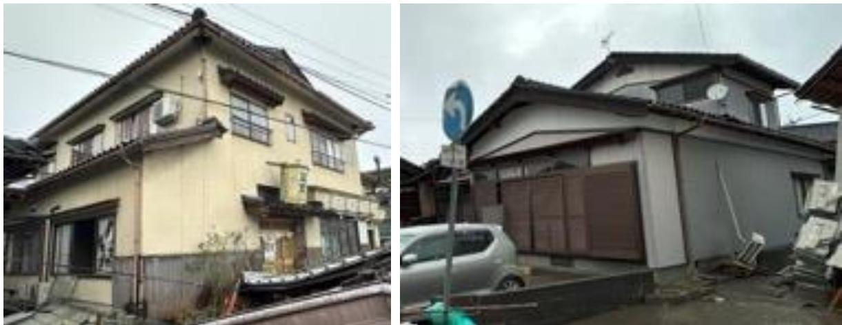
写真5.2.2-40 比較的建築年が古い割に被害が軽微な木造家屋
