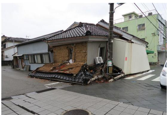
写真5.2.2-80 倒壊した木造住宅
