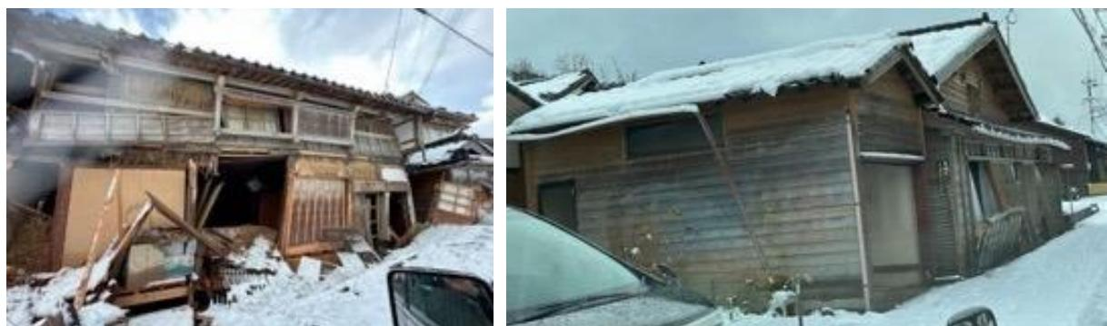
写真5.2.2-26 一部は安全限界変形を超えるような大きな残留変形がある家屋（門前町黒島）
