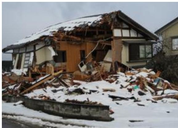
写真5.2.2-44 倒壊した木造住宅
