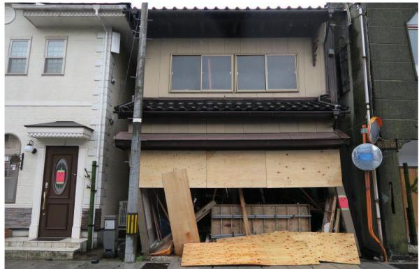
写真5.2.2-81 大きく傾斜した木造店舗併用住宅
