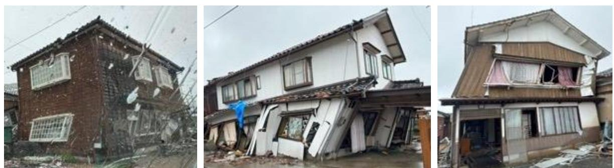
写真5.2.2-37 安全限界変形を超える残留変形がある家屋（珠洲市宝立町鵜飼）
