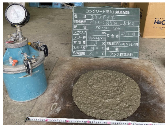
写真 3.1.2-3 柱 コンクリート受入れ調査記録 (打設日 2020 年 9 月 3 日)
