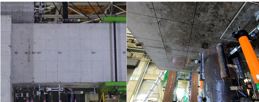
図・写真 3.2.3-21 試験体 DR-2 ひび割れ状況 (1Cycle)
