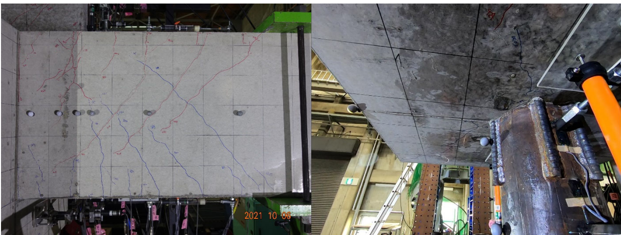
図・写真 3.2.3-26 試験体 DR-2 ひび割れ状況 (6Cycle)
