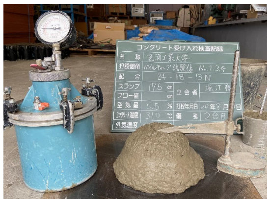
写真 3.1.2-2 パイルキャップ、基礎梁 コンクリート受入れ調査記録 (打設日 2020 年 8 月 31 日)
