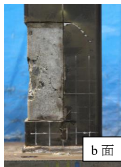
(i) b面柱脚部 内部コンクリート
