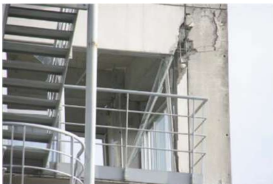
(g) 本震後の5階柱梁接合部の損傷 (Ya1 構面, 図 3.2.4 における G 部分)
