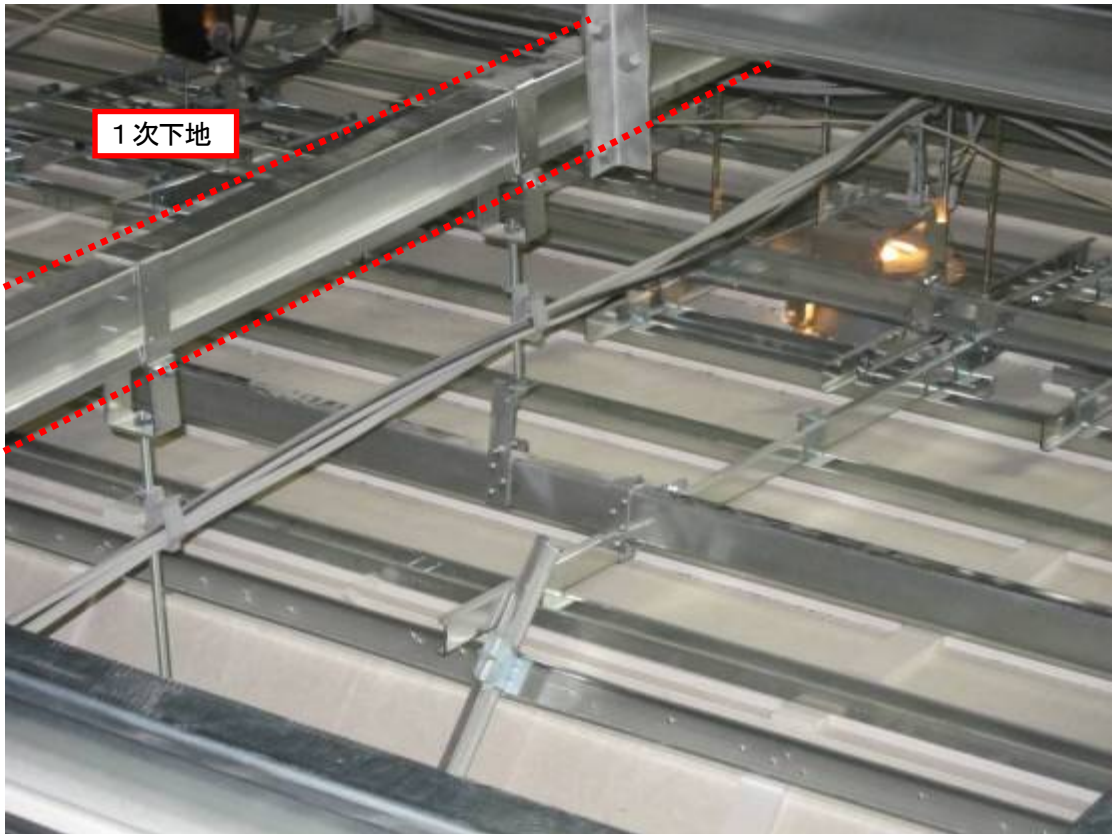
写真D.1 天井詳細写真
