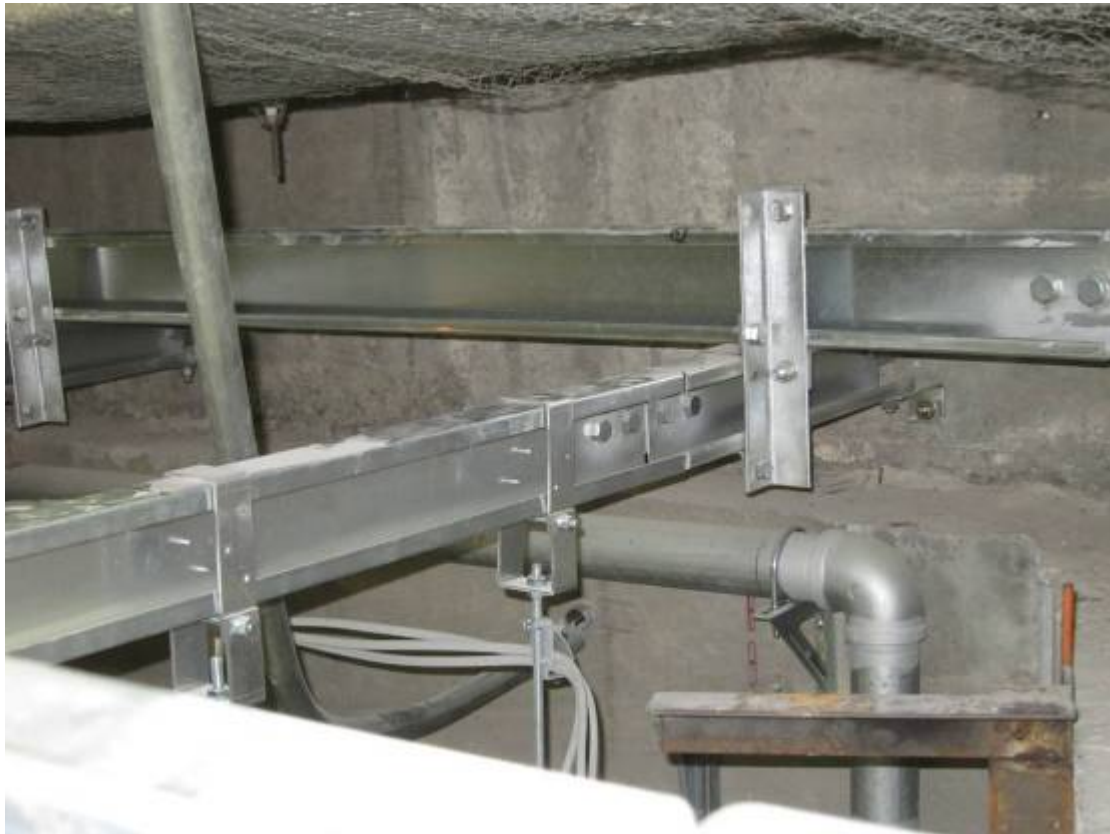
写真D.3 天井詳細写真
