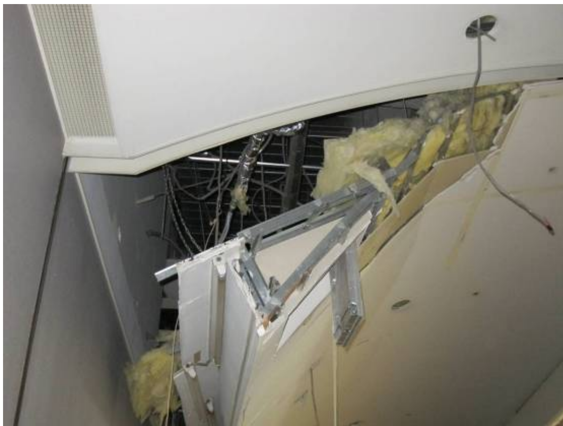
写真 H.4 上記天井の曲面天井の端部
