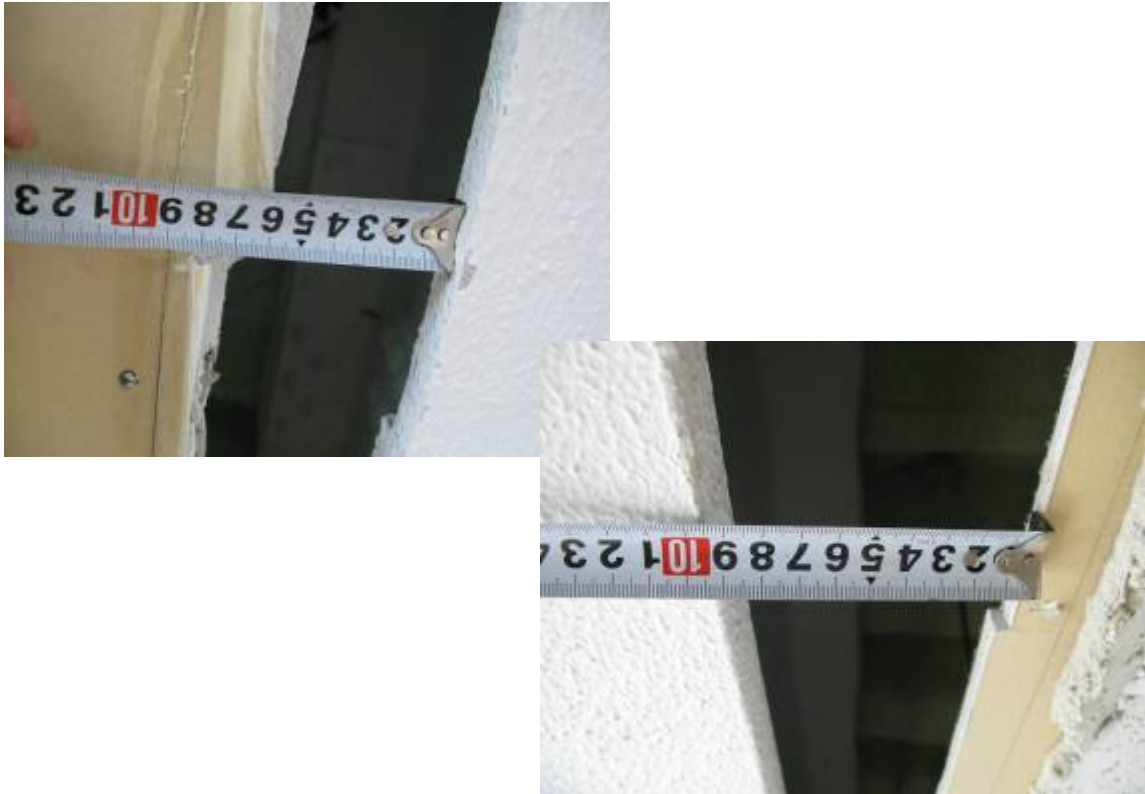
写真E.7 天井面と梁下フランジとのクリアランス（天井の野縁方向）
