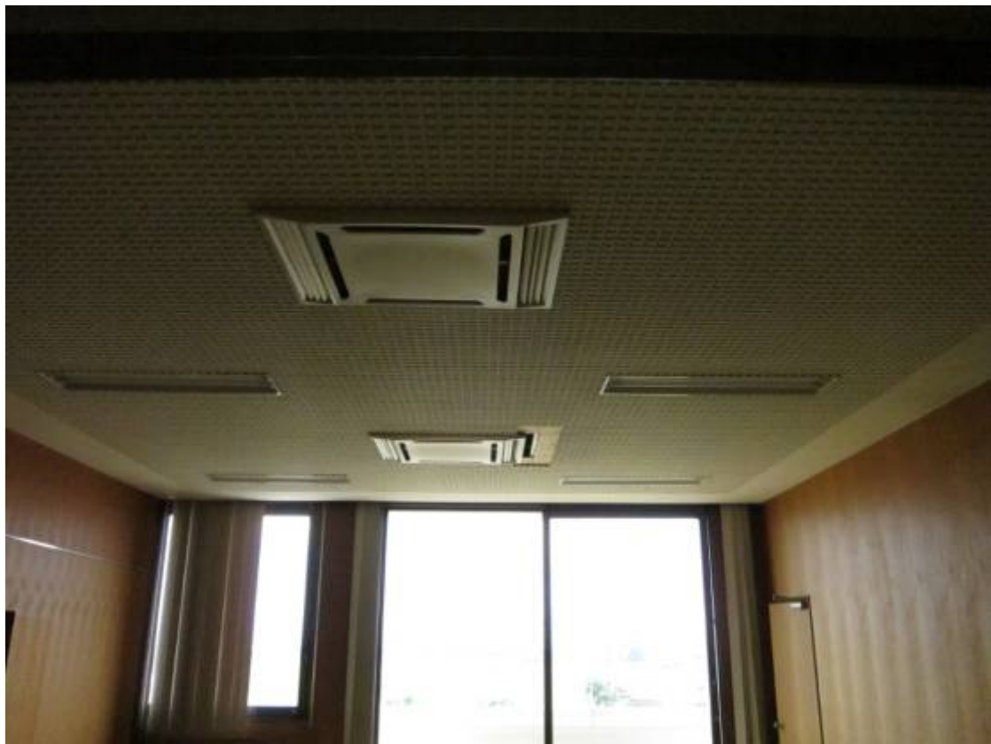
写真 I.6 3階議場の2つ隣の室の状況
