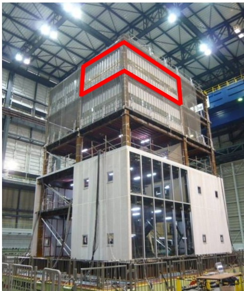
写真 5.2 実大5層鉄骨造試験体
