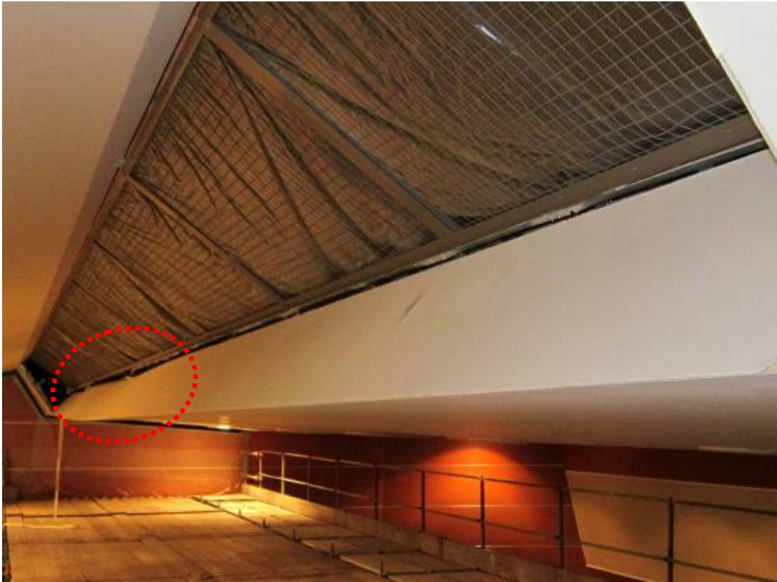
写真D.5 シーリングスポット室下での天井の垂れ
