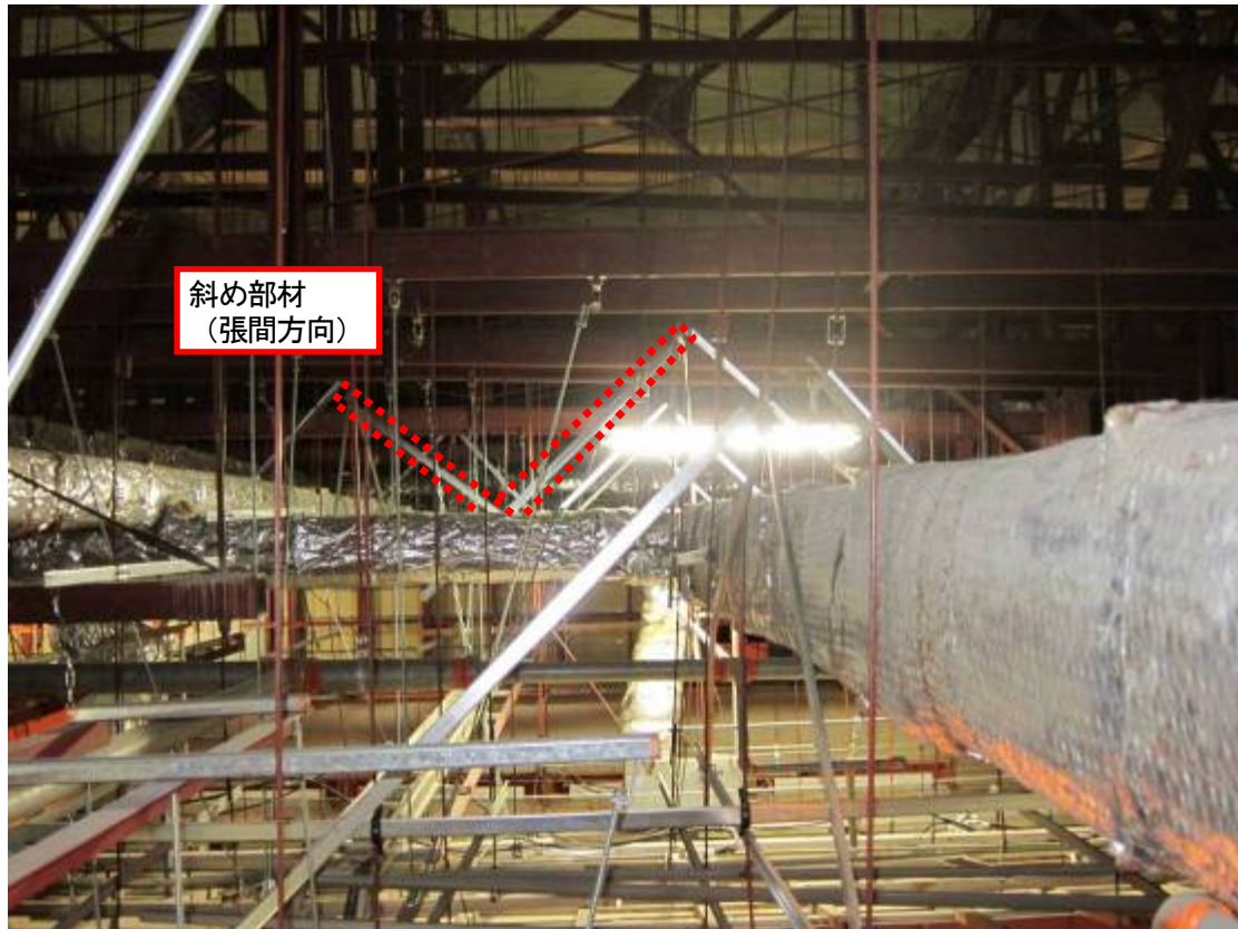
写真 J. 5 大ホールの天井裏の様子
