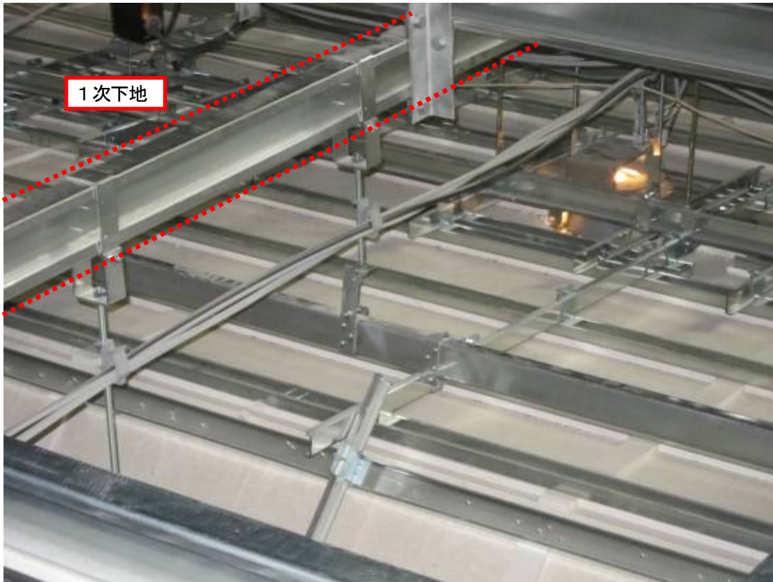
写真D.1 天井詳細写真
