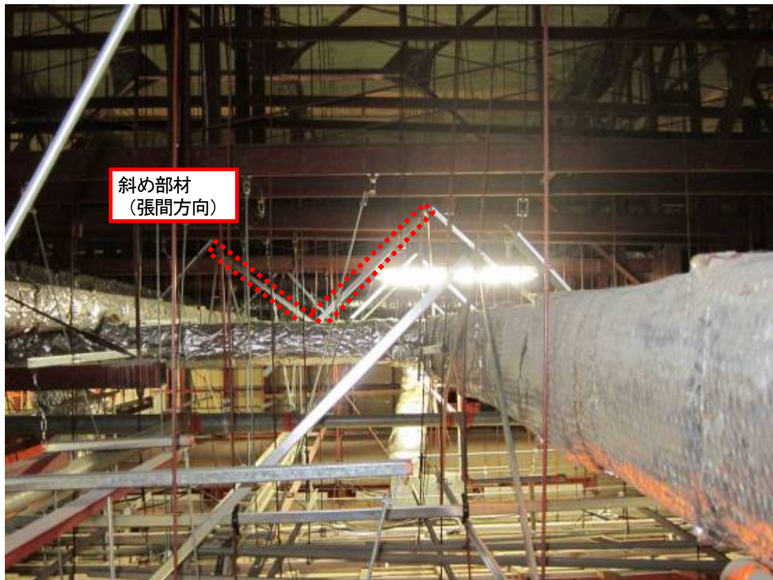
写真 J. 5 大ホールの天井裏の様子
