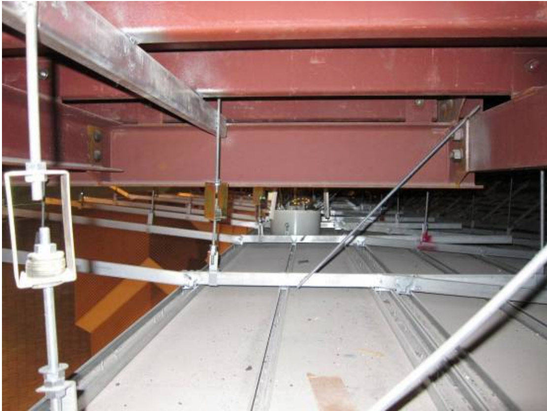
写真C.3 シーリングスポット室下の天井の詳細
