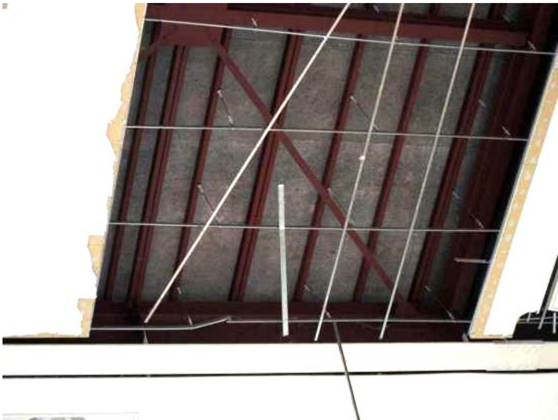
写真 F.2 天井下地の状況（勾配天井の中間部）
