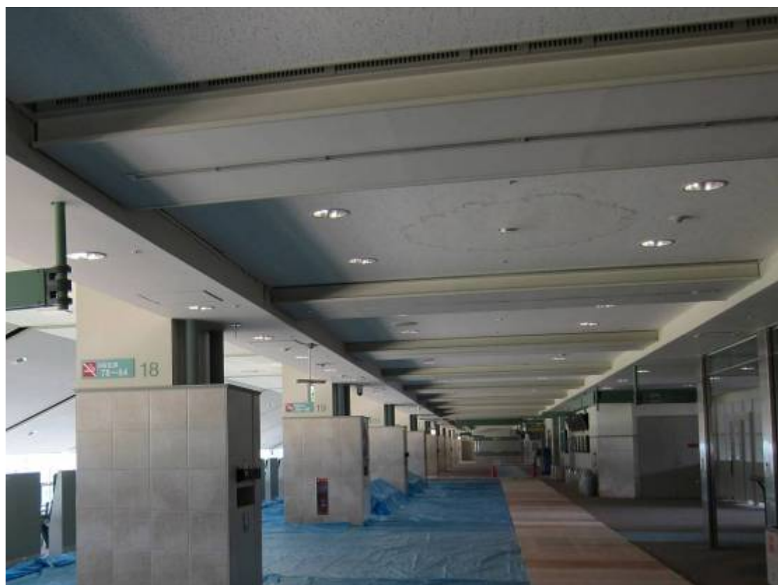
写真 H.8 4階通路の天井
