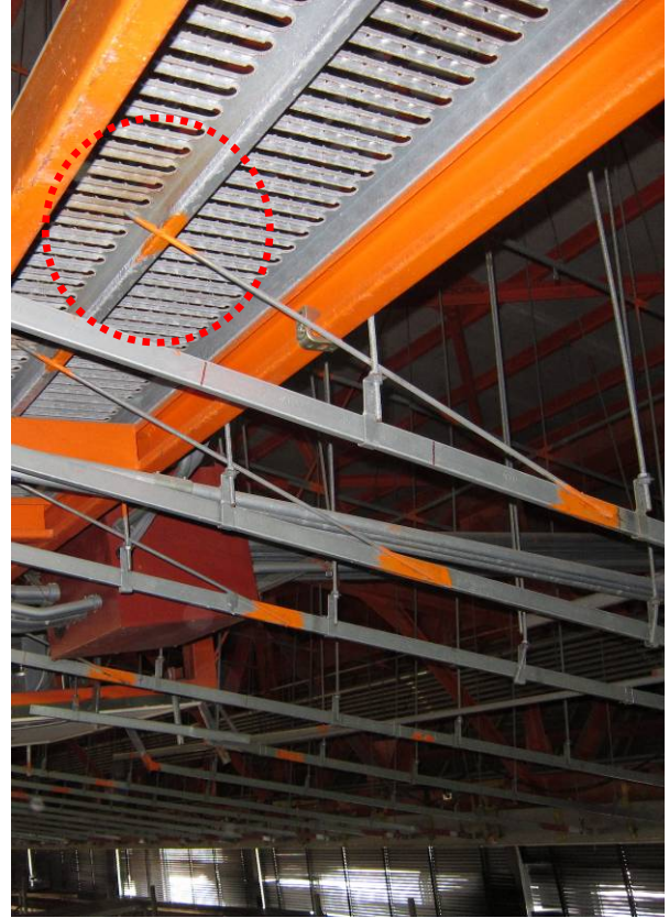
写真 B.4 天井中程の状況（北側） （斜め部材をキャットウォーク下部に溶接）
