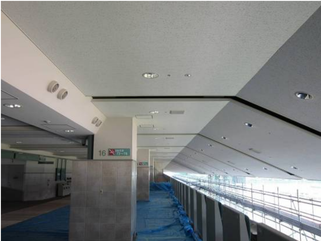
写真 H.6 4階の脱落被害を生じていない天井
