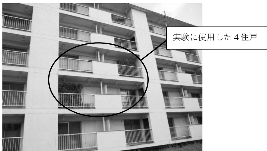
写真 4-1 実験に用いた住棟
