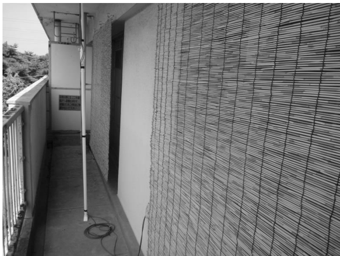
写真 1-6 407 号室 スダレを設置
