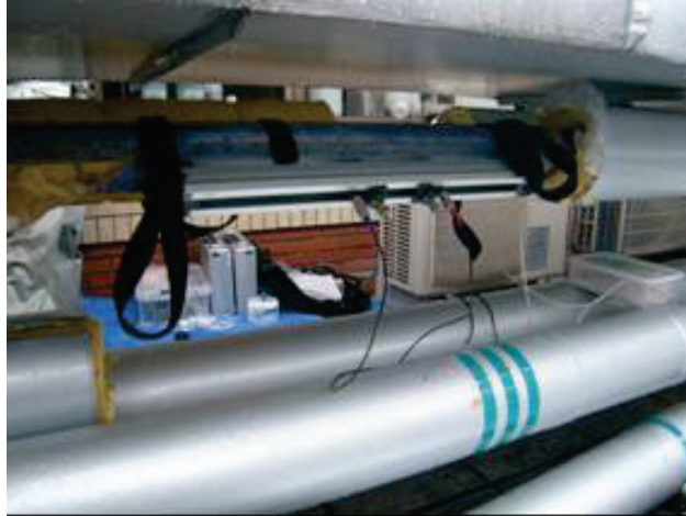
図IV.2.2.3 超音波流量計による冷温水配管流量測定状況（断熱材復旧前）
