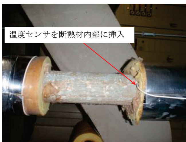
図IV.2.2.4 配管表面温度測定状況（断熱材復旧前）
