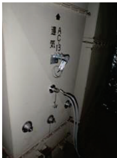
図Ⅲ.2.2.6 ダクト内温度測定状況
