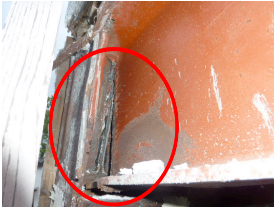
写真 5. 4-27 梁端破断
