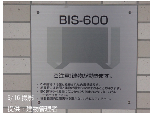
写真 5.7.2-8 出入り口周辺における免震表示 (右図は左図囲みの表示内容の拡大)
