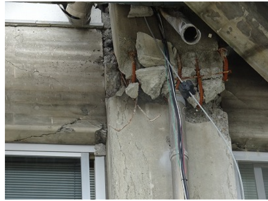
写真5.5-195 4階柱-5階梁接合部
