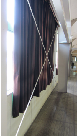
写真 5.4-111 2階鉛直ブレース
