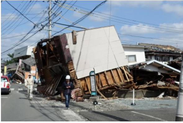
写真 5.3-6 倒壊した店舗併用木造住宅
