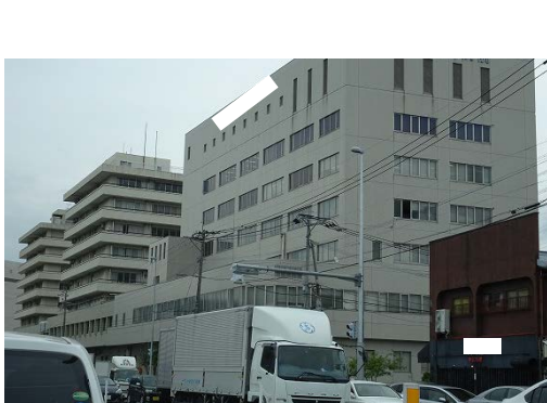
写真5.5-105 外観 (写真奥から北側病棟、南側病棟、管理棟)
