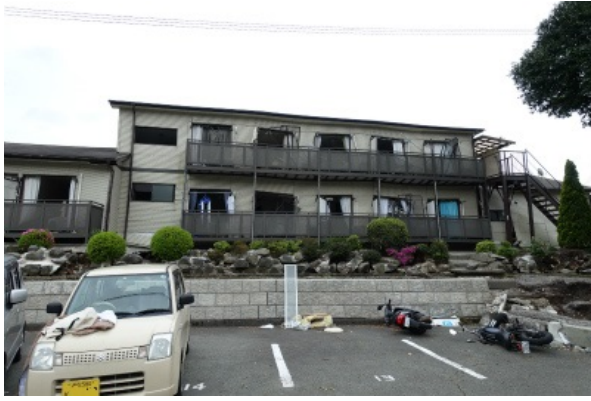
写真 5.3-62 大破した木造アパート
