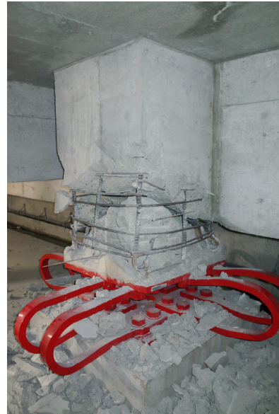
写真 5. 7. 2-54 鋼材ダンパー取付け基部の損傷②（南東部）
