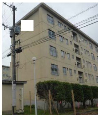
(a) 建築物北東面
