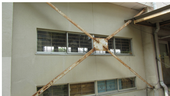
写真 5.4-63 1階鉛直ブレース（被害なし）
