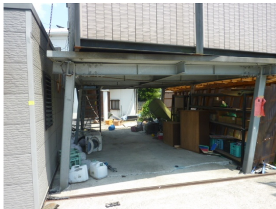
写真 5. 4-40 柱の傾斜
