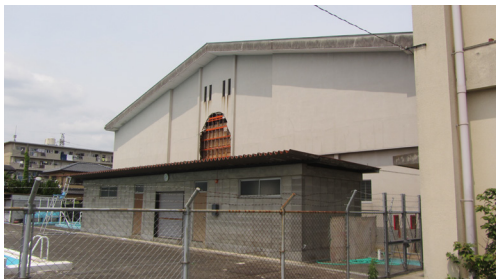
写真 5.4-61 外観（外壁の被害は写真 5.4-69, 5.4-70 参照）
