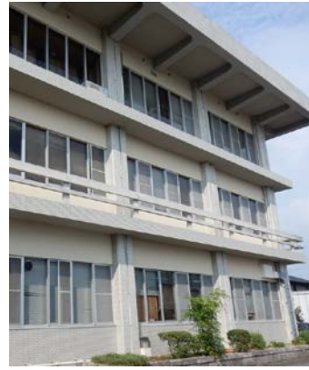
写真5.5-179 3F 外周部の手すりの撤去
