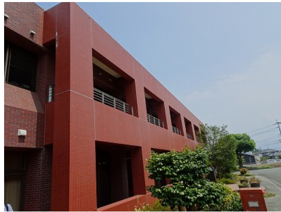
写真5.5-165 外付けフレーム側面
