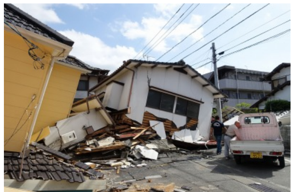
写真 5.3-13 倒壊した木造住宅
