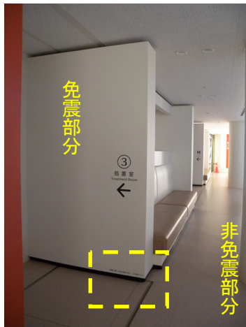
写真 5.7.2-8 出入り口周辺における免震表示 (右図は左図囲みの表示内容の拡大)
