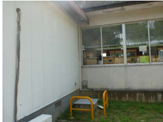
写真5.5-278 地震計設置状況
