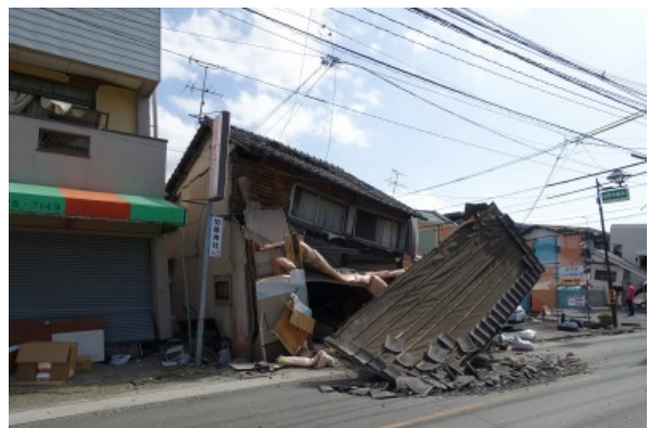
写真5.3-5 倒壊した木造住宅
