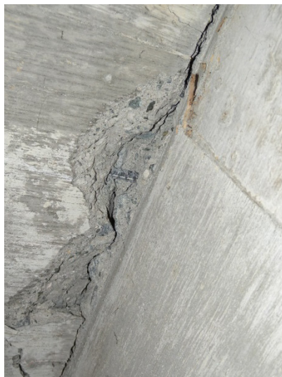
写真 5. 7. 2-41 階段下に設置された積層ゴム支承の取り付け基部の損傷 (左図は右図囲みの拡大)
