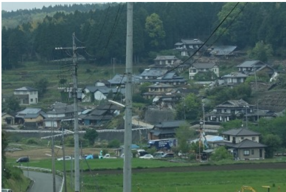
写真 5.3-32 古閑地区の遠景
