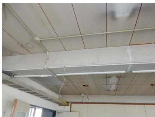
写真5.5-273 大梁のスパン中央付近のひび割れ
