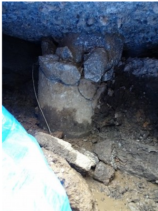
写真5.5-160 庁舎棟南西側コンクリート杭
