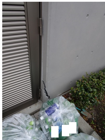
写真5.5-128 外壁端部のひび割れ
