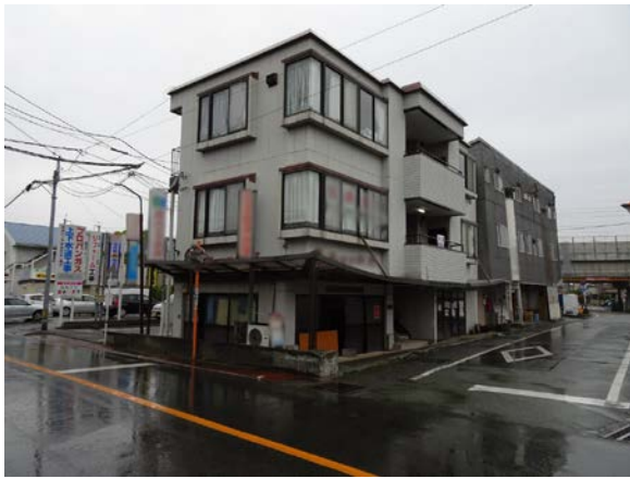
写真 5.6-60 地盤の液状化により沈下・傾斜したと思われる 3 階建て店舗併用住宅
