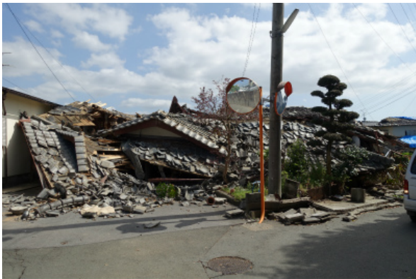
写真5.3-2 倒壊した木造住宅
