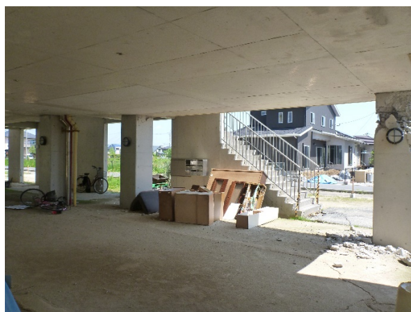
写真5.5-3 1階内部からの見上げ
