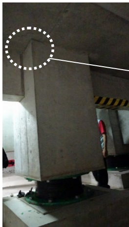
写真 5. 7. 2-55 小型の積層ゴム取付け基部のひび割れ
