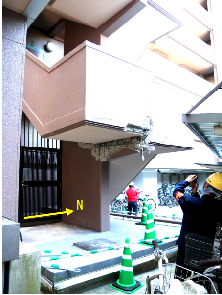
写真 5. 7. 2-39 外付け階段の被害状況① (階段南側)
