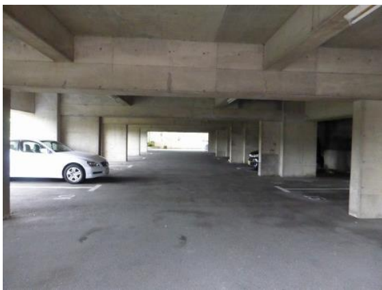
写真5.5-71 駐車場階（1階）全景
