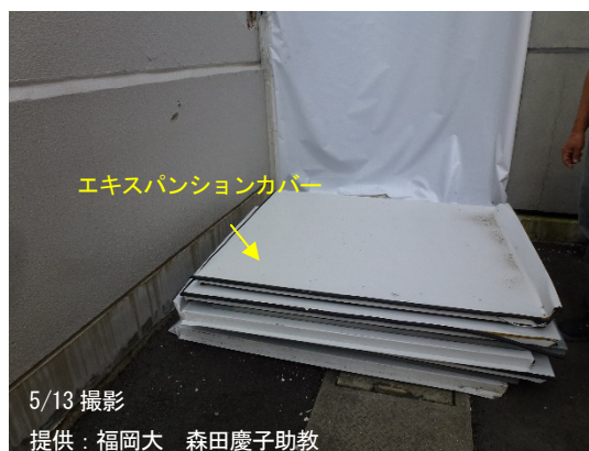
写真 5.7.2-61 エキスパンション部の破損と取り外されたカバー
