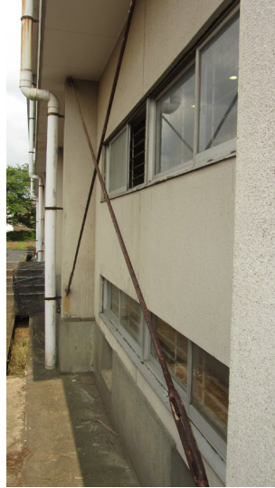
写真 5.4-74 鉛直ブレース（左：2階レベル、右：1階レベル）
