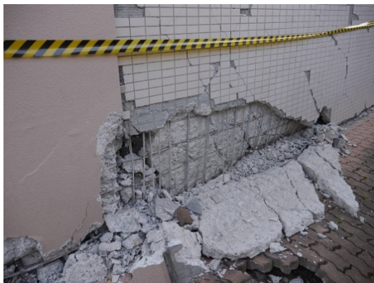
(e) 非構造壁(X5 構面)
