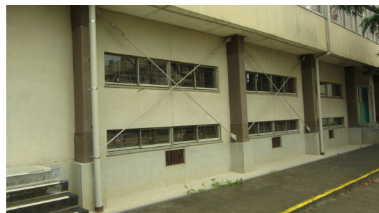
写真 5.4-108 1階鉛直ブレース（被害なし）
