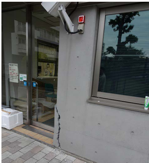
写真5.5-128 外壁端部のひび割れ
