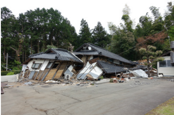
写真 5.3-38 倒壊した木造住宅
