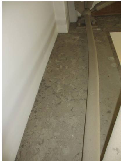
写真 5.4-183 体育館Nのトラス屋根の下弦材の曲がり
