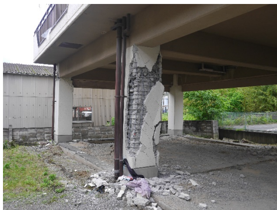
(a) 西側から見た柱全景
