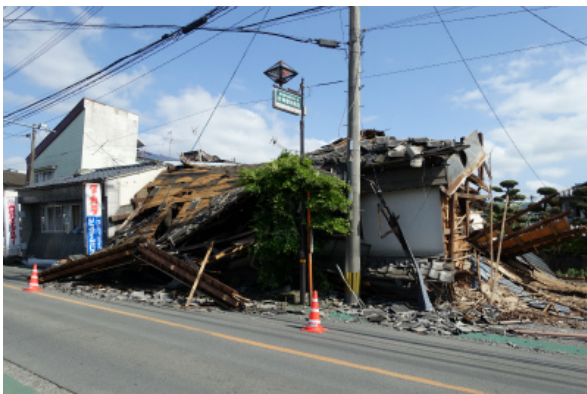
写真5.3-4 倒壊した木造住宅
