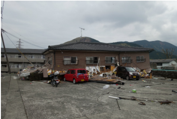
写真 5.3-56 倒壊した木造アパート E
