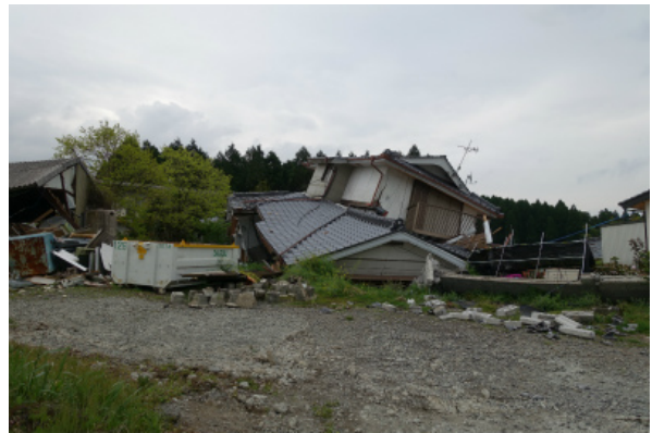
写真 5.3-67 倒壊した木造住宅
