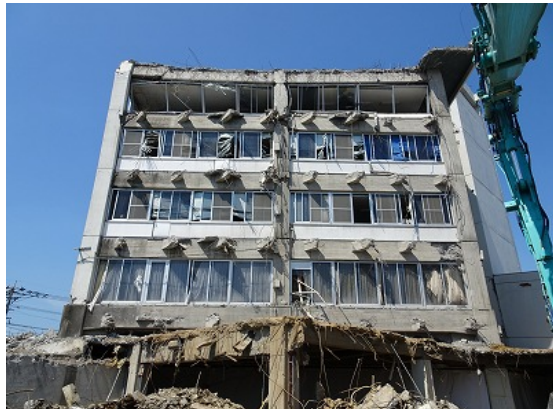
写真5.5-200 一部解体後の外観（南東側）
