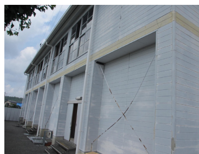
写真 5.4-123 1階のブレースの様子
