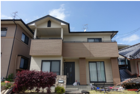
写真5.3-22 外観上無被害の木造住宅
