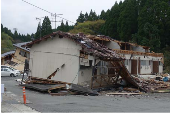
写真 5.3-54 倒壊した木造アパート D
