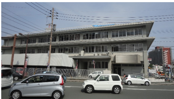
写真5.5-182 建築物外観 (西側)
