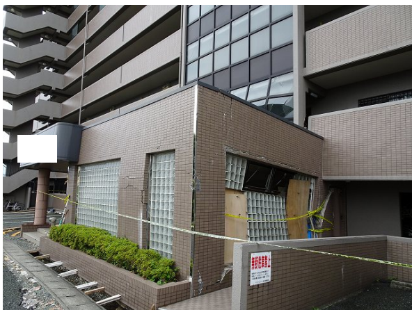
写真5.5-80 1階エントランスホールの外観
