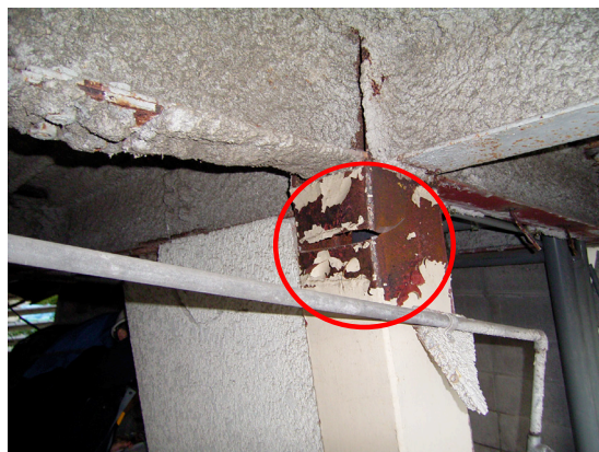
写真 5.4-26 柱の破断
