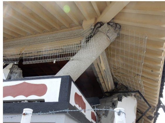
写真5.5-226 柱頭部の配筋
