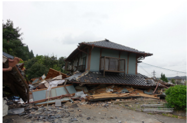
写真 5.3-27 倒壊した木造住宅
