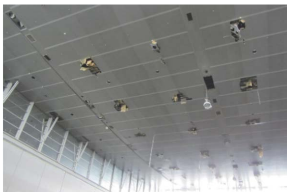
(a) 展示場ホールの天井
