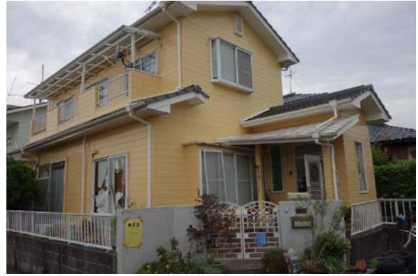
写真 5.6-6 軽微・無被害に見える建築物
