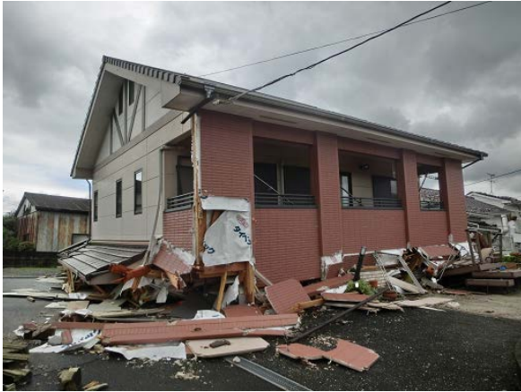
写真5.3-20 倒壊した木造住宅
