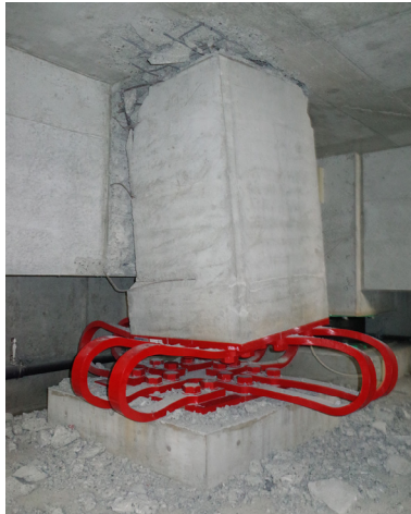
写真 5. 7. 2-51 鋼材ダンパー取付け 基部の損傷①（北西部）
