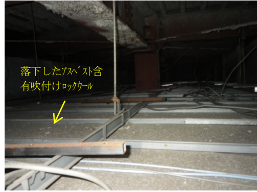
写真 5.8.2-73 1階吊り天井内部
