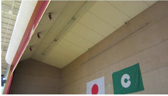
写真 5.4-73 舞台天井（被害なし）
