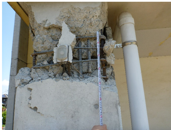
写真5.5-2 1階柱頭部の拡大
