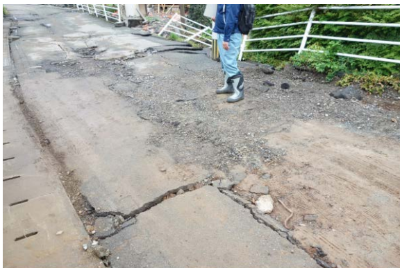
写真 5.6-28 B 通り・県道 28 号南側の道路の舗装の様子。
