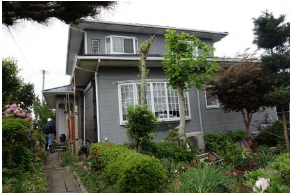
写真 5.6-14 造成宅地に立地する軽微・無被害と思われる建築物
