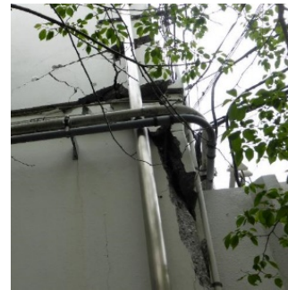
写真5.5-198 北東側2階脚部
