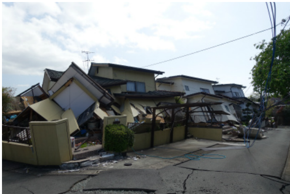
写真 5.3-16 倒壊した木造住宅
