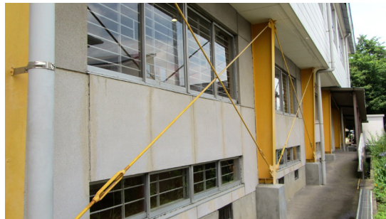
写真 5.4-114 1階の鉛直ブレース
