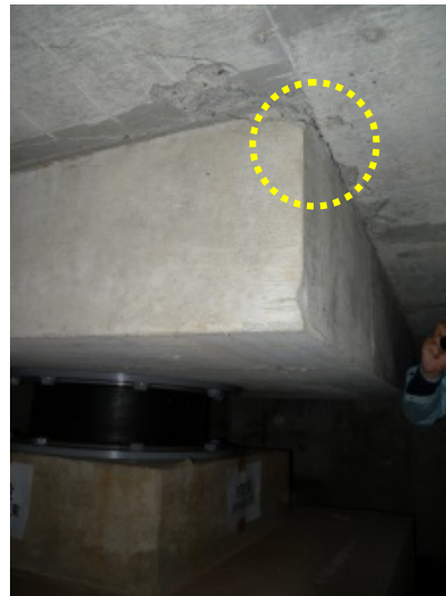
写真 5. 7. 2-41 階段下に設置された積層ゴム支承の取り付け基部の損傷 (左図は右図囲みの拡大)
