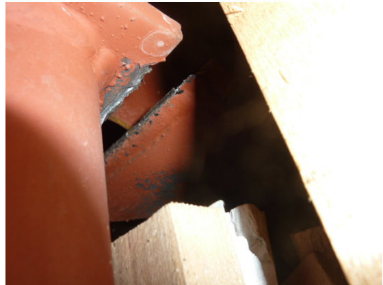
写真 5.4-19 梁端破断
