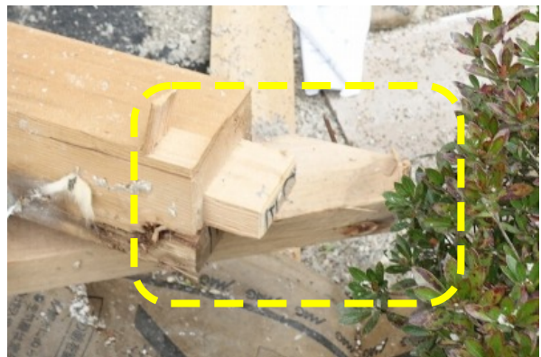
写真 5.3-51 柱頭部 (釘打ちによる接合)
