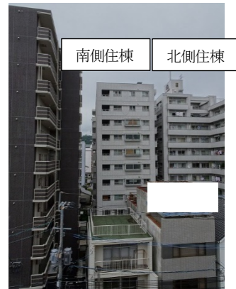
写真5. 5-74 隣接建築物から撮影した外観
