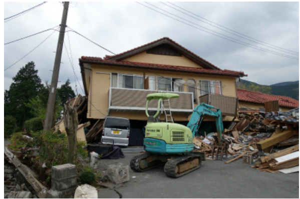
写真 5.3-65 倒壊した木造住宅
