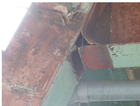
写真 5.4-5 梁端破断
