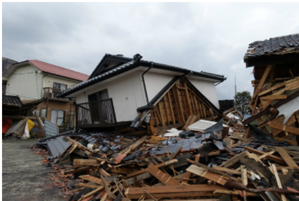
写真 5.3-66 倒壊した木造住宅
