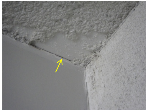
写真 5. 8. 2-82 2階ギャラリー天井 (RC スラブ裏)
