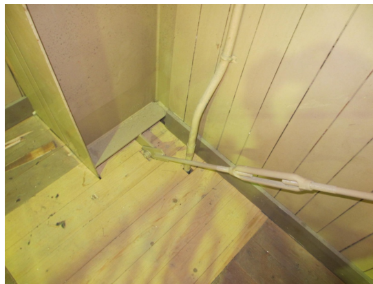
写真 5.4-133 改修で取り替えられたブレース（被害無し）
