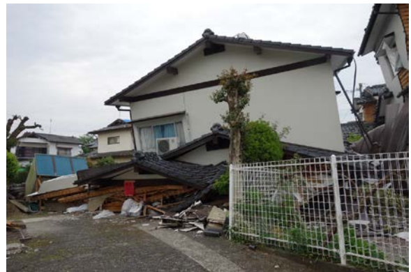
写真 5.6-2 1 階が倒壊している建築物
