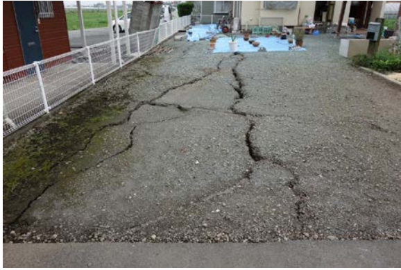
写真 5.6-20 写真 5.6-19 の建築物の周辺地盤、 秋津川近くは地盤変状が大きい。
