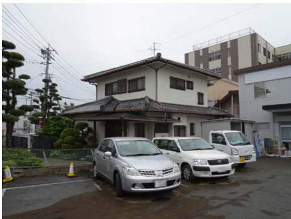
写真 5.6-47 地盤の液状化により沈下・傾斜したと思われる 2 階建て木造住宅
