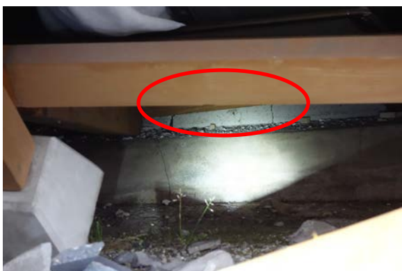
写真 5.6-27 写真 5.6-26 の建築物で確認できた基礎の様子。一部にひび割れを確認できる
