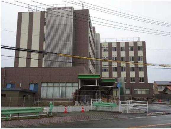
写真 5.6-55 地盤の液状化により周辺地盤が大きく沈下したと思われる病院
