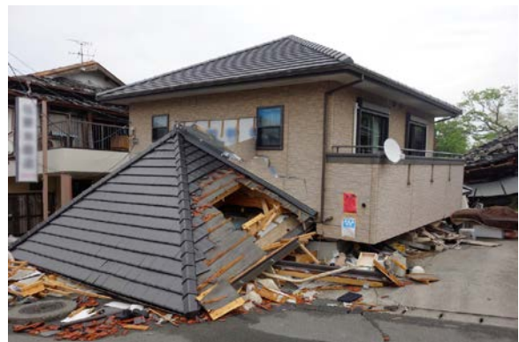
写真 5.6-29 建築年代が新しいと思われる倒壊建築物
