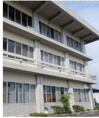
写真5.5-179 3F 外周部の手すりの撤去
