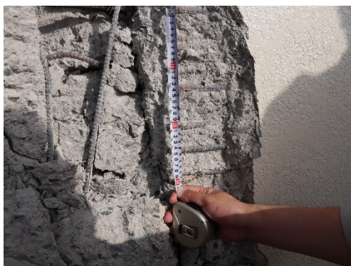
写真5.5-26 柱帯筋の配筋
