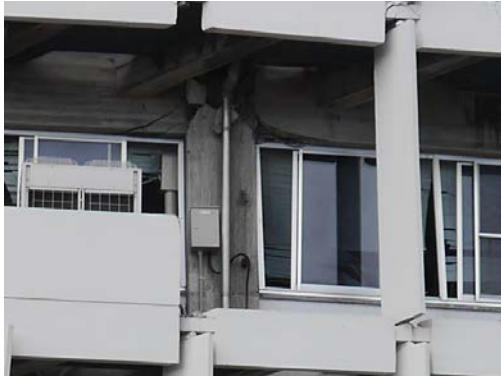
写真5.5-194 西側4階柱-5階梁接合部
