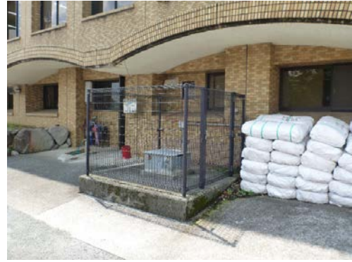
写真5.5-136 地震計設置状況
