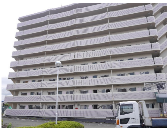
(a) 北側から見た全景
