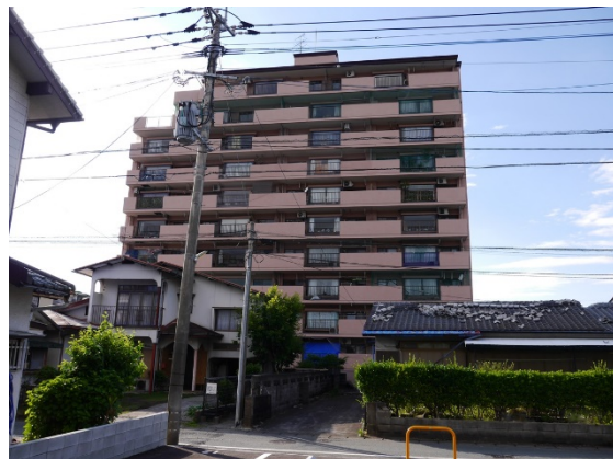
写真5.5-98 建築物南東側
