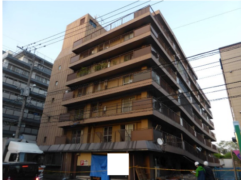
写真5.5-205 外観（南西側、県道側、東西軸住棟）
