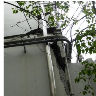
写真5.5-198 北東側2階脚部
