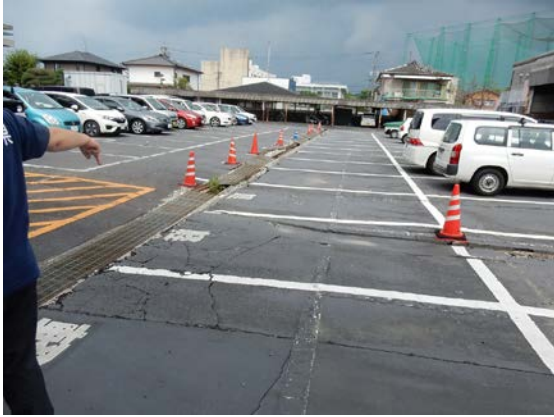
写真5.5-178 建築物周辺の地盤変状
