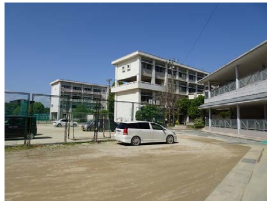
写真5.5-288 校舎外観 (奥2棟)
