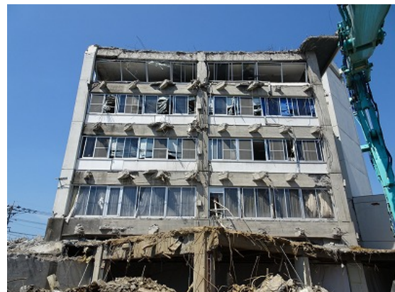
写真5.5-200 一部解体後の外観（南東側）
