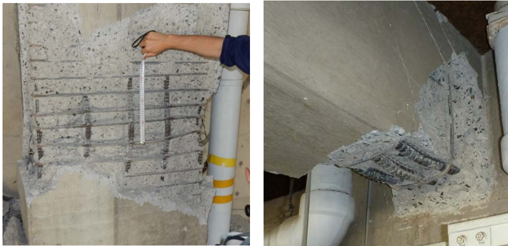
写真5.5-16 1階柱主筋、2階大梁（張間方向）の配筋
