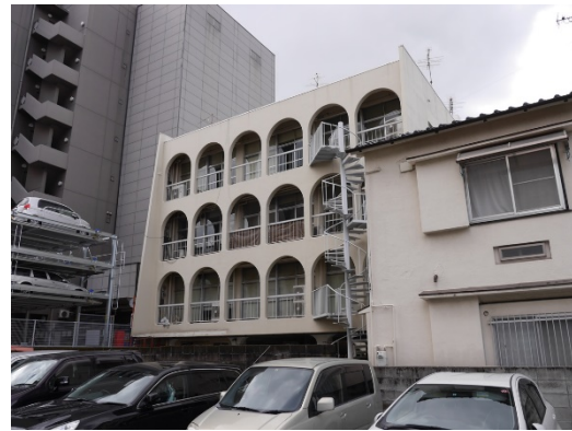
写真5.5-308 建築物南東側
