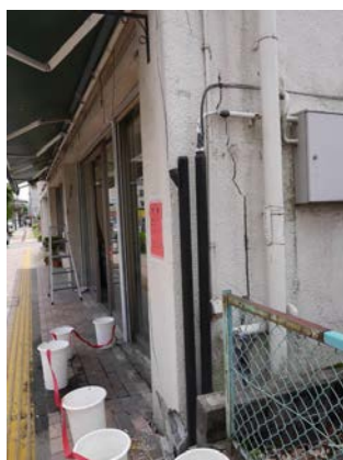
写真5.5-301 1階柱のせん断ひび割れ
