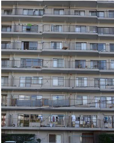
写真5.5-60 桁行き方向バルコニー側の方立て壁のせん断破壊
