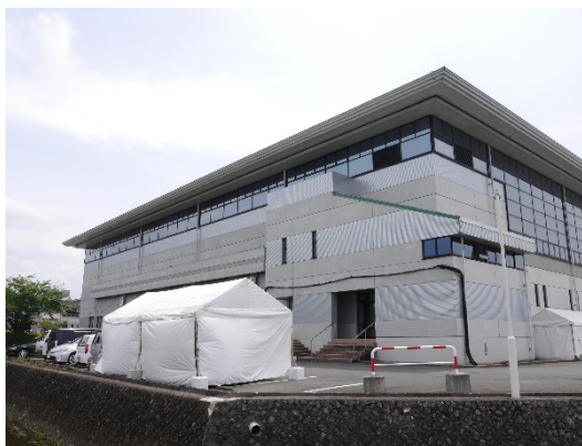
写真5.5-118 隣接する体育館
