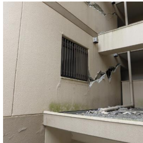
写真5.5-55 梁端部のかぶりコンクリー トの剥落
