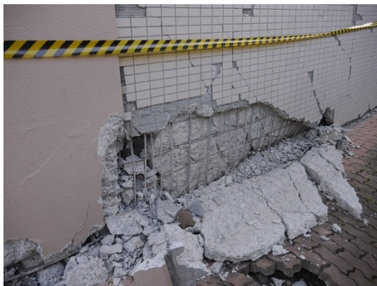
(e) 非構造壁(X5構面)
