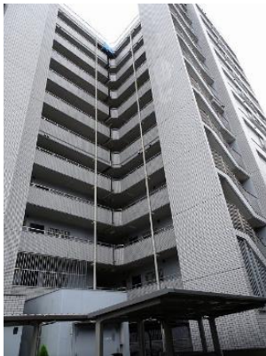
写真5. 5-73 南側建築物の北面とエキスパンションジョイント部
