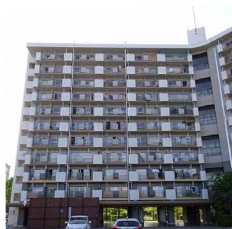
写真5.5-237 バルコニー側の袖壁の損傷
