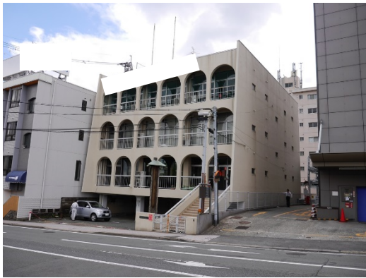
写真5.5-307 建築物北西側
