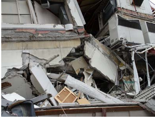
写真5.5-220 エキスパンションジョイント部（南面）
