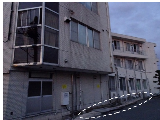
写真5.5-261 コンクリートブロック塀の倒壊
