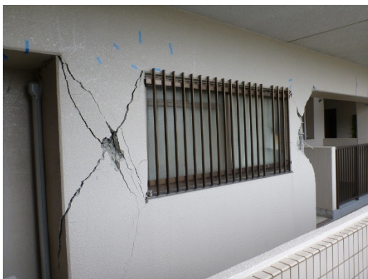
写真5.5-61 桁行き方向の共用廊下側の構面における被害
