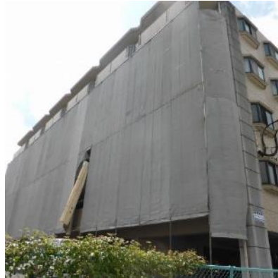
写真5.5-30 建築物南東面
