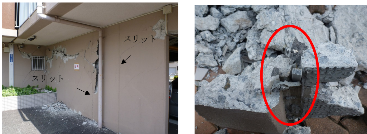
写真5.5-17 柱際に設けられた非構造壁の部分スリット
