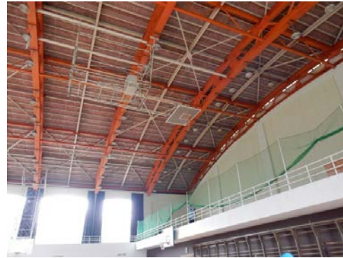
写真5.5-189 鉄骨屋根（白色の部材が耐震改修による水平ブレース）
