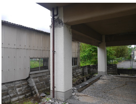
(a) 北西側から見た柱全景
