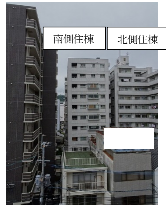
写真5. 5-74 隣接建築物から撮影した外観
