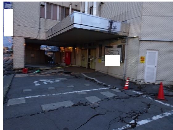
写真5.5-259 地盤の亀裂
