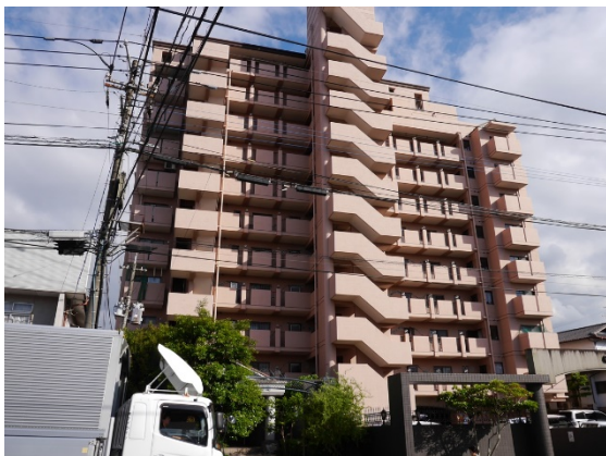
写真5.5-97 建築物北西側
