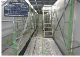
足場内部の養生(例)
