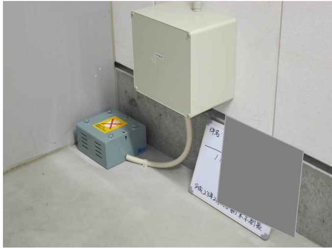
図1.2-22 加速度計#2(1階EPS)
