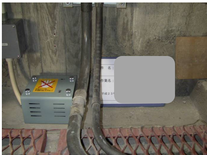
図1.2-11 加速度計#4(8階EPS)
