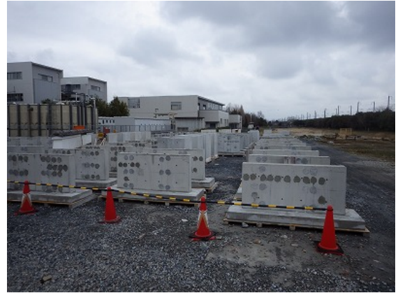
模擬部材の静置状況
