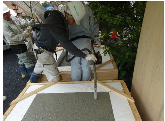
模擬床部材の締固めの状況
