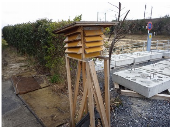
外気温の測定状況
