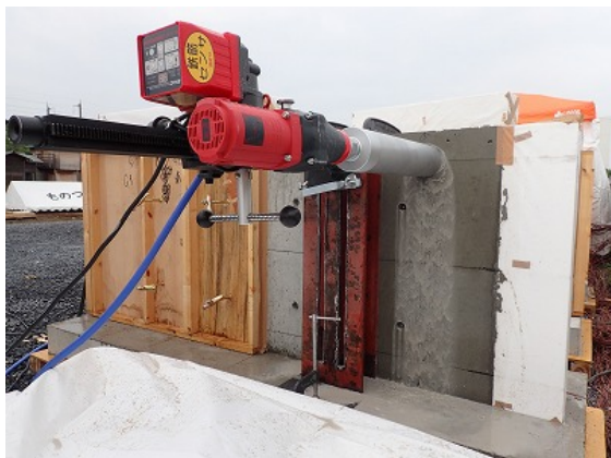
模擬壁部材からのコア供試体の採取状況
