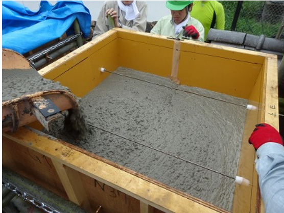
模擬柱部材への打込み
