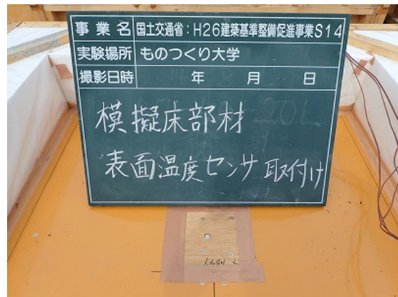
模擬床部材の表面温度センサの取付け状況
