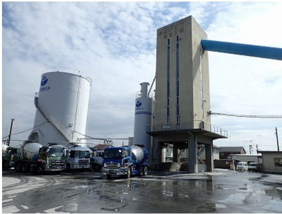
コンクリートの製造場所の全景
