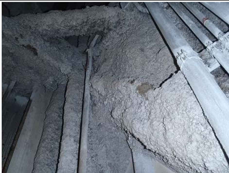
吹付け材の状況 3号機
