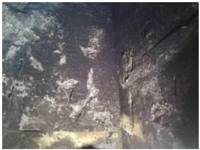
点検口内の掻き出し時のスコップ痕と思われる痕跡
