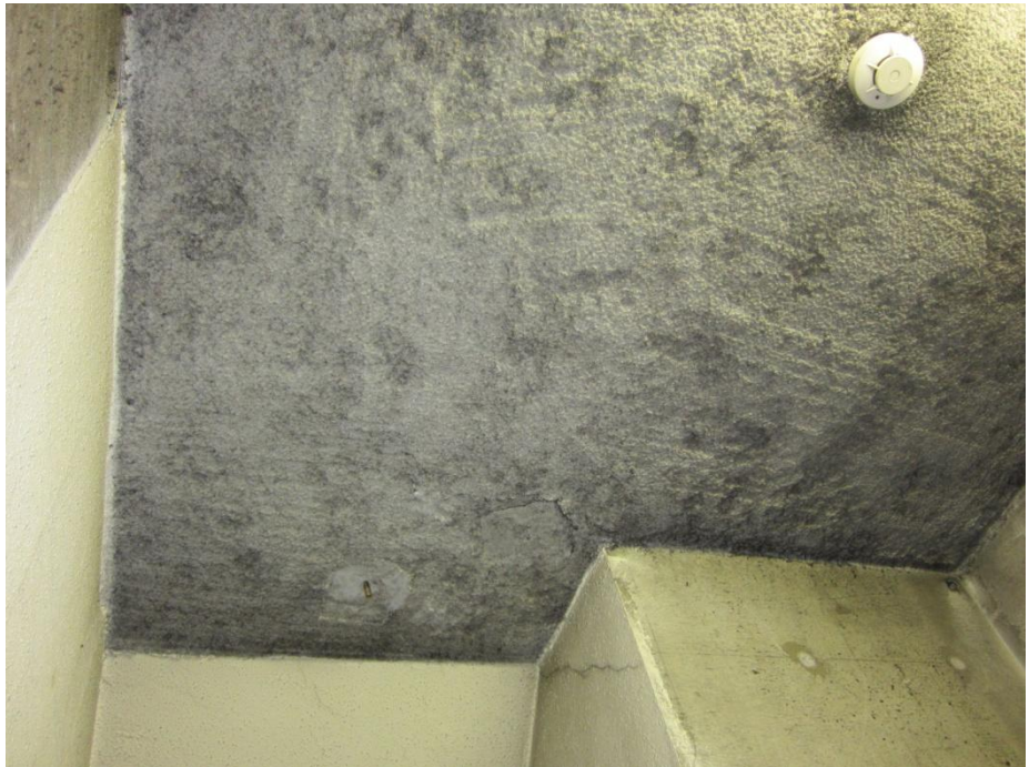
エレベーター機械室前廊下 (天井)
