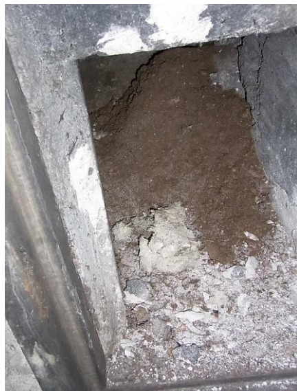
機械室内 煙突下部
