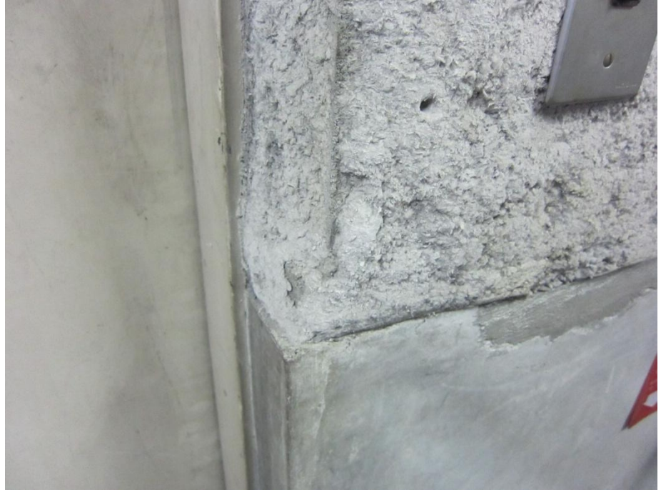
ボイラー室内②
