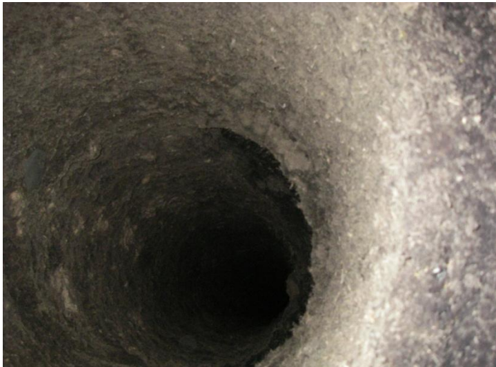
煙突内部（底部から）
