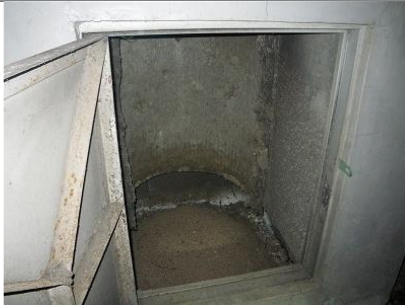
煙突下部点検口
