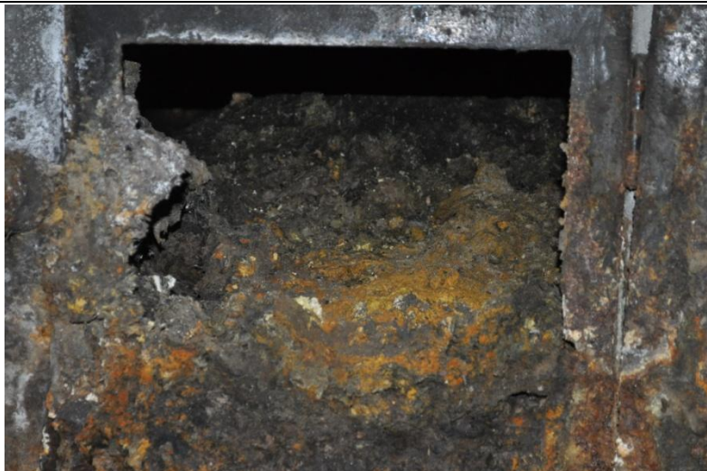
煙突断熱材
