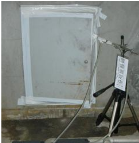
煙突点検口内
