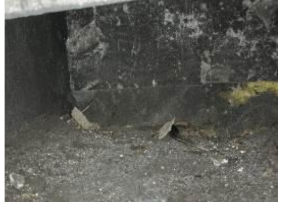
煙突点検口内
