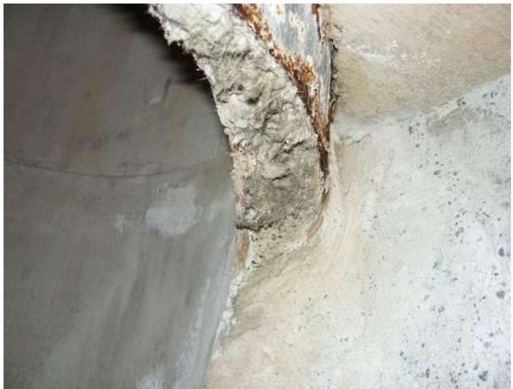
点検口内部状況
