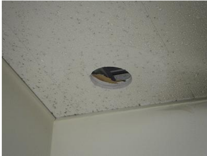
岩綿吸音板（下地石膏ボード）
