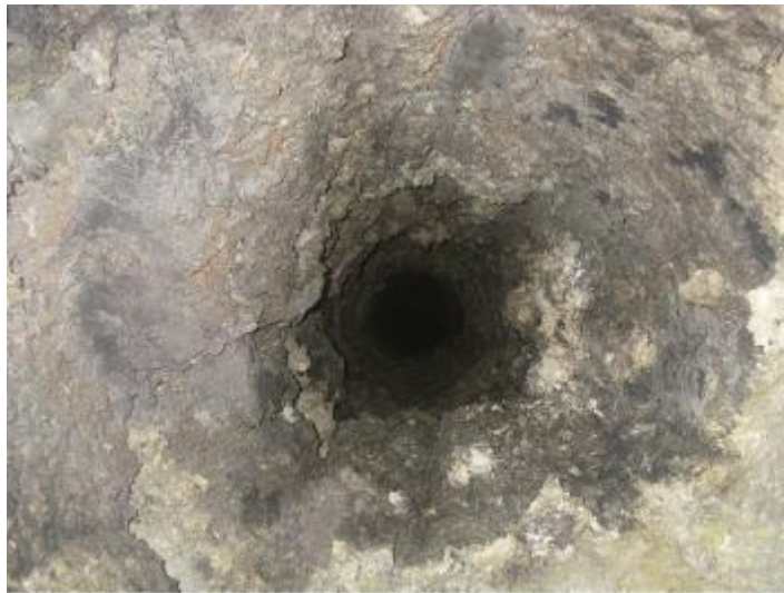
煙突内部の状況
