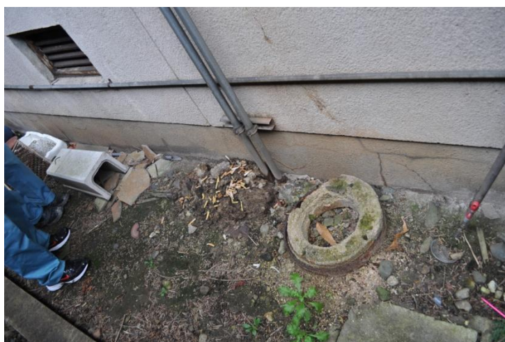
屋外(廃棄物箇所)
