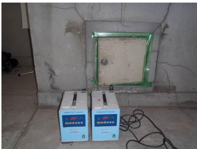
煙突点検口内サンプリング
