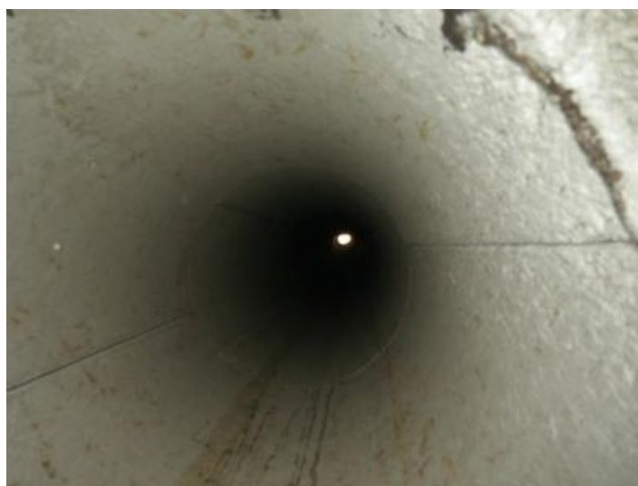
煙突点検口内天井側
