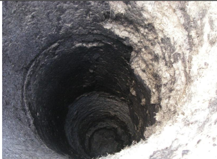
煙突内部（頂部から）
