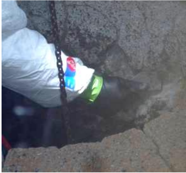
煙突頂部断熱材除去状況（簡単に剥離） 煙突頂部養生外濃度測定→
