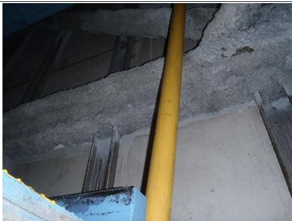
吹付け材の状況 3号機
