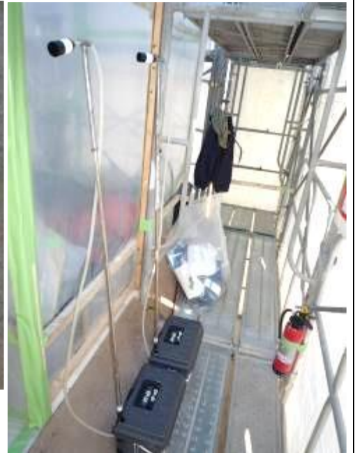
煙突頂部断熱材除去状況（簡単に剥離） 煙突頂部養生外濃度測定→
