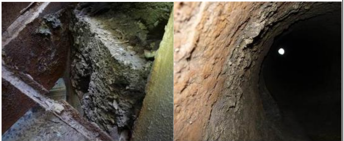
煙突点検口内
