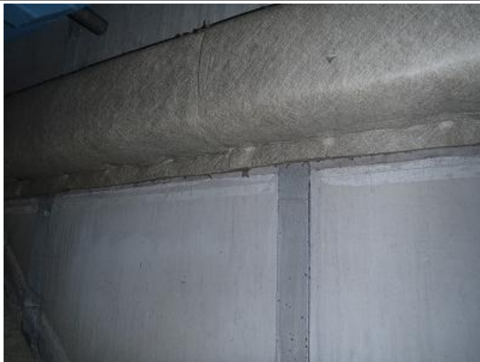
除去後復旧の状況 1号機
