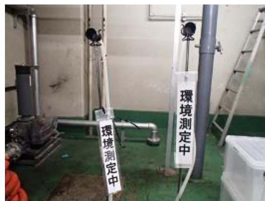
機械室サンプリング
