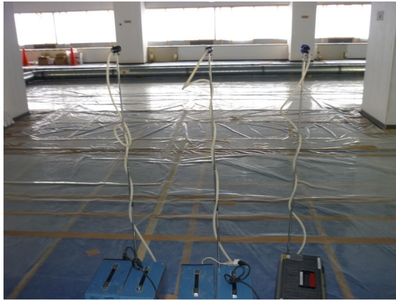
除去室隣室の室内状況
