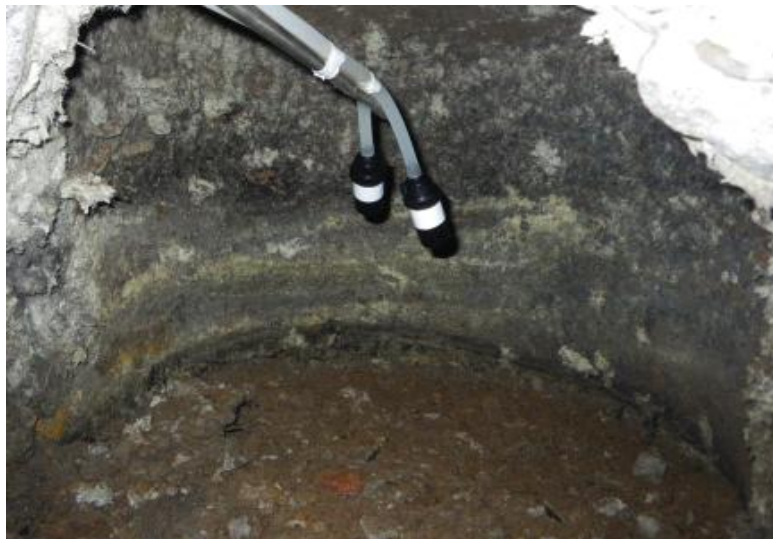
煙突内部断熱材（下部から）
