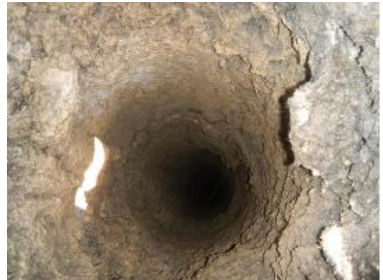
煙突内（頂部より内部を撮影）
