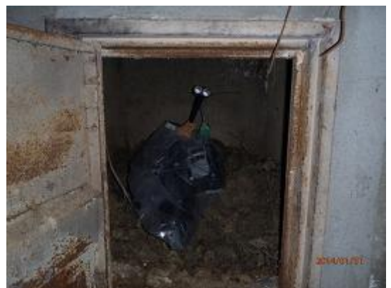
点検口内（開放時）
