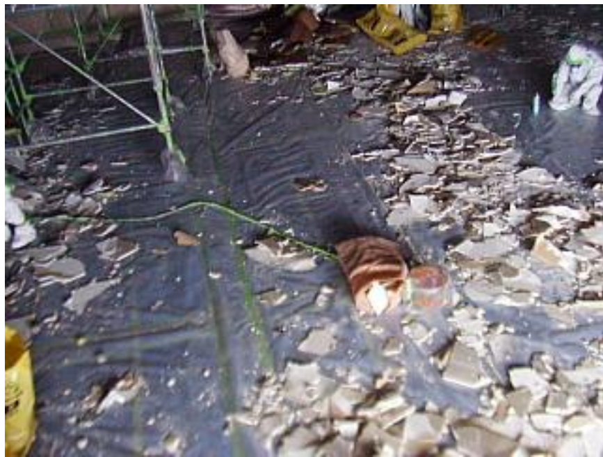
作業中の床状況
