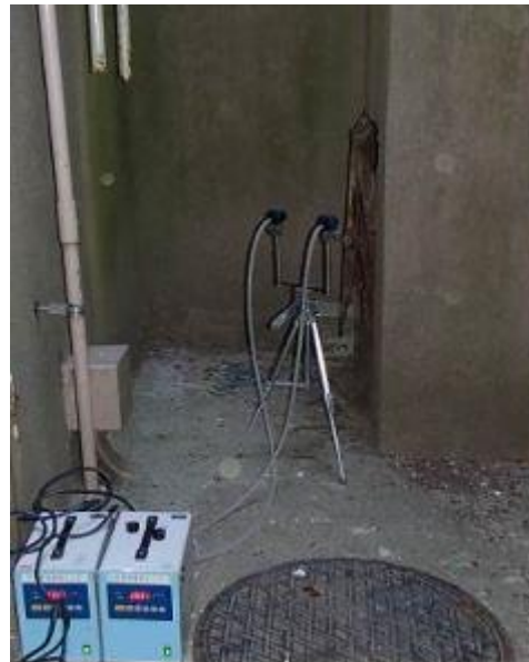
煙突点検口前
