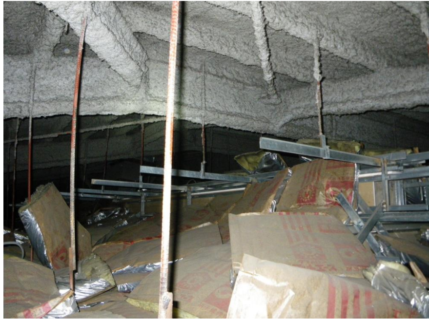
天井裏（作業前）
