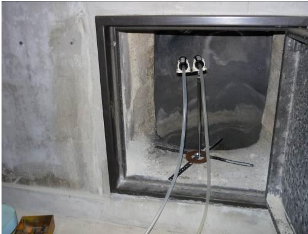
室内測定状況
