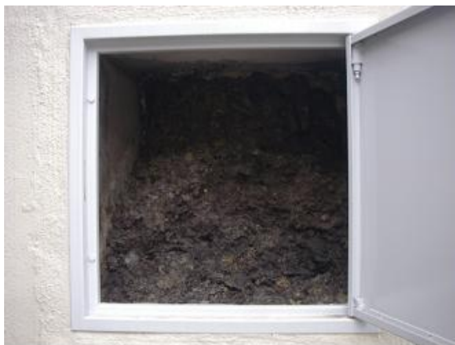
断熱材撤去前の状況
