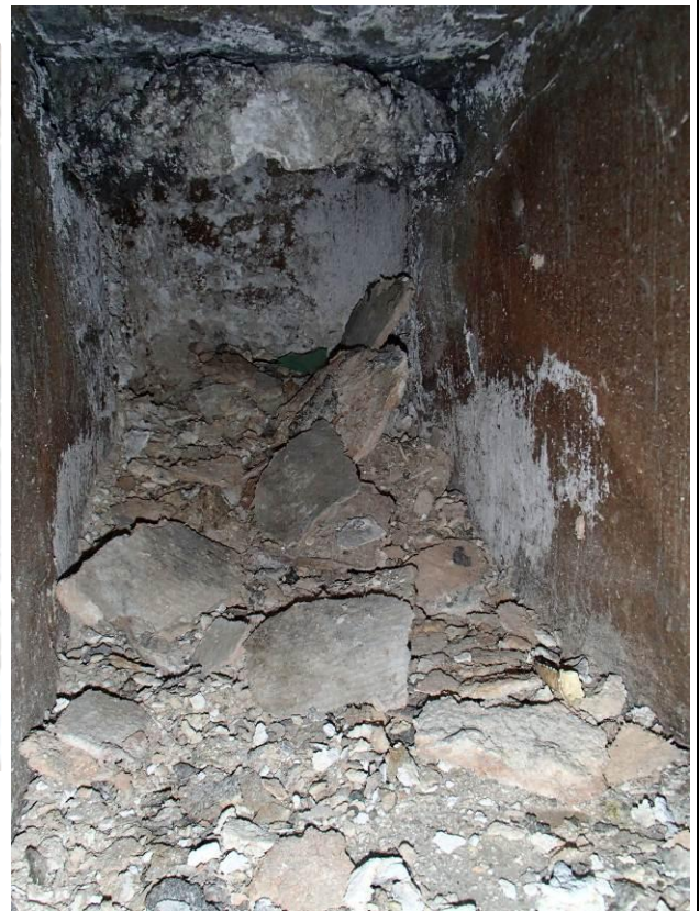
煙突点検口内状況
