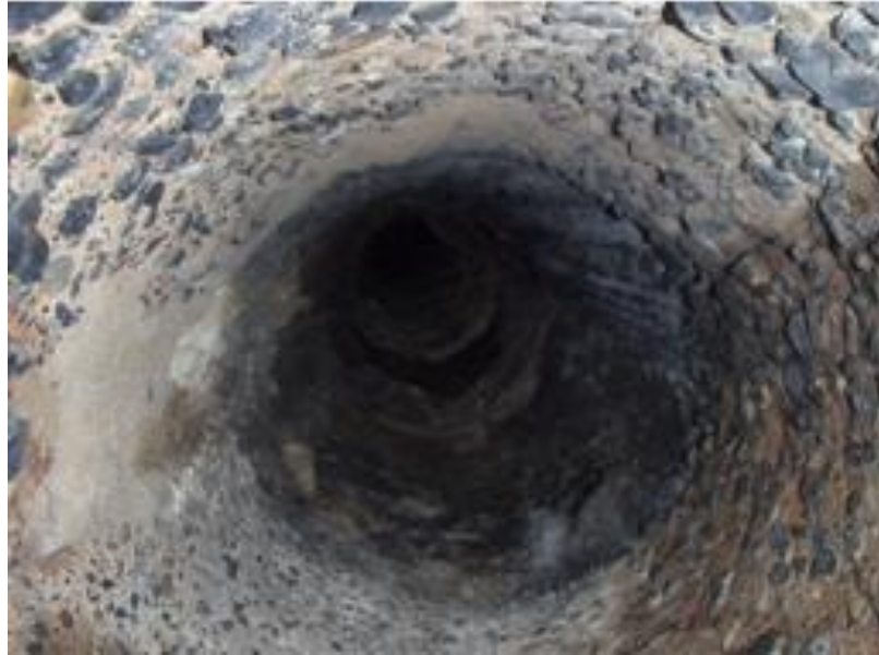
屋上から下部内部状況
