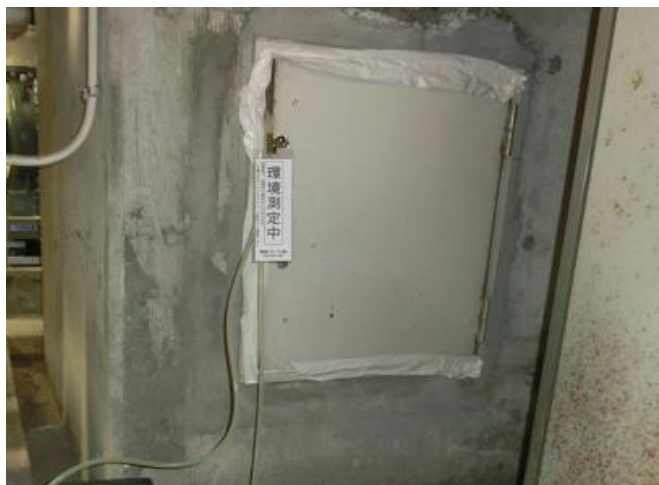
煙突点検口内採取状況
