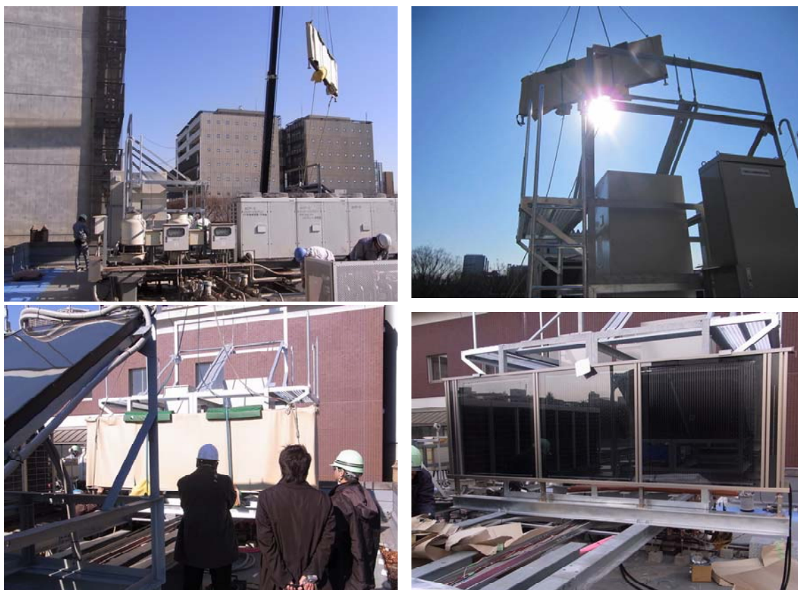
図 7.5.1.5 試験対象機の屋上試験装置への設置（集熱器の吊込）
