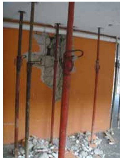
写真 4.10.2 T形壁柱と耐力壁の破壊
