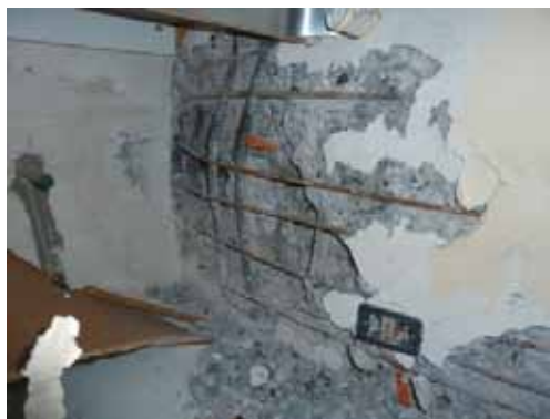
写真 4.4.3 写真 4.4.2 の内部の様子
