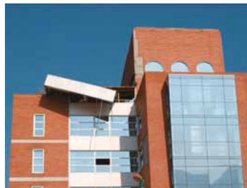
写真 4.7.4 ペントハウス階の落床と屋根非構造材の被害
