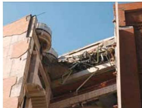
写真 4.7.2 外部階段壁の崩落、階段室鉄骨梁の落下
