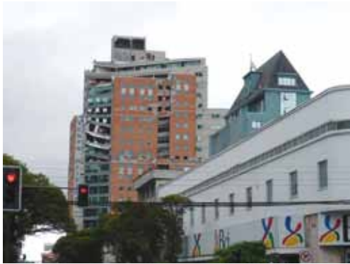
写真 4.23.3 層崩壊している 12 階付近
