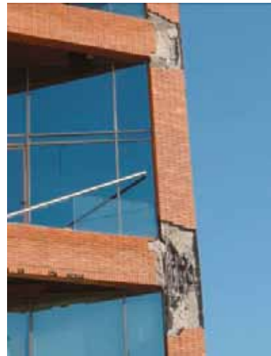
写真 4.7.3 梁と柱梁接合部の破壊
