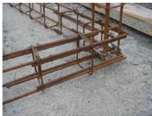
写真 4.18.2 基礎梁の配筋とコーナー鉄筋
