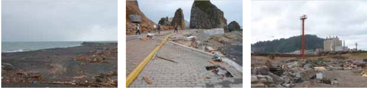
写真 4.40.4 津波による海岸部の被害
