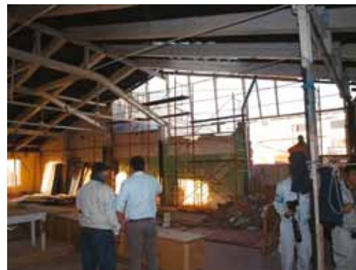
写真 4.31.2 撤去中のれんが壁
