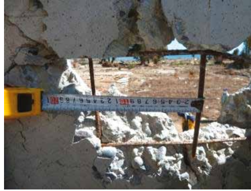
写真 4.33.2 プレキャスト RC 造壁
