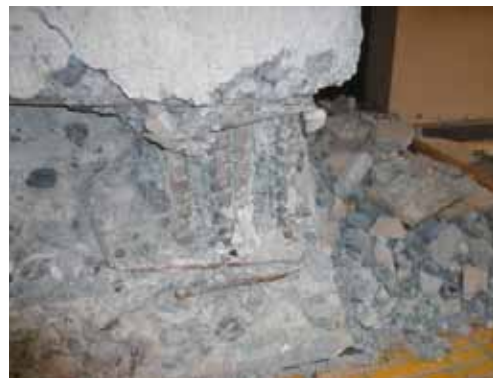
写真 4.20.4 柱脚部の配筋状況
