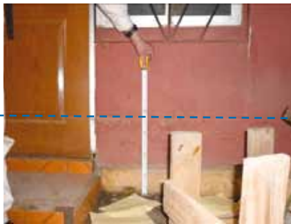
写真 4.40.1 河口近くの SERVIU 集合住宅の津波跡 (高さ 400mm 程度)
