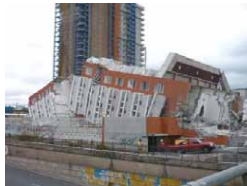
写真 4.25.2 倒壊した建物外観
