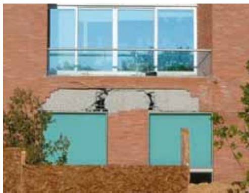
写真 4.7.3 梁と柱梁接合部の破壊
