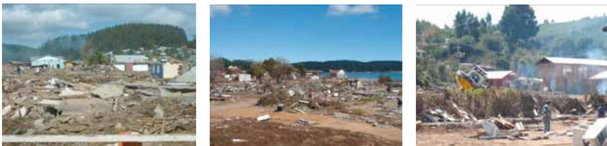
写真 4.42.1 津波による海岸部の被害
