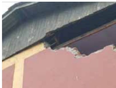
写真 4.15.3 妻壁頂部の梁の崩落
