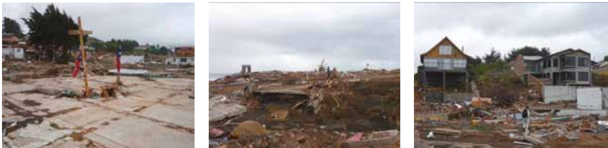
写真 4.41.1 津波による海岸部の被害
