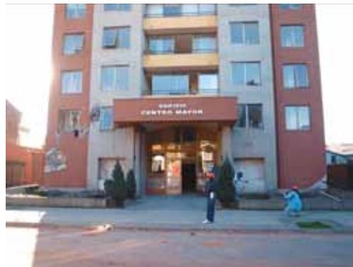
写真 4.29.2 建物入口部の壁脚が損傷
