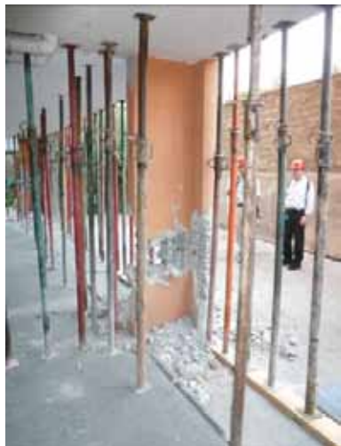
写真 4.10.2 T形壁柱と耐力壁の破壊
