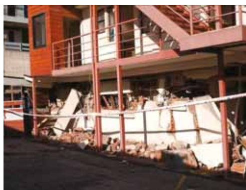
写真 4.28.2 1階部分に被害が集中
