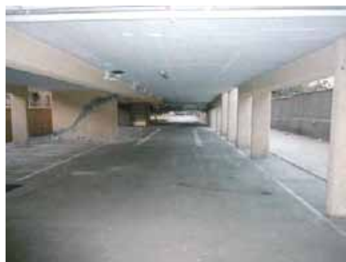
写真 4.9.2 1 階駐車場（ピロティ）
