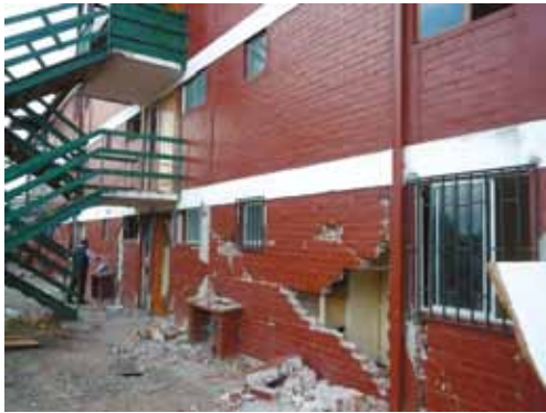
写真 4.17.2 大破した桁行方向壁
