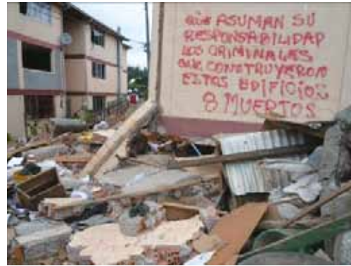
写真 4.14.3 1 層部分で層崩壊した建物
