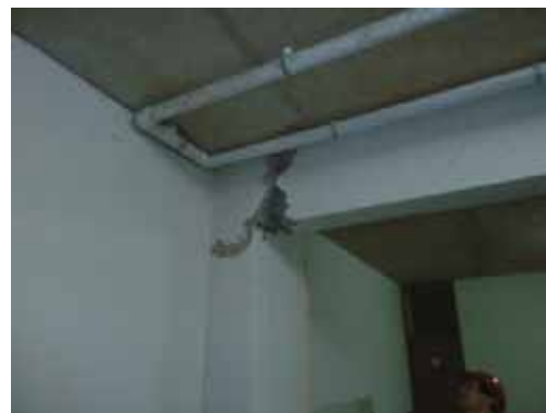
写真 4.4.4 写真 4.4.2 の地下部分
