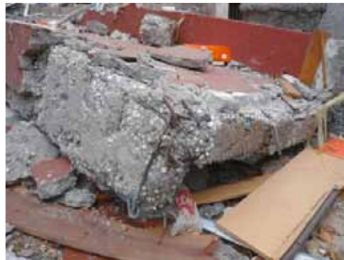
写真 4.19.2 発泡スチロール粒が混入された コンクリート
