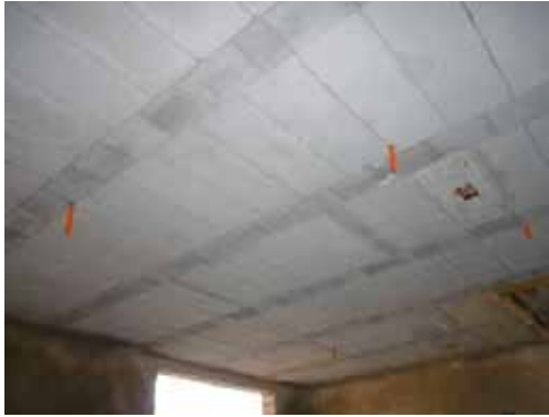
写真 4.18.3 スラブ（見上げ）
