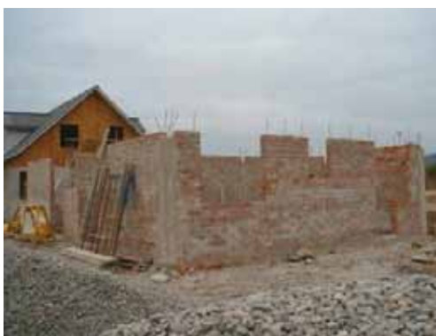
写真 4.18.1 CM 造住宅建設風景
