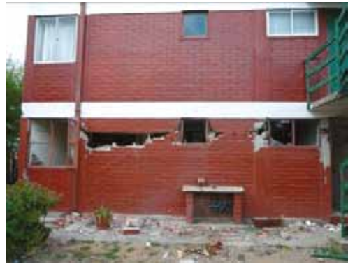
写真 4.17.2 大破した桁行方向壁
