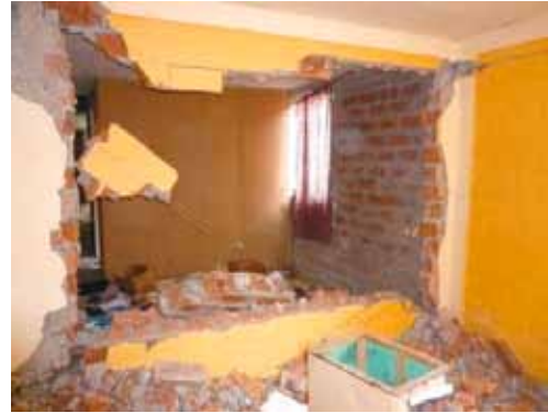
写真 4.14.2 CM 造の柱と壁部分
