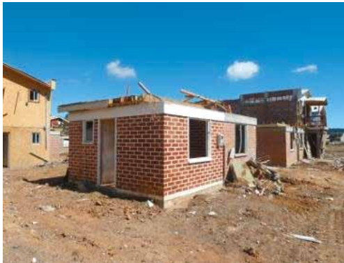
写真 4.34.2 津波により 2 階が流された住宅
