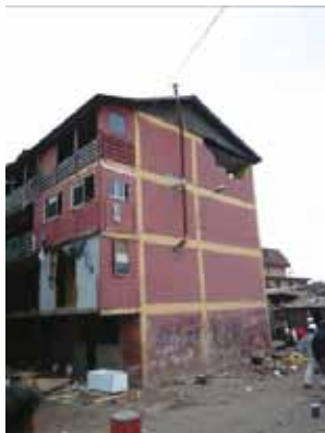
写真 4.15.3 妻壁頂部の梁の崩落
