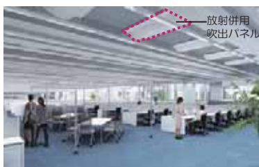
【クールビズに対応する放射併用空調、ライトビズに対応する照明システム、在室検知による照明・空調制御の概念図】
