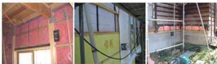
充填断熱気密工法
