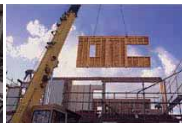
壁面ユニットでの現場組立作業 建方作業と壁面下地+断熱材施工工程が完了。
