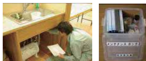
点検風景とメンテナンスボックス
