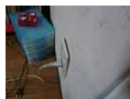
危険箇所の確認
