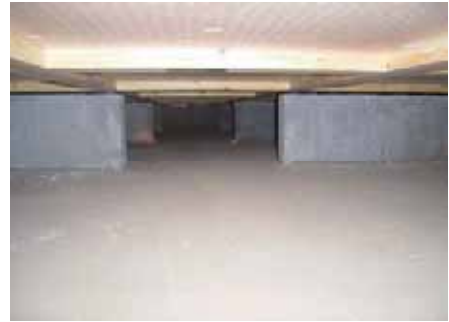
【束が無い1階床下空間】
