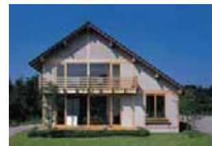
外壁真壁の外観
