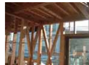
外周部の柱・間柱・筋交 全てヒノキ、ムク材
