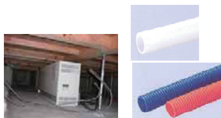
床下空間の様子とサヤ管材料
