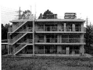
集合住宅外観
