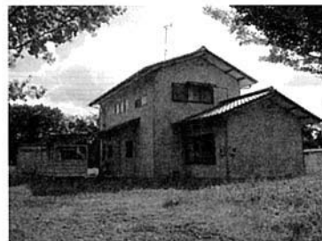
戸建て住宅外観
