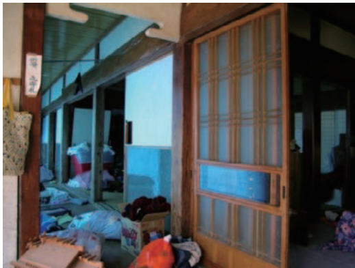
(c) 同住宅内部（特に躯体損傷なし）
