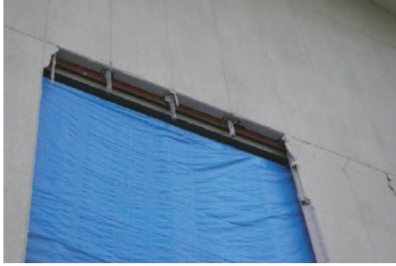
図-8.4.9 ALCパネルの上部取付け部
