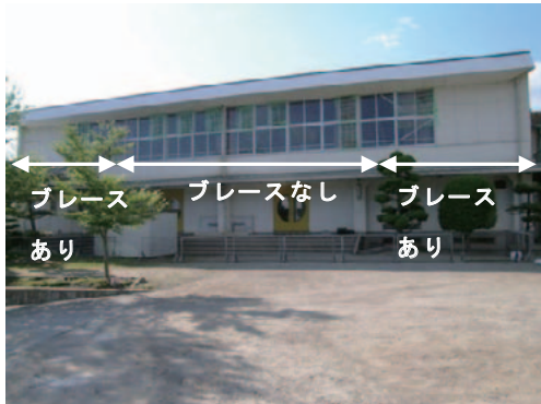
(a) 体育館外観及びブレース配置
