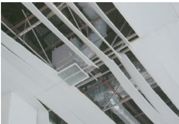
図-8.4.22 天井裏の状況
