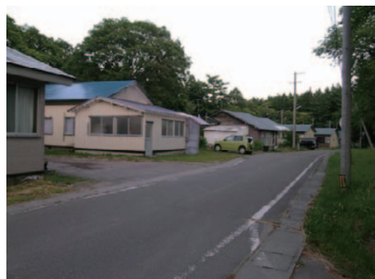
(d) 付近の住宅 (無被害)
