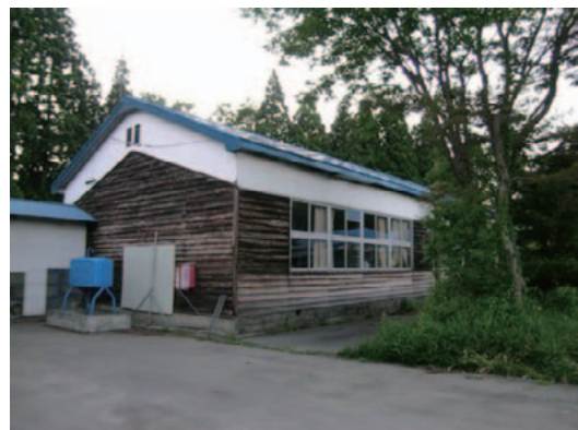
(b) プール北西側にある木造校舎
