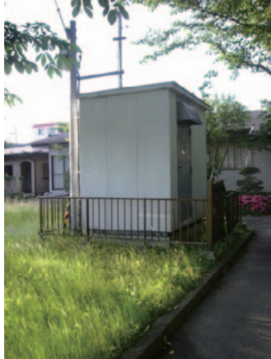
図-8.2.20 強震計設置状況(三日町公園)
