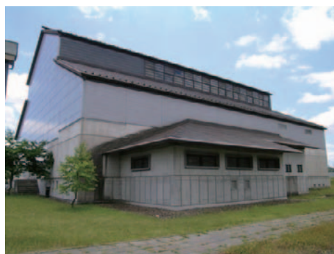
図-8.2.7 D建築物北面（高窓に被害なし）
