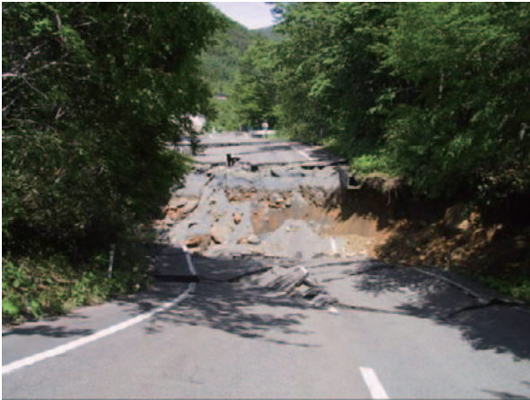
(秋田側から祭時大橋を望む)
