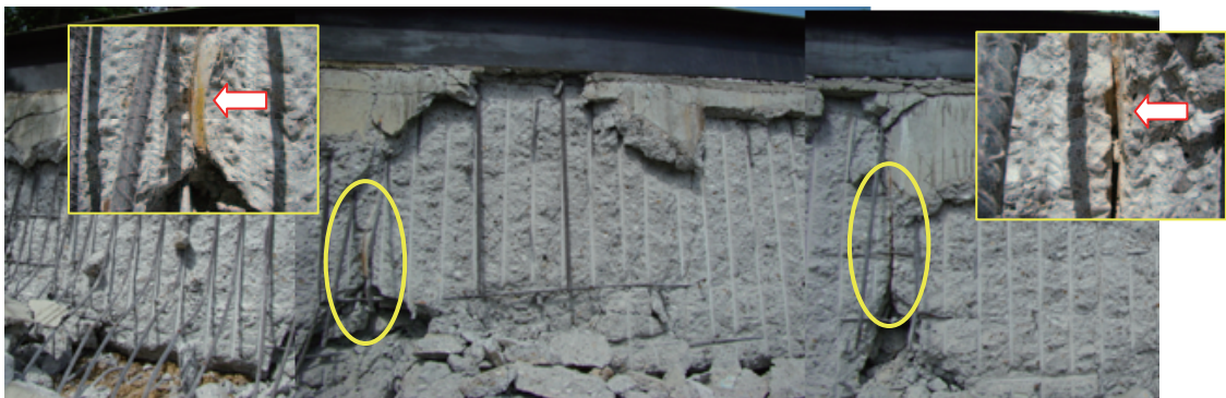
写真-6.22 主桁の衝突痕
