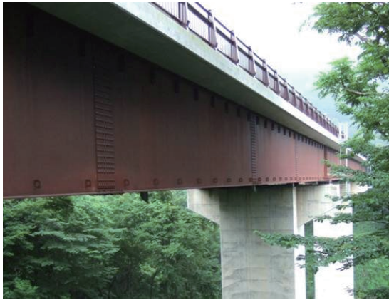
写真-6.30 17号橋梁赤倉沢橋
