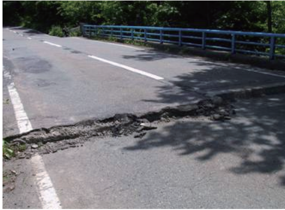
写真-6.12 杉の沢橋
