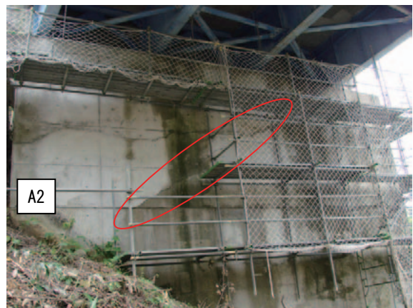
写真-6.11 A2 橋台の斜めひび割れ
