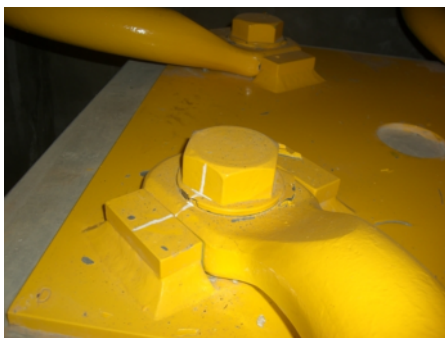
(a) 鋼材ダンパー取り付けボルト部 (b) 可撓ゴム配管部の移動跡
