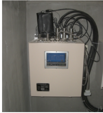
(a) 収録装置 (Akashi製SMAC-MDU) (b) 地震計設置状況 (免震層内)
