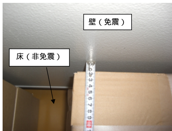
図-5.4.13 免震層の壁と資材との隙間
