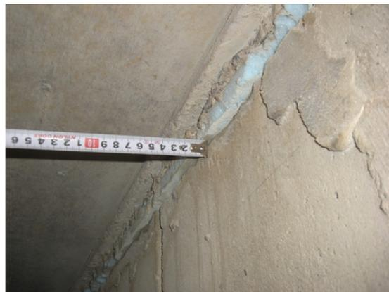
図-5.4.6 シール材（スチレンボード：水色）と免震層周囲の擁壁とのずれ（北に1.5～2 cm程度）
