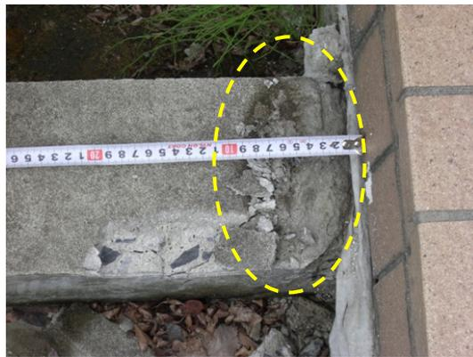
図-5.4.9 免震層犬走り (茶色タイル部) の破損 (5~10cm程度)
