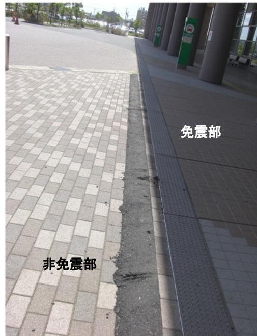
(b) 舗装の損傷（補修済み）
