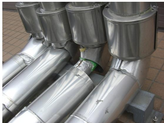
(b) 屈曲部カバーの損傷・脱落落下
