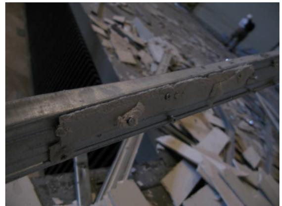
図-4.45 脱落したダブル野縁
