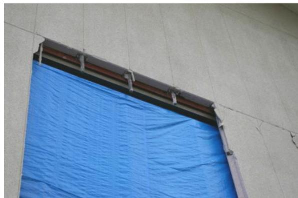
図-4.12 ALC パネルの上部取付け部
