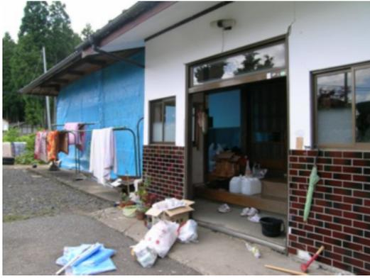
(a) 外壁損傷及びサッシの脱落
