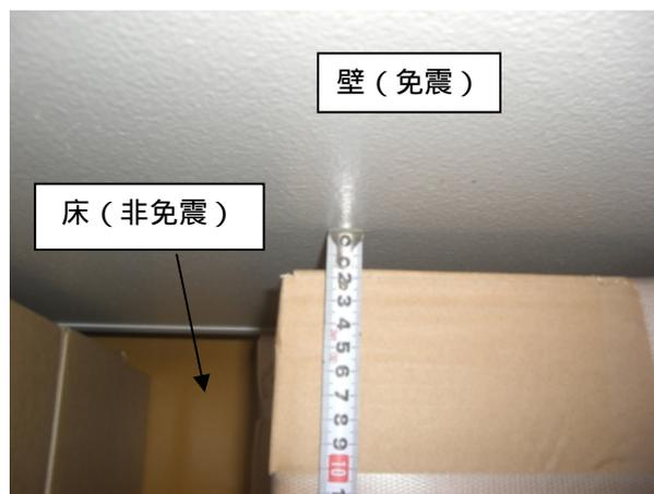
図-5.4.13 免震層の壁と資材との隙間
