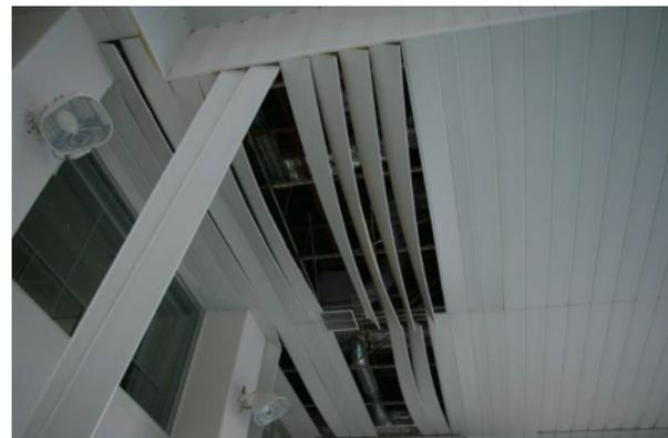
図-4.31 落ちかけている天井パネル
