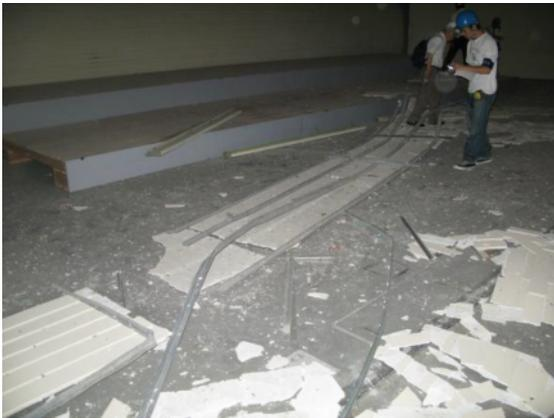
図-4.42 一体で脱落した天井板とダブル野縁
