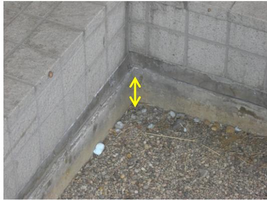
(b) 立上り部の露出（最大5 cm程度）
