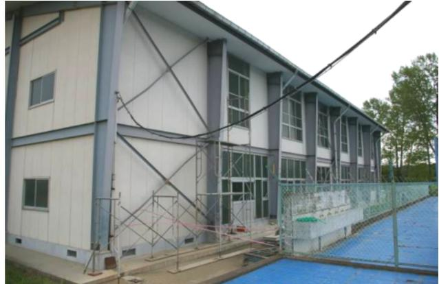
図-4.7 ブレースが座屈した東側桁行構面
