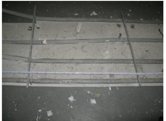
図-4.43 脱落した天井板とダブル野縁
