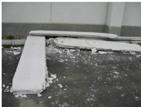
図-4.11 脱落した ALC パネル
