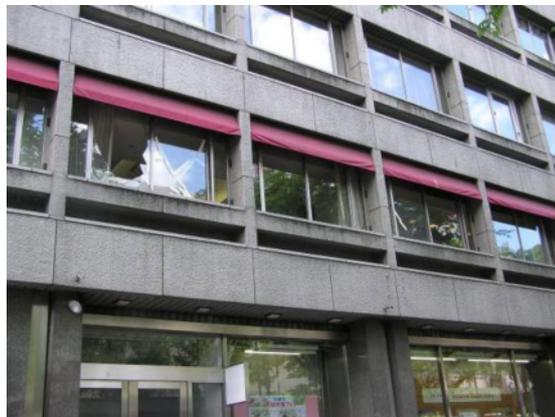
図-4.3 2階窓ガラスの被害状況（仙台市提供）
