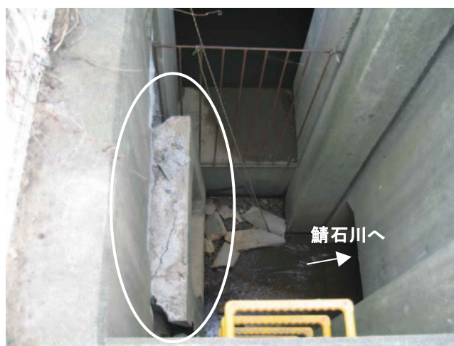
写真-5.12 鯖石川橋場町排水樋管の川裏側立抗内部の状況（立抗上部から鉛直下向きを望む）
