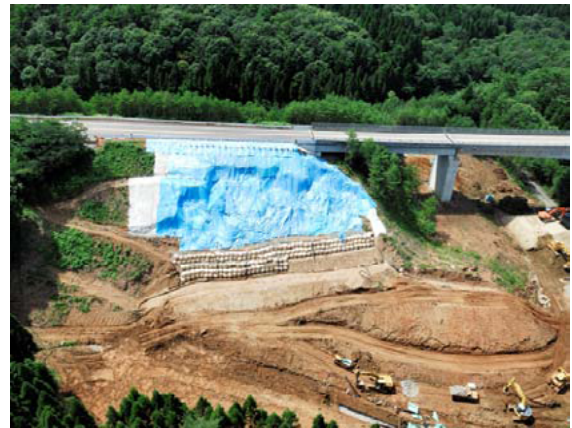
写真-7.2.34 応急復旧及び本復旧状況（石川県提供） 2)
