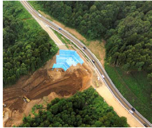
写真-7.2.3 応急復旧及び本復旧状況（石川県提供） 2)
