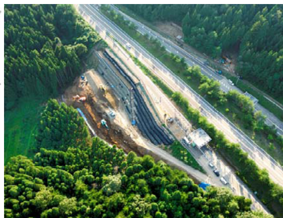
写真-7.2.9 応急復旧及び本復旧状況（石川県提供） 2)
