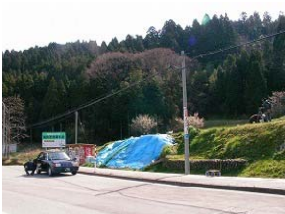
16-a 斜面左側の崩壊
