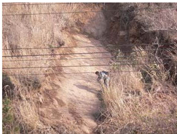
11-b くさび状の崩壊面
