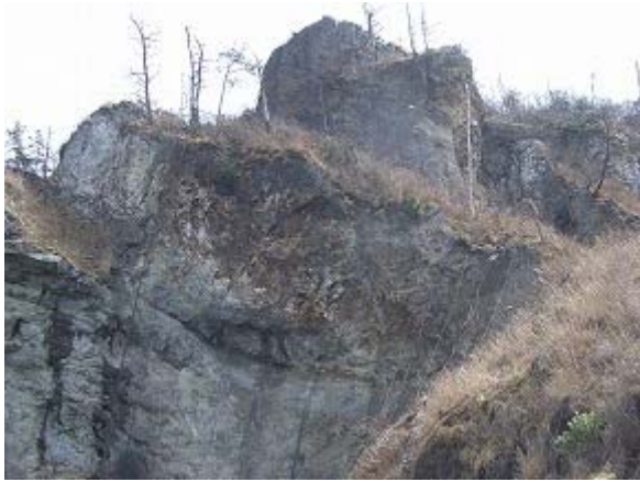
2-g 岩盤崩落箇所
