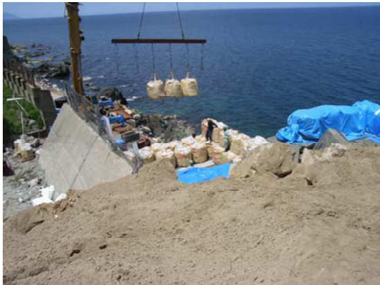
写真-7.3.29 サンドクッションの施工
