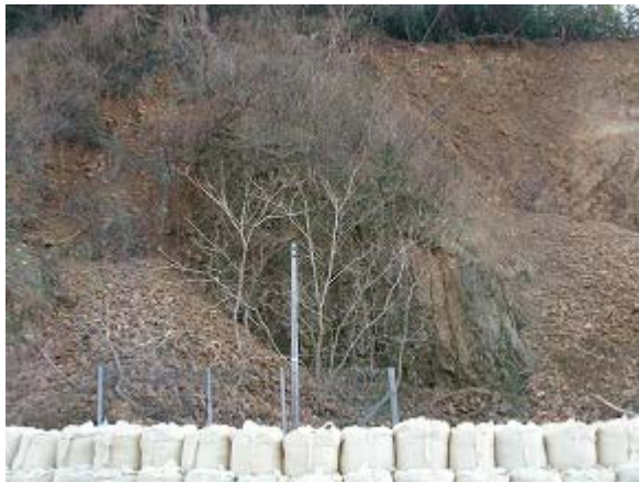
23-a 斜面正面の状況
