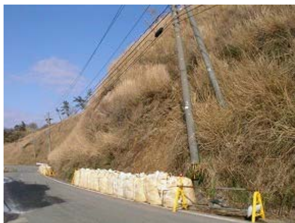
10-b 斜面と盛土部の修復跡
