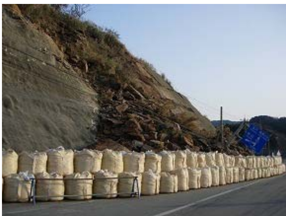
14-a 斜面左側の状況
