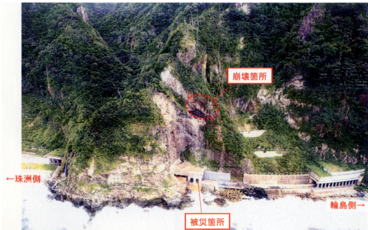
写真-7. 3. 25 被災箇所の被災前全景（復旧検討会資料 5) より）
