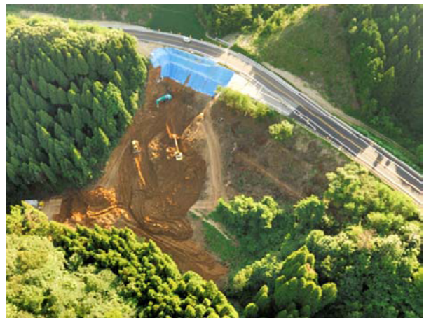
写真-7.2.15 応急復旧及び本復旧状況 (石川県提供) 2)
