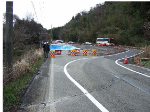
写真-7.2.37 応急復旧状況
