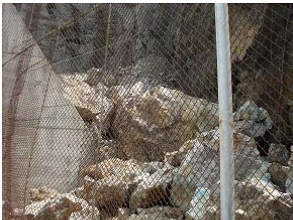
2-e 待ち受け擁壁の背後の状況
