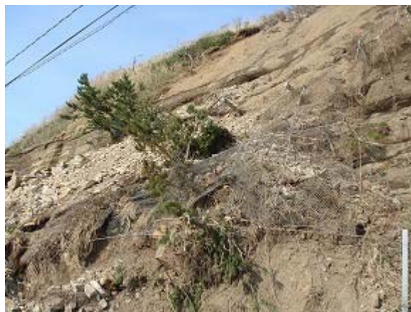
22-b 落石防護ネットの状況
