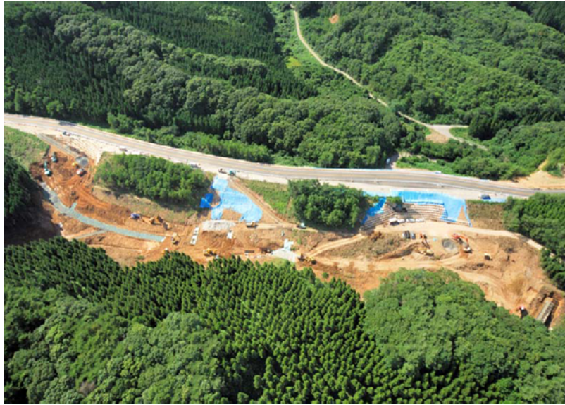
写真-7.2.28 応急復旧及び本復旧状況（能登有料 穴水町越の原その2 21.5～21.7kp 縦-39）（石川県提供） 2)
