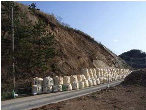
13-a 斜面左側の状況
