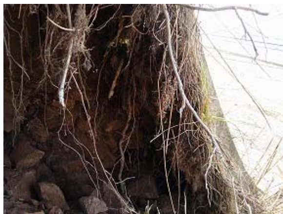
11-d のり砕工の裏側の抜け落ち
