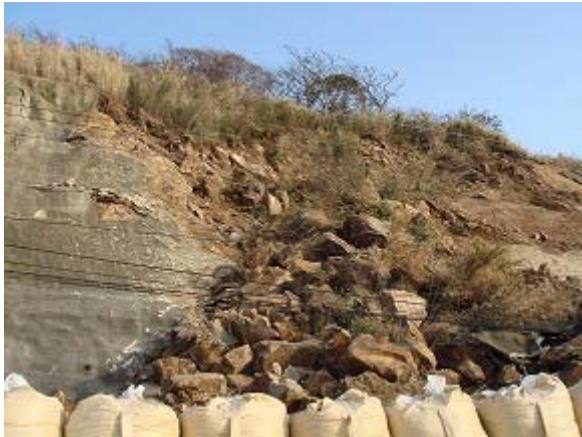
14-c 斜面上部の崩落
