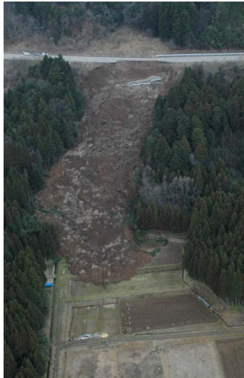
写真-7.2.1 被災箇所の航空写真（七尾市中島町豊田その5 5.6kp 縦-6） （石川県提供） 1)
