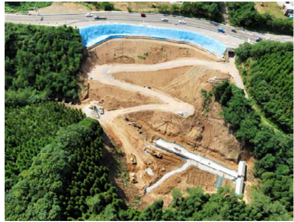
写真-7.2.31 応急復旧及び本復旧状況 (石川県提供) 2)
