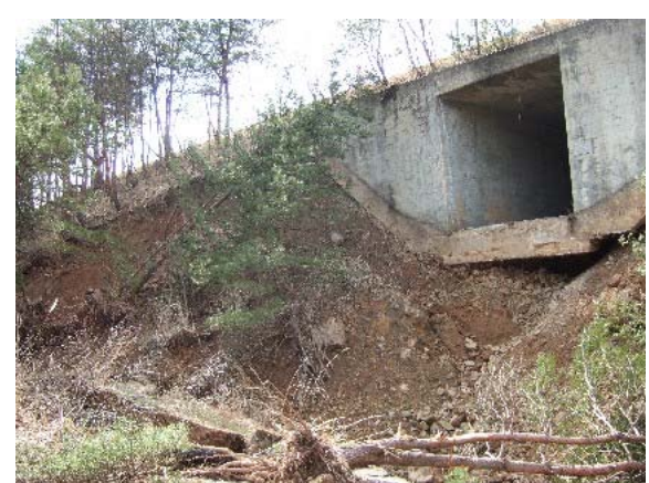
(b) 側道の崩壊状況
