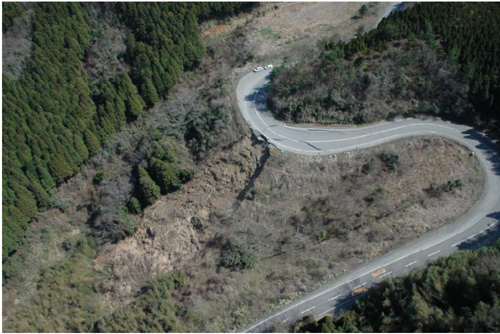
写真-7.2.39 被災箇所の航空写真（国道249号志賀町大福寺）（石川県提供） 4)
