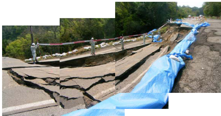
(b) 路面の陥没状況
