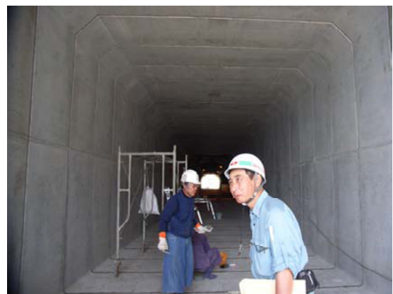
(b) ボックスカルバート内部
