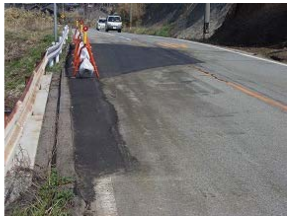
3-c 道路盛土部の補修状況
