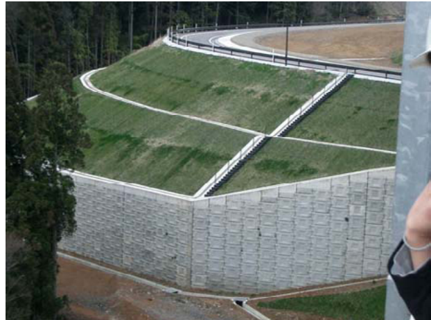
写真-7.2.47 能登有料穴水 IC 多数アンカー
