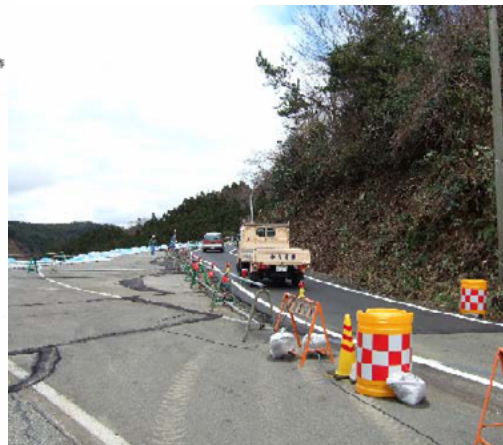
写真-7.2.41 応急復旧状況
