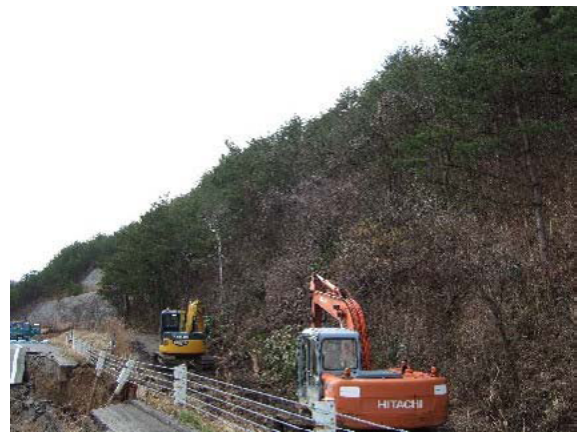
(d) 盛土背後の状況
