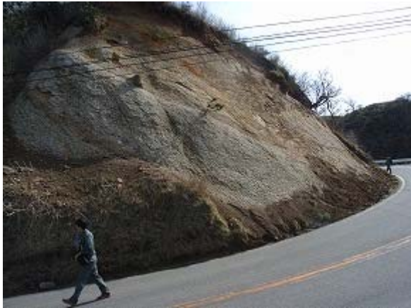
6-a 斜面左側の状況
