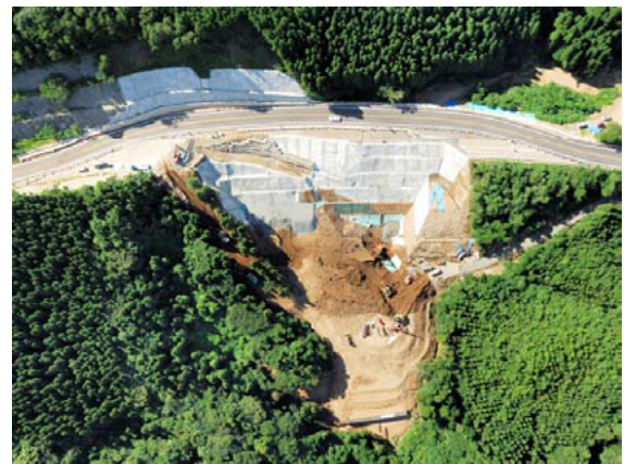
写真-7.2.24 応急復旧および本復旧状況（石川県提供） 2)
