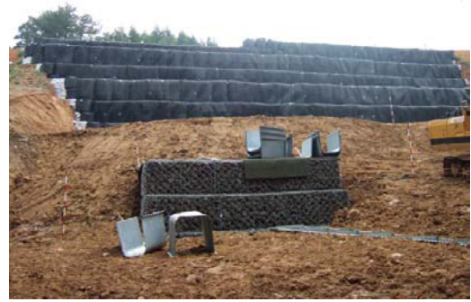
写真-7.2.12 応急復旧状況
