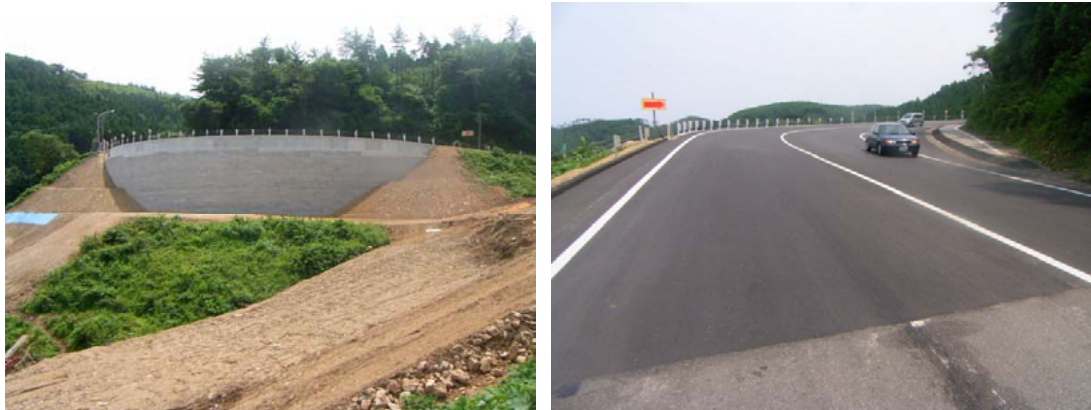
写真-7.2.42 復旧後写真（国道249号志賀町大福寺）（石川県提供） 4)
