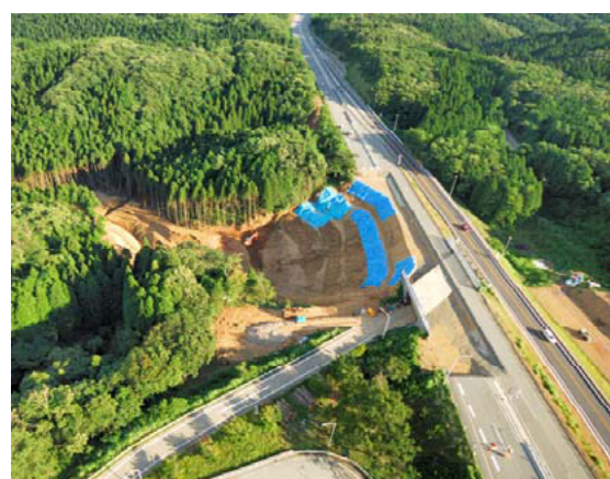
写真-7.2.21 応急復旧及び本復旧状況（石川県提供） 2)
