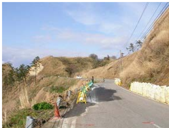
9-b 道路路肩部の補修状況
