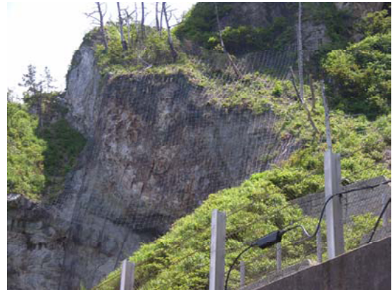
写真-7.3.30 ロープネット（施工後）
