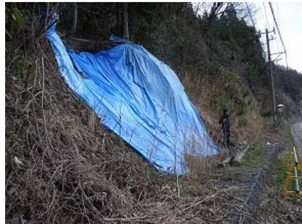
1-b 側方からの状況
