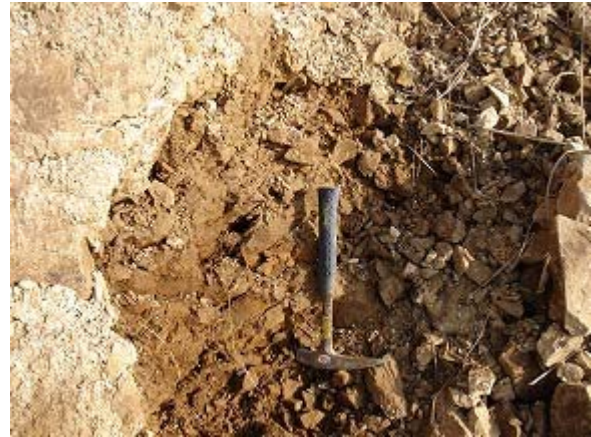
12-b 崩壊面の状態
