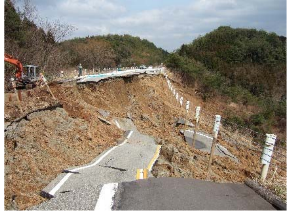
(b) 崩土の状況
