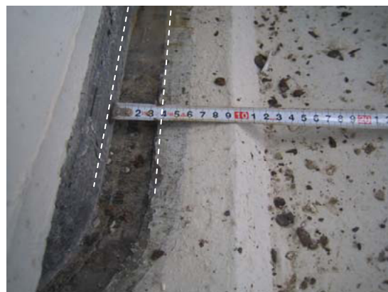
写真-6.15 支承の変位 (P8橋脚)
