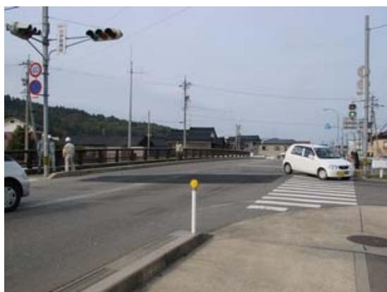
写真-6.39 小伊勢橋全景(橋台背面沈下)
