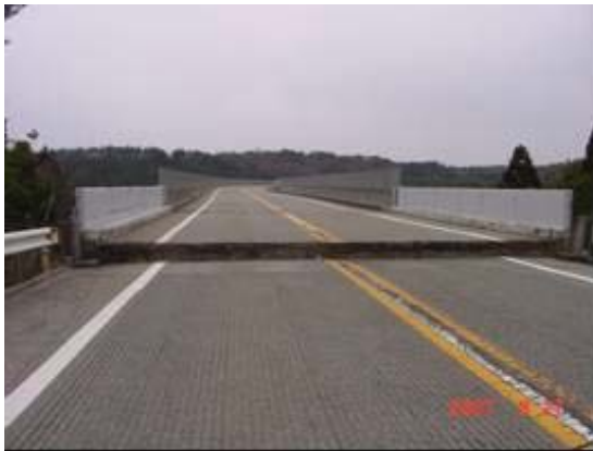
写真-6.19 能登大橋A2(手前土工区間)
