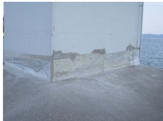
写真-6.9 断面修復後（石川県撮影）
