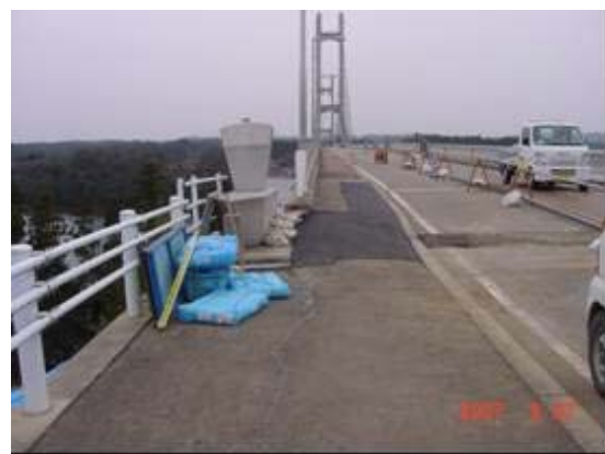
写真-6.17 橋台背面部の応急処置
