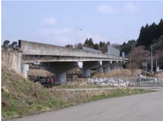
写真-6.33 市ノ坂大橋全景
