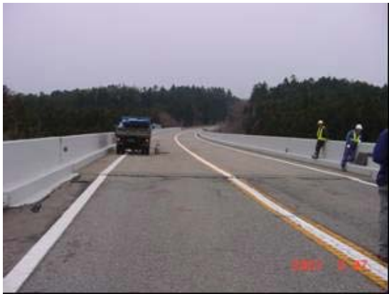
写真-6.24 安津見高架橋(手前土工区間)
