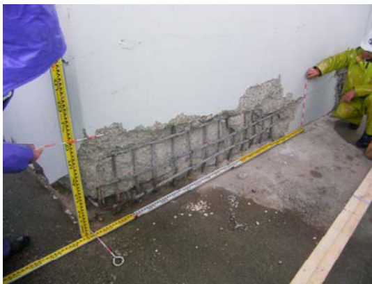
写真-6.8 はつり作業完了後（石川県撮影）
