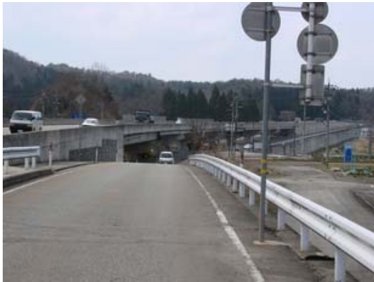
写真-6.36 上町高架橋全景
