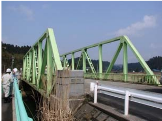
写真-6. 29 白濁橋全景
