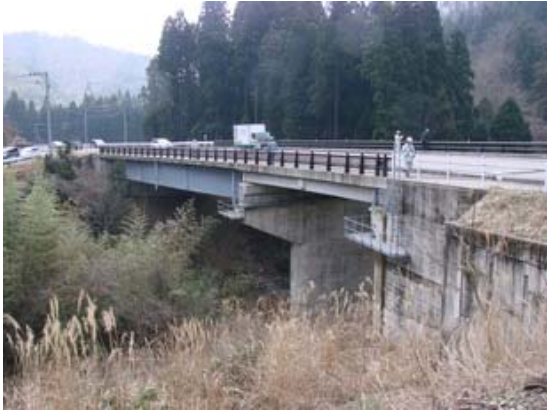
写真-6.31 高瀬橋全景
