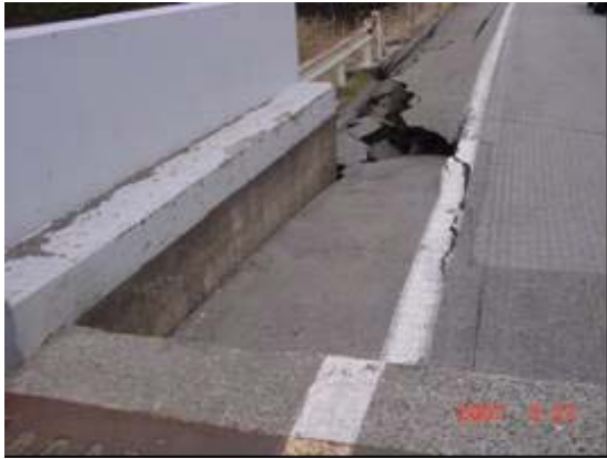
写真-6.22 能登大橋A1(手前構造物区間)
