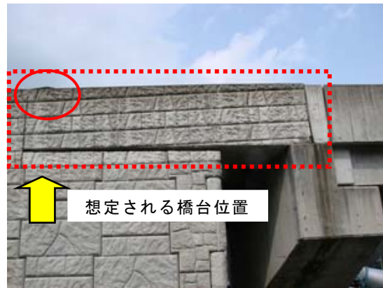
写真-6.37 橋台と端部桁
