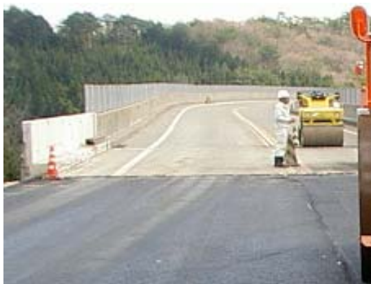
写真-6.21 舗装復旧後(石川県提供)
