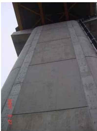
写真-6.26 安津見高架橋橋脚
