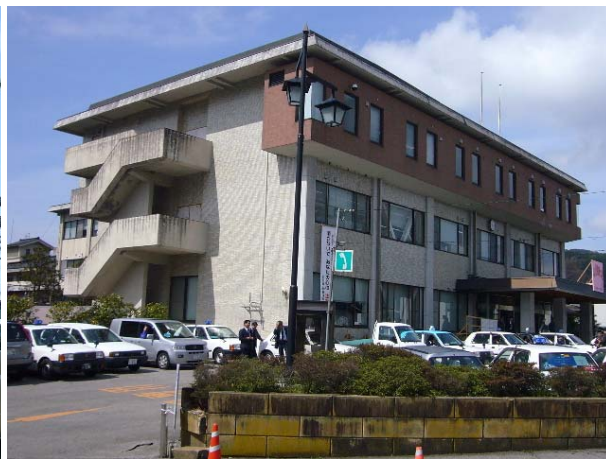
写真-3.6 門前支所概観(南東から)
