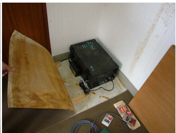
写真-3.4 輪島市役所 4階強震計設置状況
