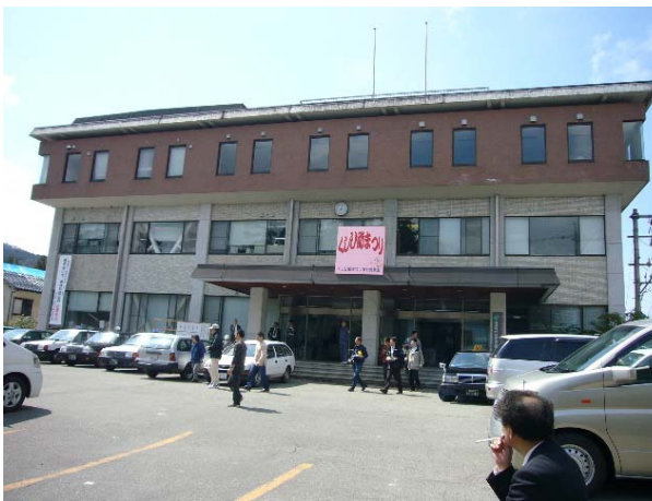
写真-3.5 門前支所概観(東から)
