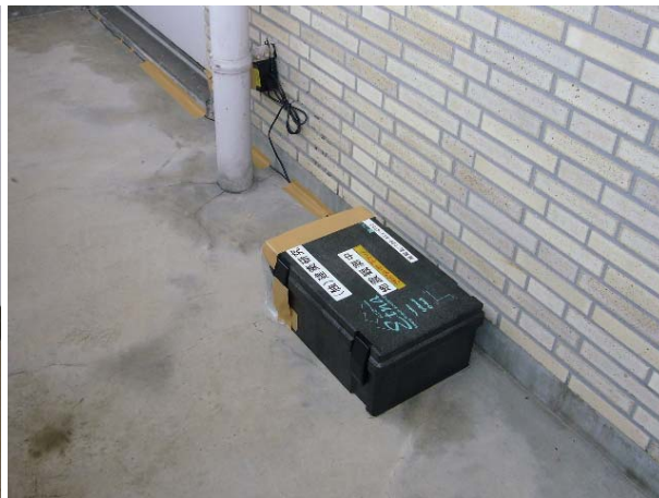
写真-3.8 門前支所3階強震計設置状況
