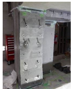
図6 ピロティ試験体の1階柱のUFCパネル補強
