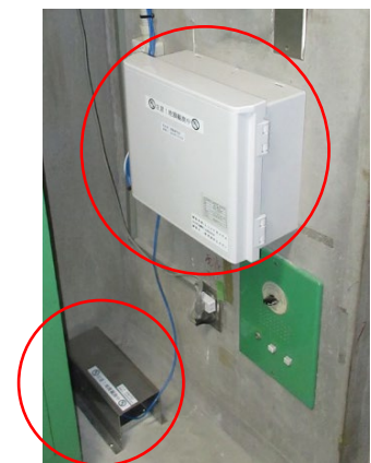
図3 庁舎等への観測機器の設置
