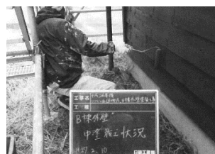
写真 1 木部保護塗料の塗装工事 (浜松市提供)
