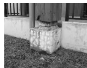
写真 2 外壁の付加工事 (横手市提供)
