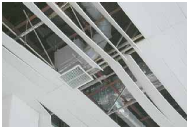
写真-4.31 天井裏の状況
