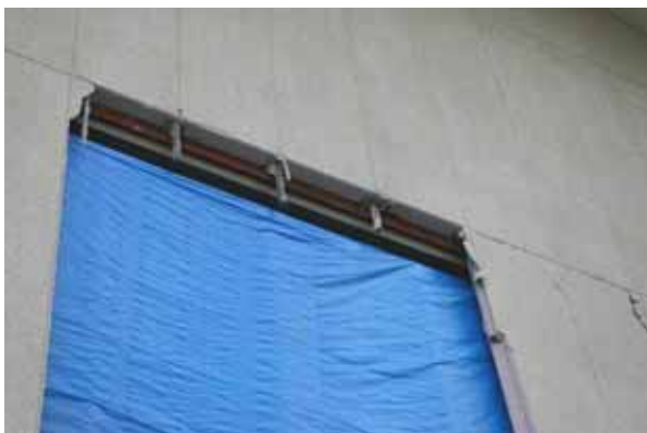
写真-4.11 ALCパネルの上部取付け部
