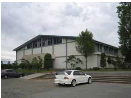
写真-4.5 建物B外観（北西方向より）
