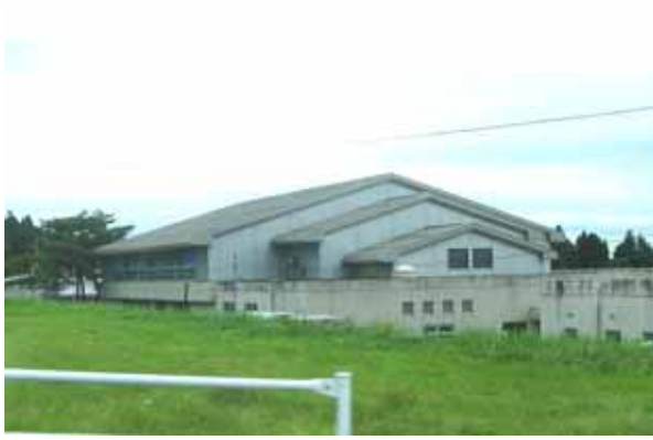
写真-4.15 建物D外観
