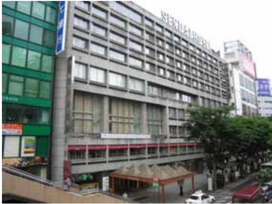
写真-4.1 建物A外観
