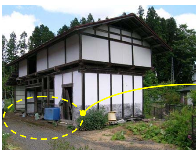
納屋(置き基礎・無被害)
