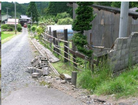
無筋コンクリートブロック塀の倒壊
