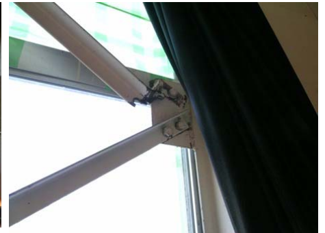
鉄骨ブレース座屈+破断 (全数)
