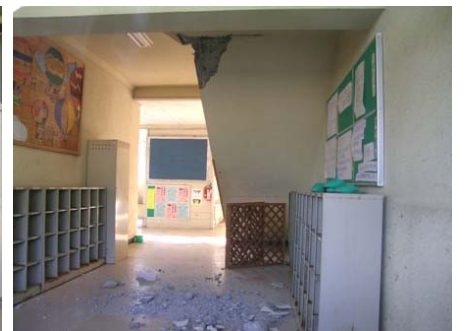
階段部損傷
