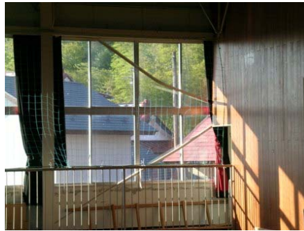
鉄骨ブレース座屈+破断 (全数)
