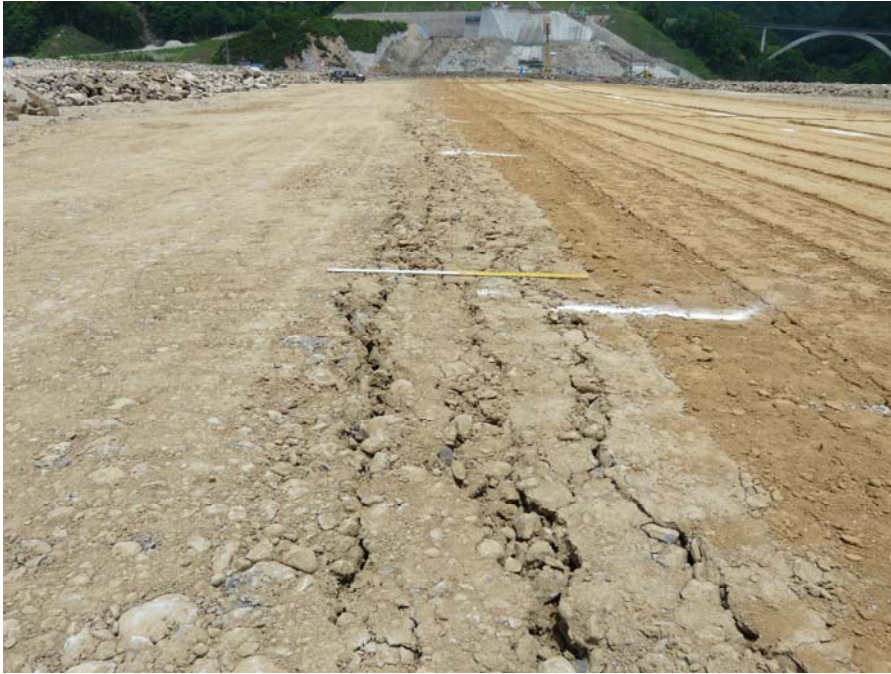
堤体盛立面に生じた亀裂
