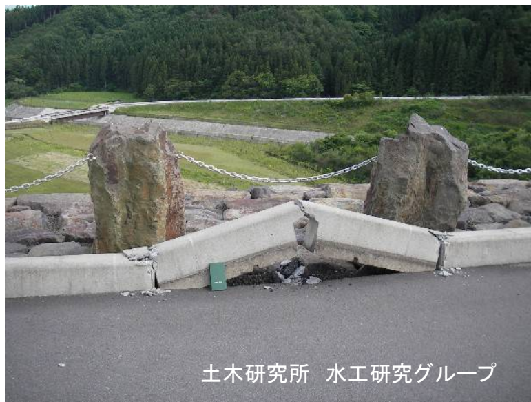
天端舗装の縁石の損傷
