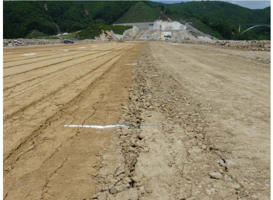
堤体盛立面に生じた亀裂
