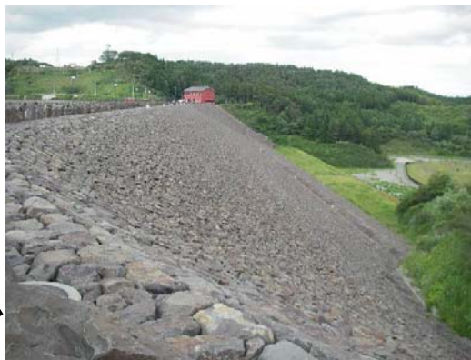
堤体上下流面に変状見られない
