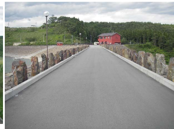
堤体天端舗装面に 変状見られない
