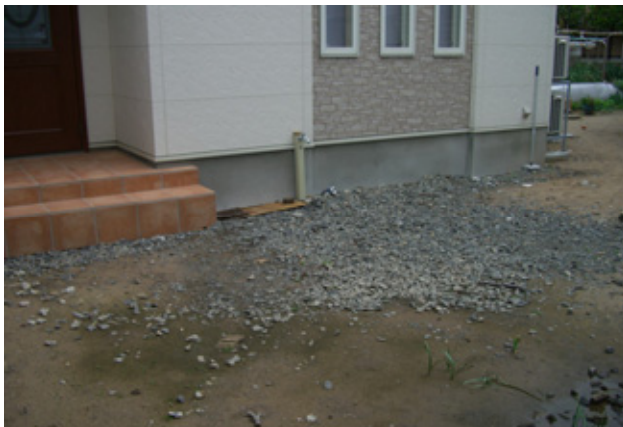
写真-8 ブロック基礎による増築部の被害 土台基礎の外周に設けたブロック基礎の増築部 ブロック基礎が破壊して外壁等が沈下し、上部構造の変形を増大させたと考えられる例
