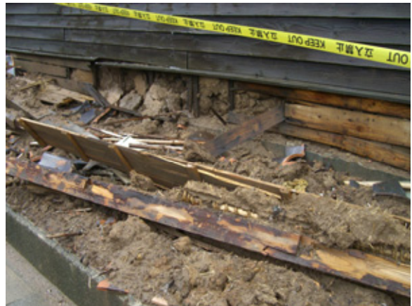
写真-5 土台から上部の建物被害 (土台から上部の建物の変形と外壁の破損など)
