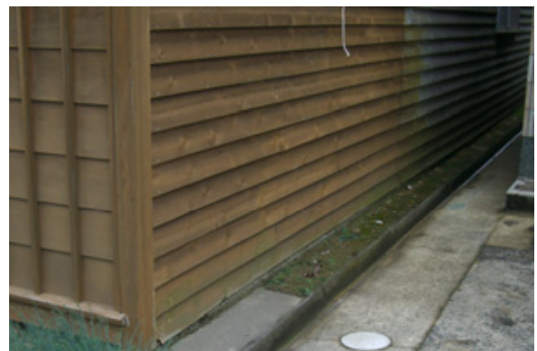
写真-2 地上での立ち上がり部分がほとんどない古い土台基礎 (地表面付近に切石などを設け、地表面から数 cm ほど上部に木質土台を置く基礎形式)
