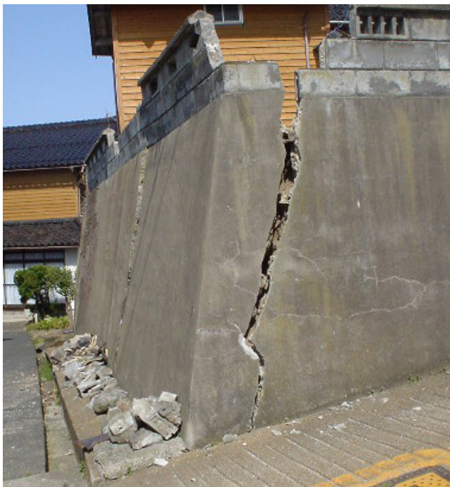
空石積み+表面コンクリート、高さ約 2m
