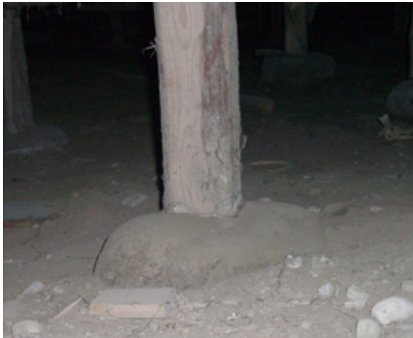
写真-4 土台基礎やブロック基礎を用いた住宅の建物内部の束基礎など
