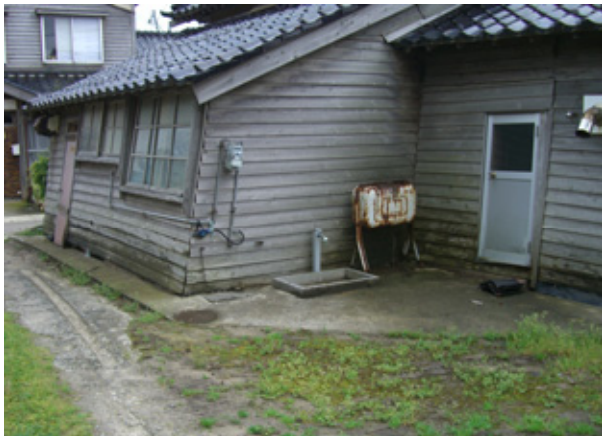
写真-5 土台から上部の建物被害 (土台から上部の建物の変形と外壁の破損など)
