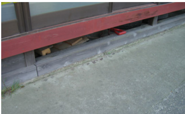
写真-2 地上での立ち上がり部分がほとんどない古い土台基礎 (地表面付近に切石などを設け、地表面から数 cm ほど上部に木質土台を置く基礎形式)
