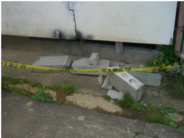
写真-8 ブロック基礎による増築部の被害 土台基礎の外周に設けたブロック基礎の増築部 ブロック基礎が破壊して外壁等が沈下し、上部構造の変形を増大させたと考えられる例
