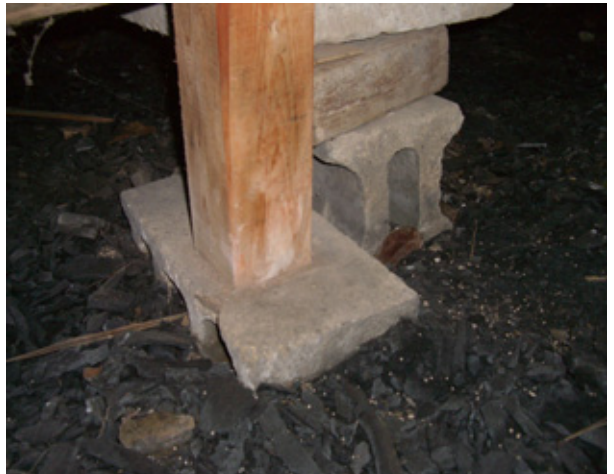
写真-4 土台基礎やブロック基礎を用いた住宅の建物内部の束基礎など
