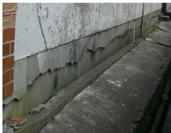
写真-6 ブロック基礎の被害例 (ブロックや土台の外周をモルタル等で覆って無筋コンクリートと区別が難しい場合もある)
