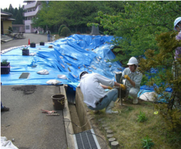
写真-23 谷埋め盛土の崩壊地における地盤調査
