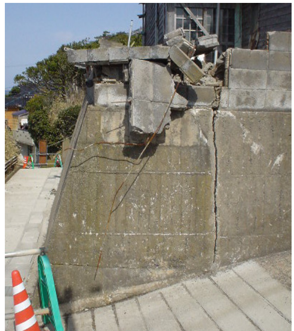
重力式（無筋、頂部は増積み）、高さ約 2～3m
