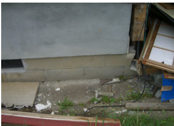
写真-6 ブロック基礎の被害例 (ブロックや土台の外周をモルタル等で覆って無筋コンクリートと区別が難しい場合もある)
