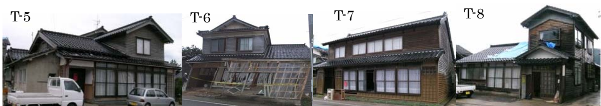
写真 1 詳細調査対象物件の外観
