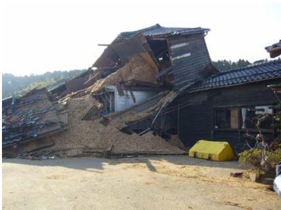
写真 5.1 倒壊したチップ工場
