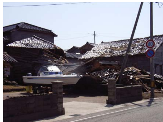
写真 5.34 倒壊した納屋又は倉庫
