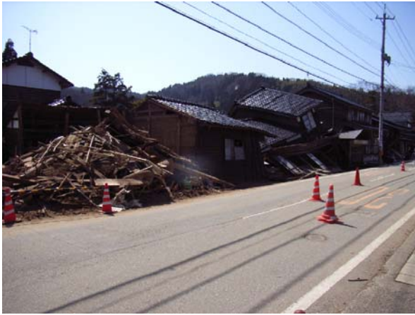
写真 5.13 倒壊家屋が建ち並ぶ駅前地区
