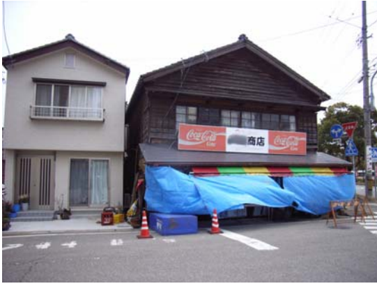
写真 5.39 倒壊した店舗
