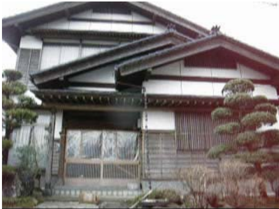
写真 5.43 外観上被害が軽微な建物
