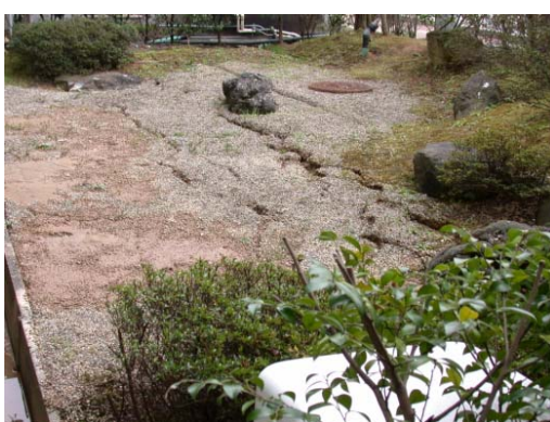
写真 8.8 震度計の周囲の地盤の液状化
