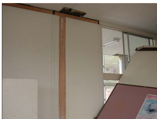
写真 7.7 間仕切り壁の接合部（固定冶具なし）
