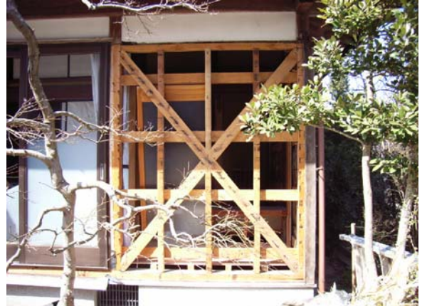
写真 5.24 左の民家の筋かい
