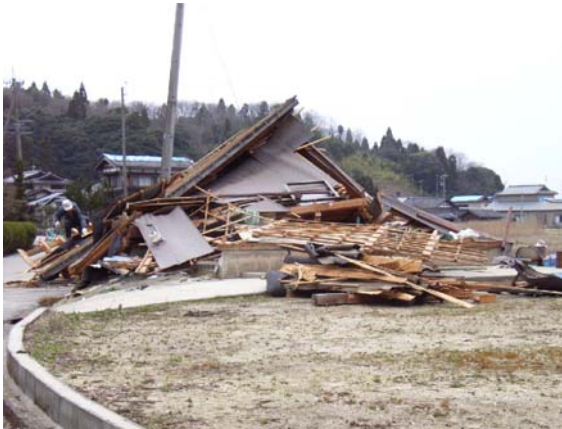
写真 5.51 倒壊した作業所または倉庫
