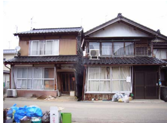
写真 5.44 衝突して外側へ傾いた建物
