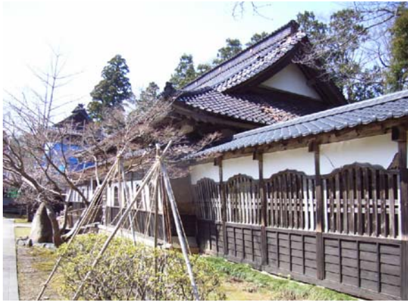
写真 5.19 被害が大きい山門左奥の建物
