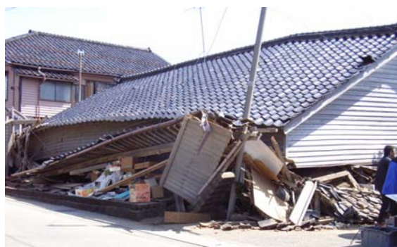
写真 5.27 比較的新しい構法と想像される倒壊家屋
