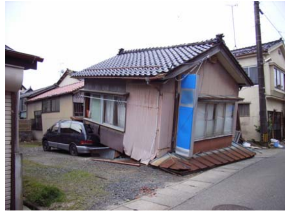
写真 5.40 倒壊し車両をつぶした家屋
