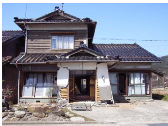
写真 5.25 外装、建具が大破した建物
