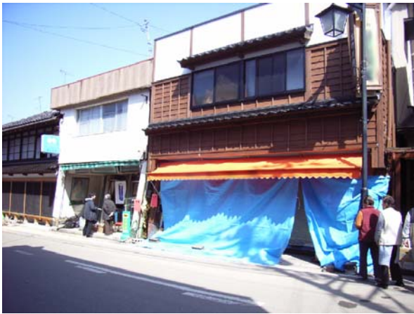
写真 5.21 大きな被害を受けた店舗併用住宅
