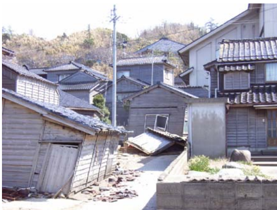
写真 5.33 黒島地区の海岸付近の町並みと倒壊建物
