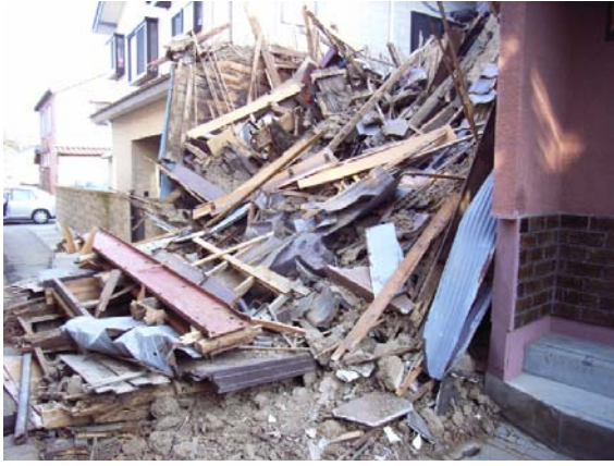
写真 5.3 鳳至地区で選択的に倒壊した家屋
