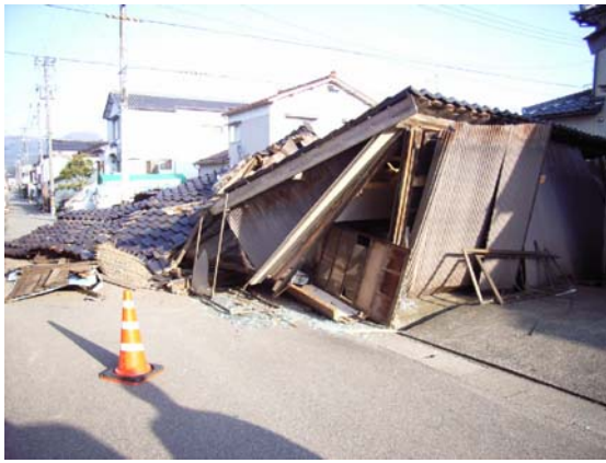
写真 5.7 1階車庫か倉庫の建物の倒壊
