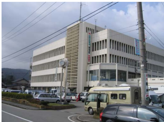
写真 6.1 輪島市役所（RC 造 4 階建て） （建物無被害、周辺地盤の隆起・ひび割れ）
