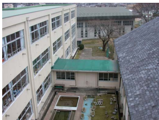
写真 6.8 校舎棟と講堂をつなぐ廊下(EXP.Jなし)
