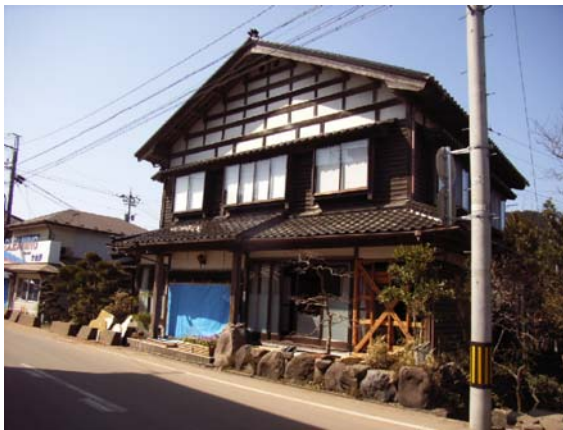
写真 5.23 被害は受けたが残留変形小の民家
