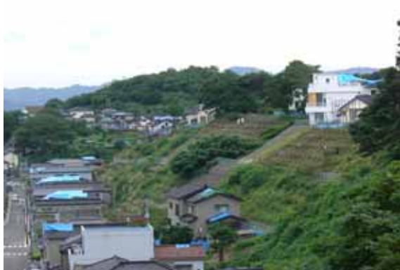
写真-7.1.1 海側からみた崖周辺の状況
