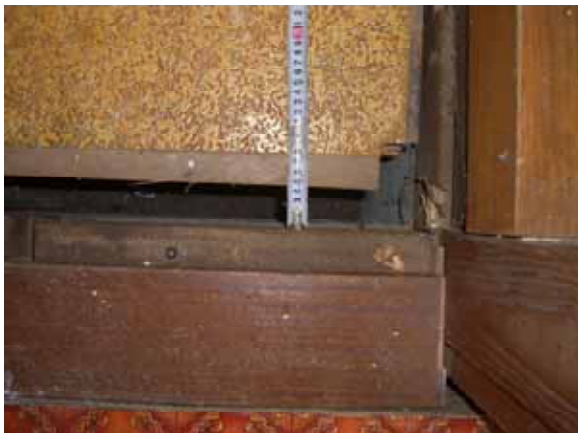
写真-8.1.2 基礎等の被害
