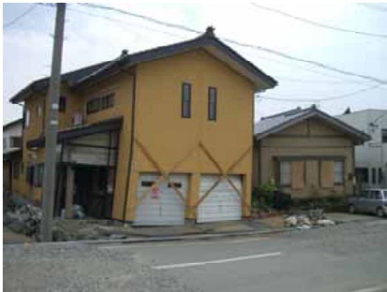
写真-6.2.1 柏崎市松波地区の液状化被害
