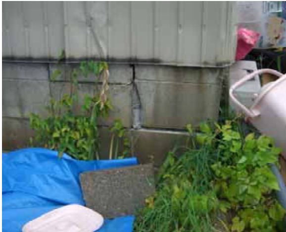
写真-6.4.1 ブロックや束などの古い基礎の被害
