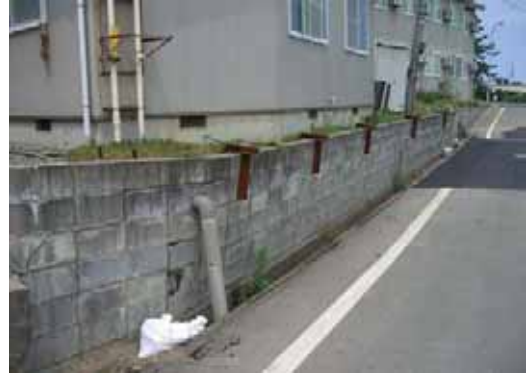
写真-8.2.3 液状化による木造建物の被害状況 (基礎形式：直接基礎、数十 cm の不同沈下)
