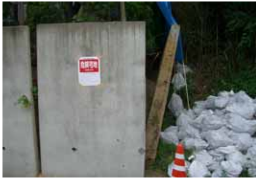
壁高 2m 程度の L 型擁壁
