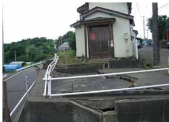
写真-7.1.2 山側の被害宅地の状況 (擁壁背面地盤の沈下・変形)
