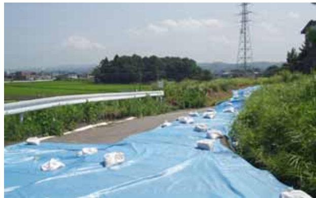
擁壁上部 団地内外周道路
