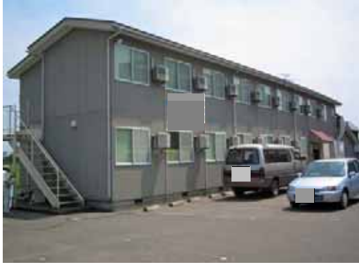
写真-8.2.3 液状化による木造建物の被害状況 (基礎形式：直接基礎、数十 cm の不同沈下)
