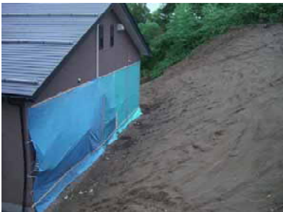
写真-7.1.1 砂丘斜面の崩壊による住宅の外壁等の破壊例
