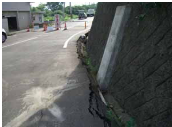
写真-7.4.4 山本団地における擁壁の被害例
