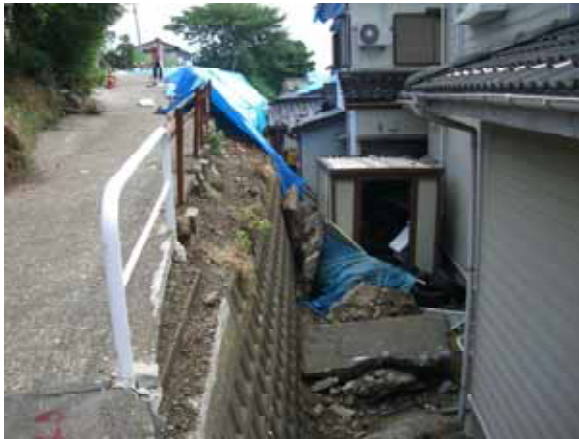
擁壁手前側（高さ 2m）の状況
