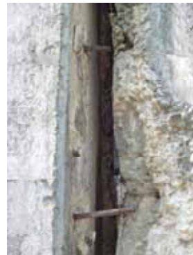
擁壁接合部の状況
