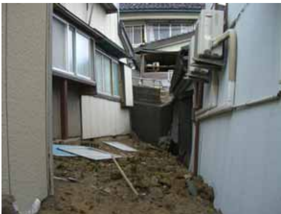
写真-8.3.1 種々の擁壁の被害例
