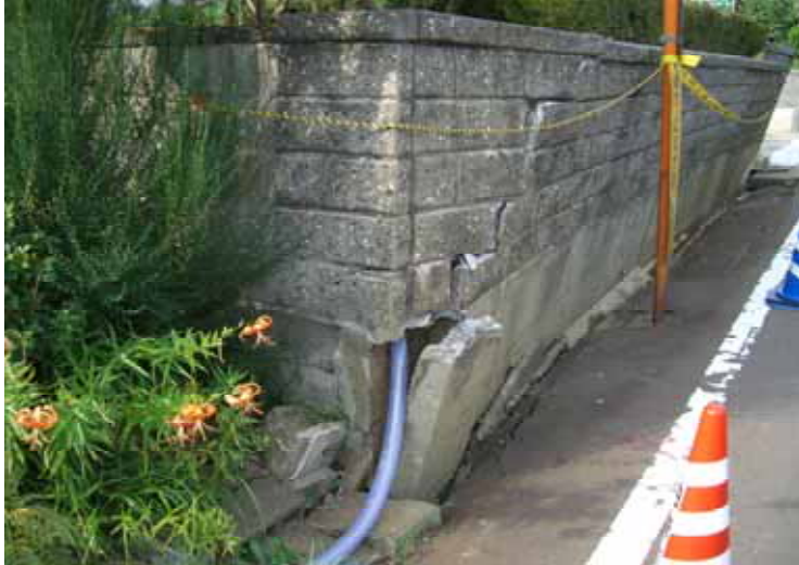
写真-8.3.2 種々の擁壁の被害例
