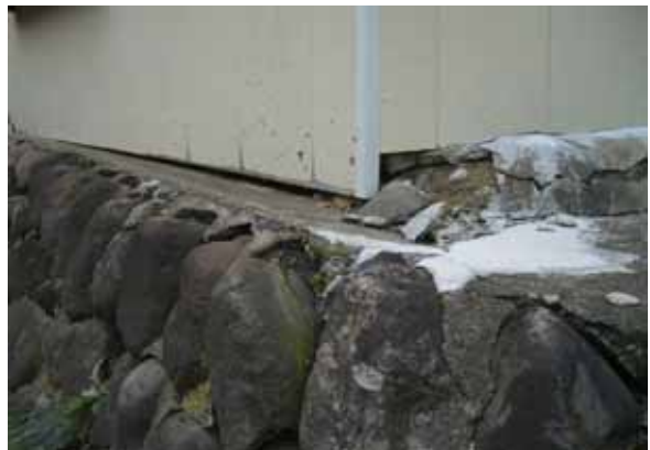
写真-8.1.1 基礎構造の被害例 (コーナー部に集中しやすい被害)
