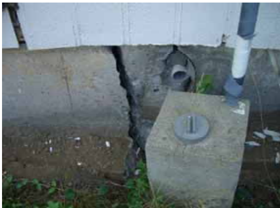
写真-8.1.1 基礎構造の被害例 (コーナー部に集中しやすい被害)
