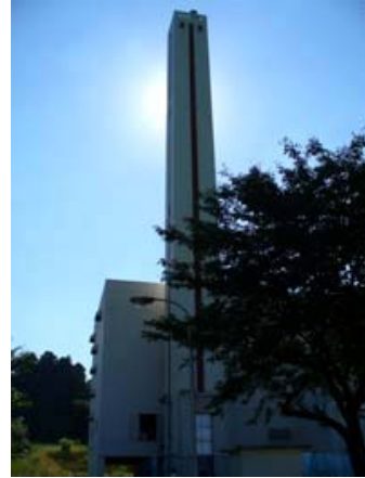
写真-6 小千谷市時水にある塔状工作物
