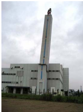
写真-1 柏崎市橋場にある塔状工作物(自立型煙突)の全景
