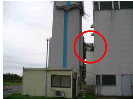
写真-3 煙突の北側面 (水平煙道)
