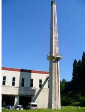
写真-5 長岡市小国町武石にある塔状工作物
