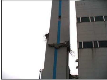
写真-2 煙突の北側面 (写真-1の右側面)
